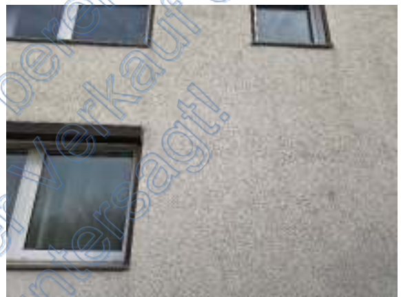
Leichte Putzrisse an der Fassade
