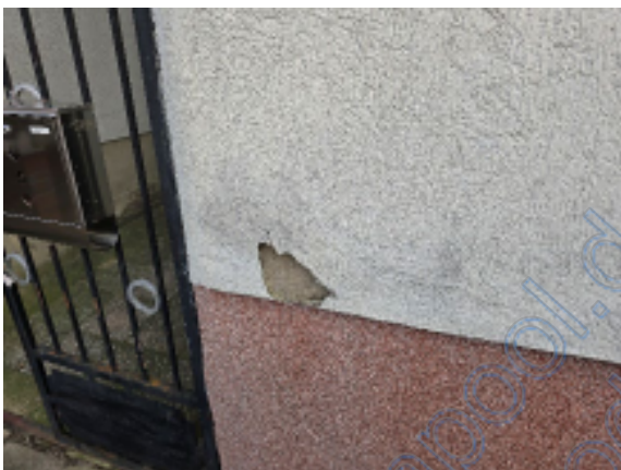
Putzschäden an der Fassade
