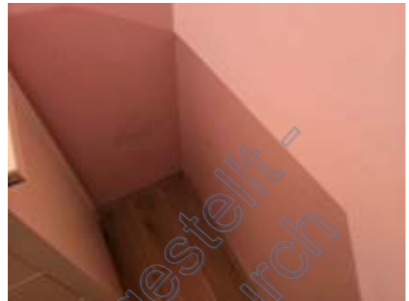
Kleine Feuchteflecken an Innenwand
