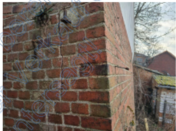
Riss und Auswölbung in der Stützmauer
