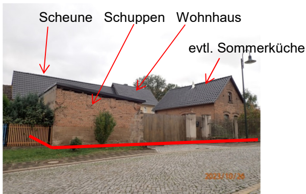
Ansicht von der Straße Am Lauskehügel Blick in etwa Richtung Südwesten
