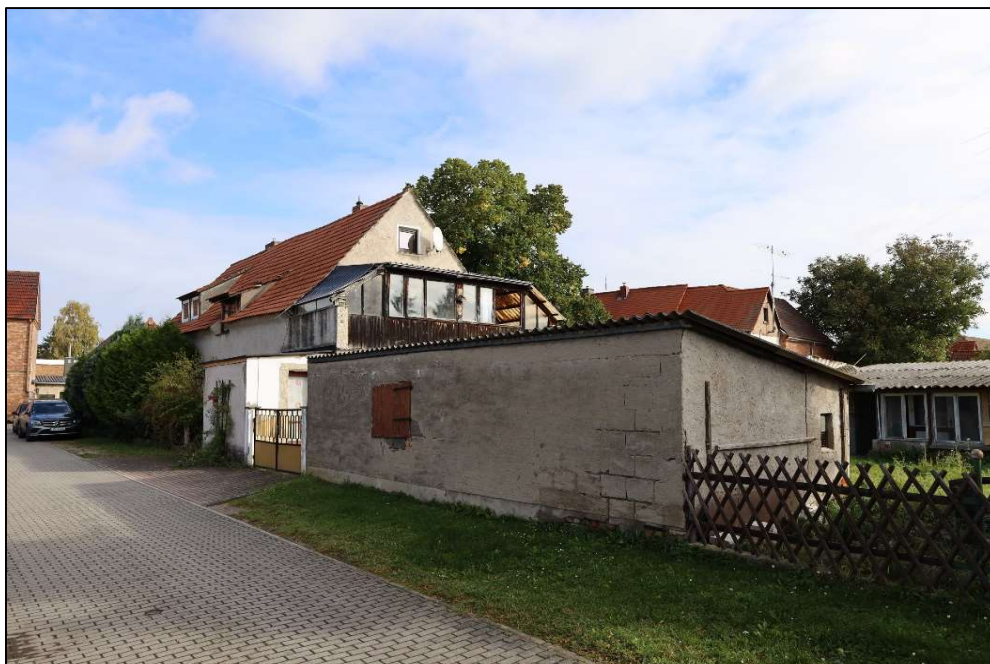
Südwestansicht - Wohn- und Geschäftshaus
