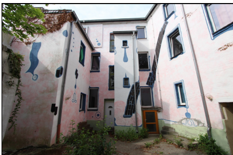
Ansicht des Wohnhauses vom Hof aus
