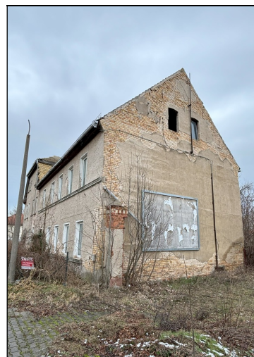
Ansicht der südlichen Fassade
