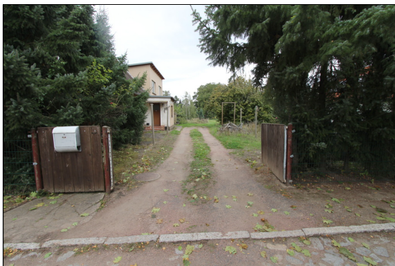
Ansicht des Bewertungsobjektes von der Straße aus
