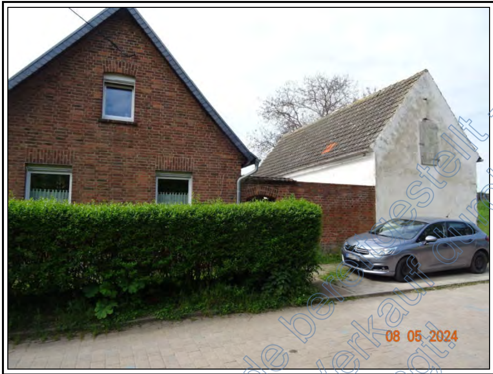
Foto 5: Blatt 864 : südliche Ansichten des Einfamilienhauses und des Schuppens
