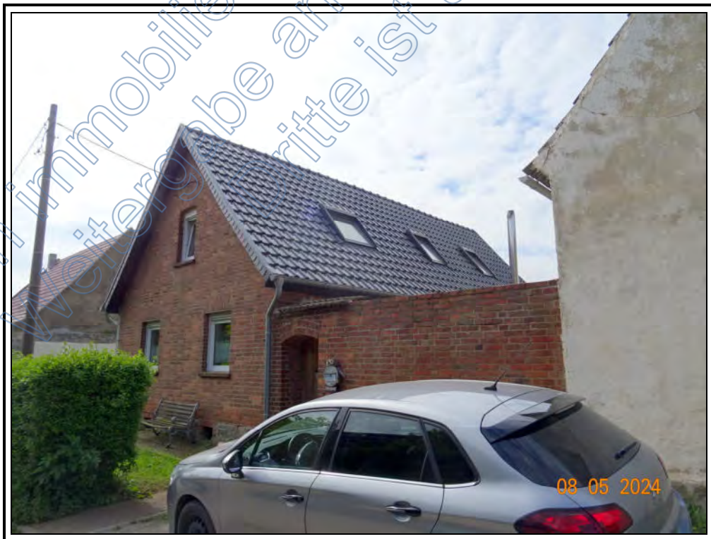
Foto 4: Blatt 864 : nordwestliche Ansicht des Einfamilienhauses
