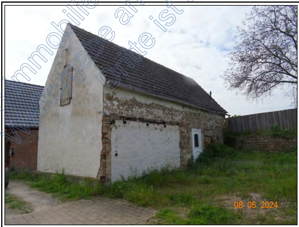
Foto 6: Blatt 864 : nordwestliche Ansicht des Schuppens
