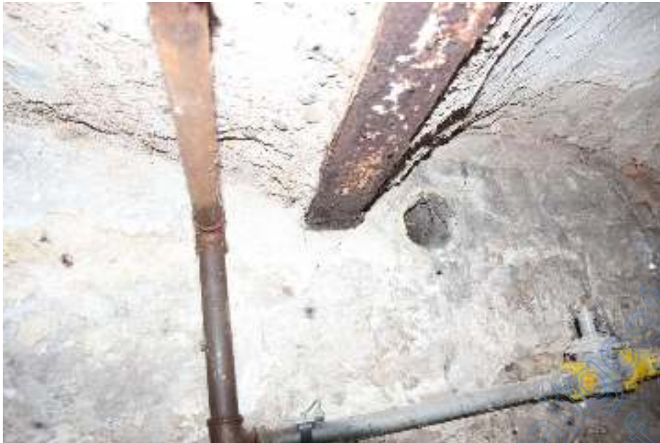
Foto 13 Korrodierter Stahlträger der Kellerdecke
