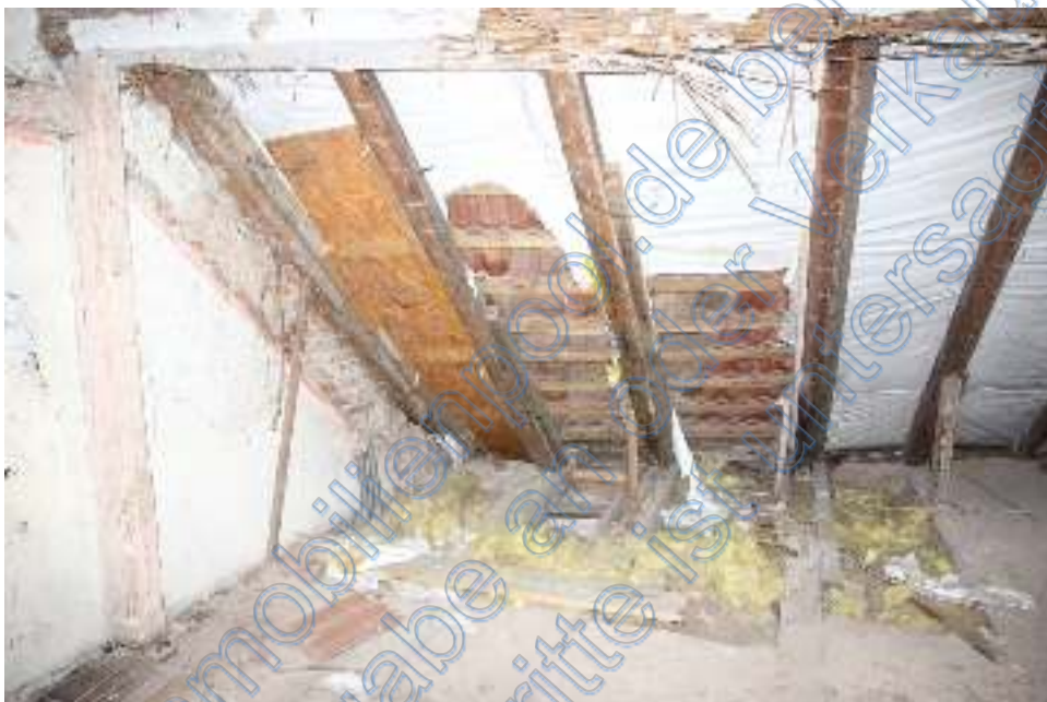
Foto 11 Dachstuhl nach Feuchteschäden notdürftig repariert
