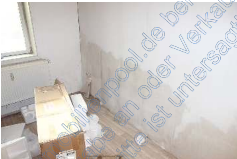
Foto 5 Aufsteigende Wand- feuchte im Erdgeschoss
