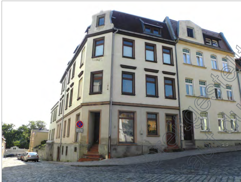
Ansicht des Wohn- und Geschäftshauses von der Theaterstraße
