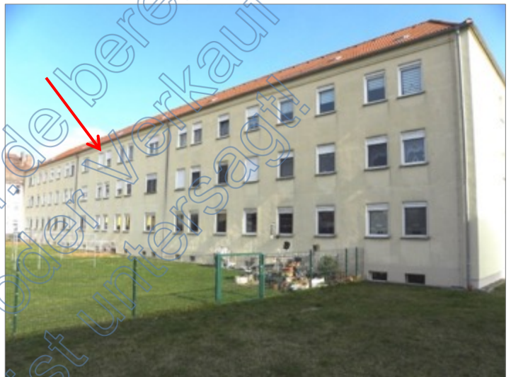
Hinterfront des Mehrfamilienhauses mit rückseitiger Grünfläche und Wäscheplatz; Lage der WE Nr. 4-03-1 im 2. OG rechts des Hauseinganges Nr. 4
