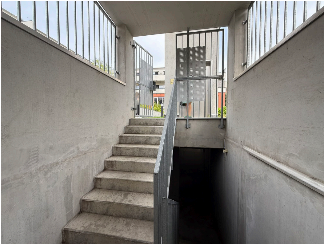
Abgang vom Innenhof zur Tiefgarage
