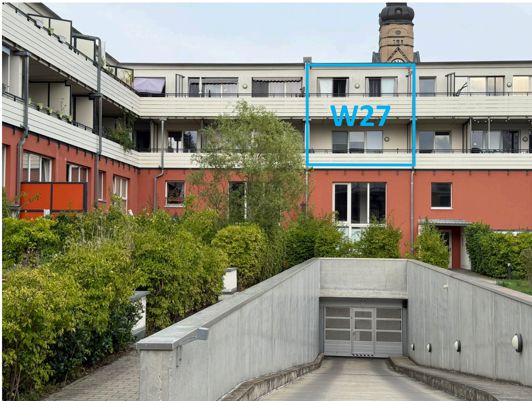
Blick aus westlicher Richtung
