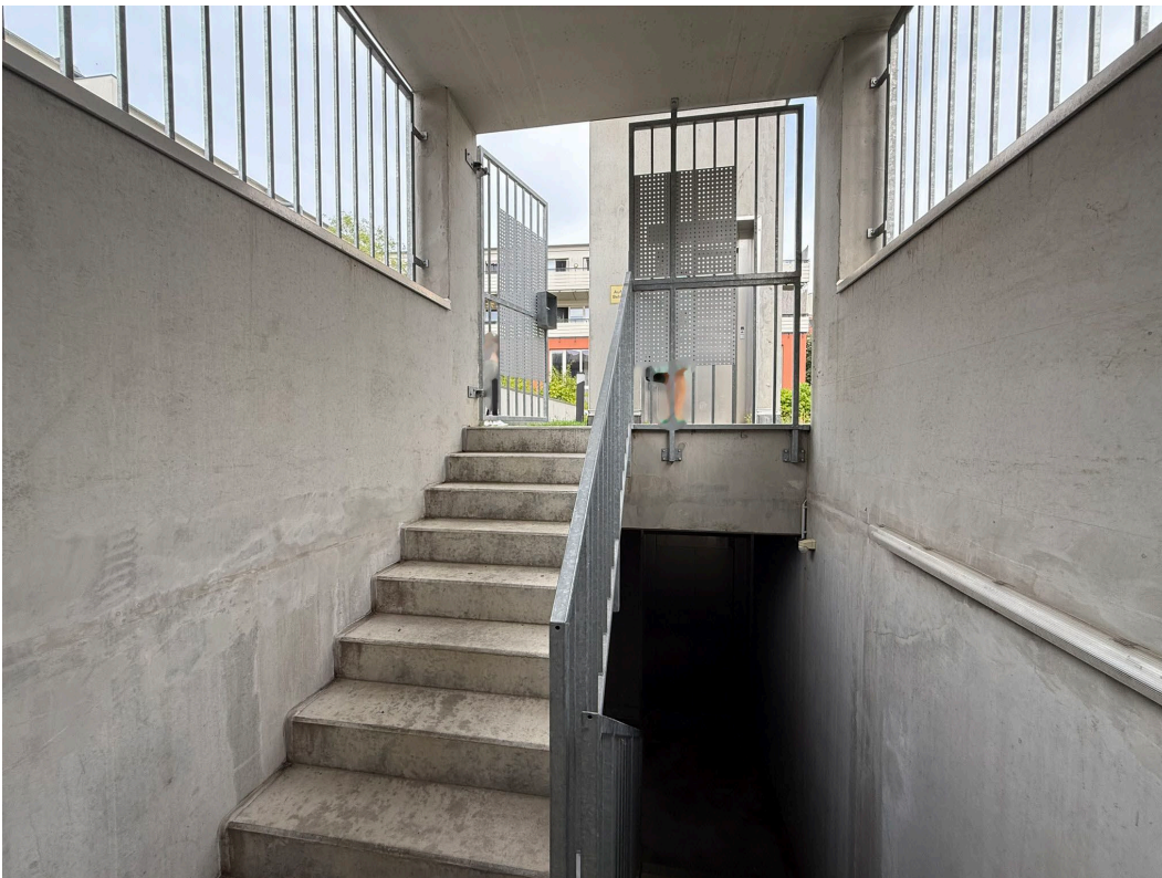
Abgang vom Innenhof zur Tiefgarage
