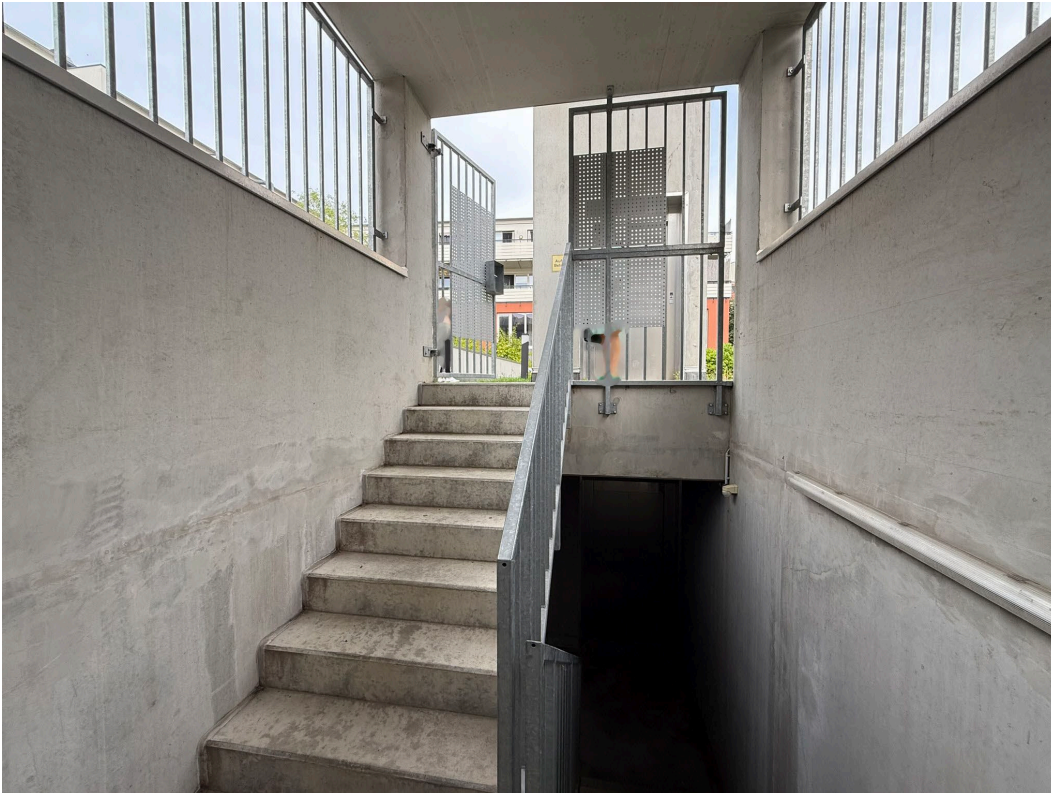
Abgang vom Innenhof zur Tiefgarage
