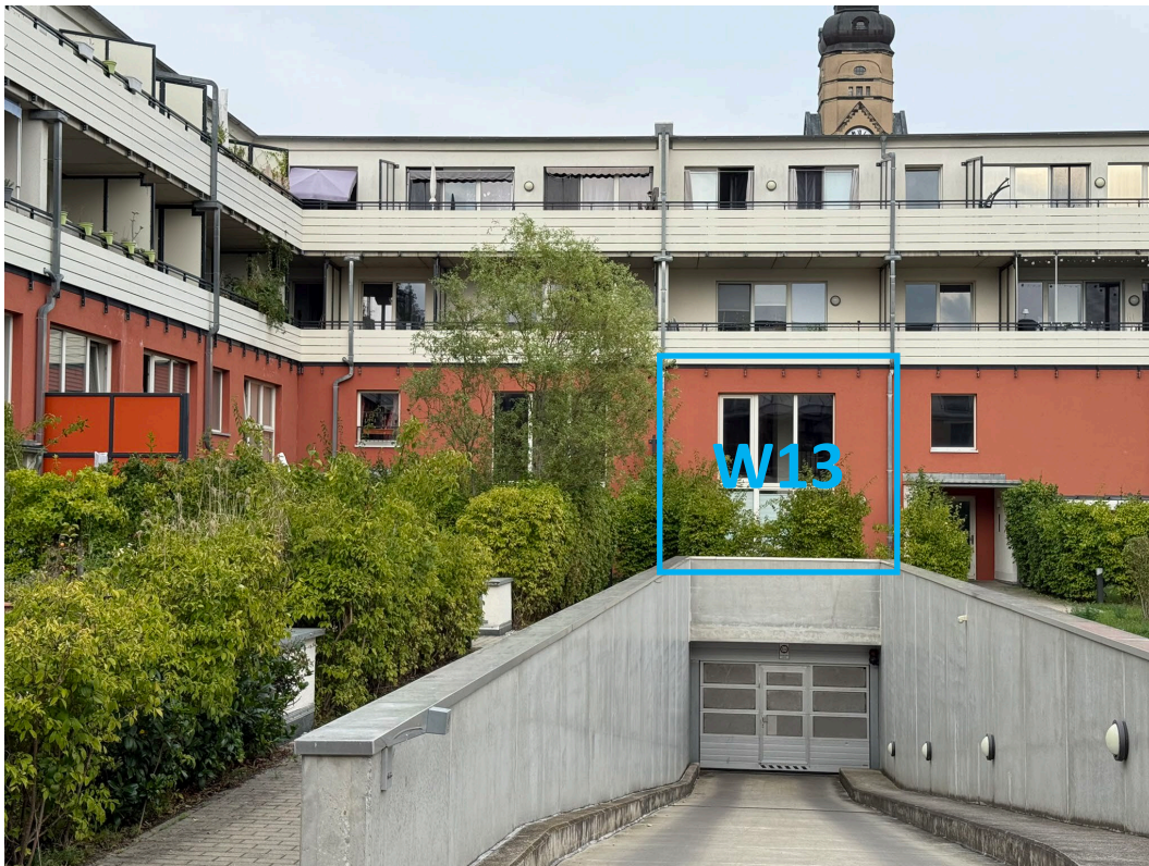
Blick aus westlicher Richtung
