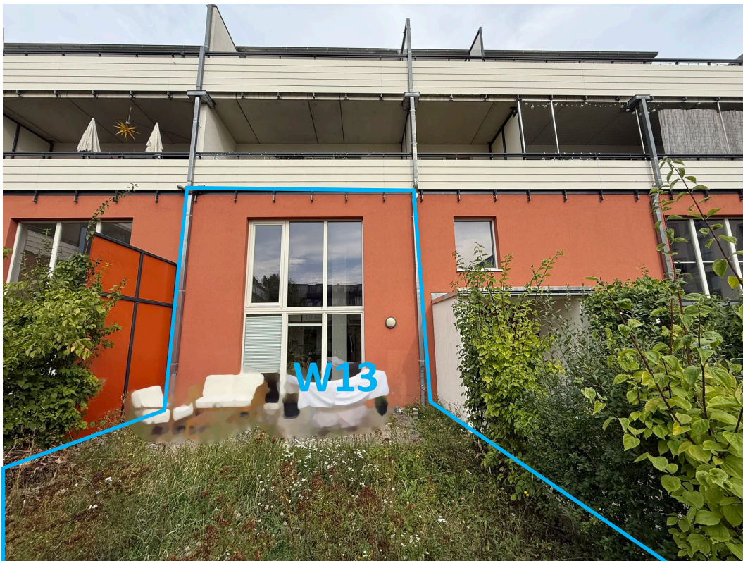
Galeriewohnung mit Sondernutzungsrecht an der Terrassen- und Gartenfläche
