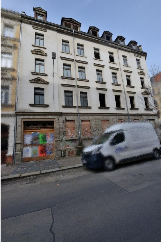
Ansicht Mietshaus von der Wigandstraße aus
