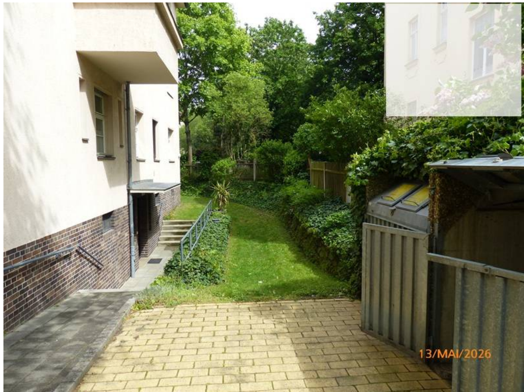
Bereich Häuser Nr. 22 a / 22 b
