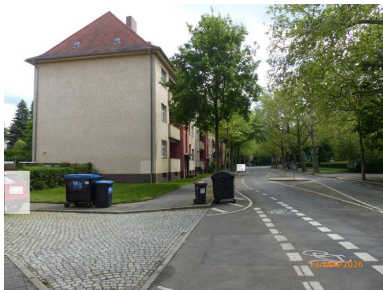
(vorn Schönbachstraße 26 a - Richtung Süden)
