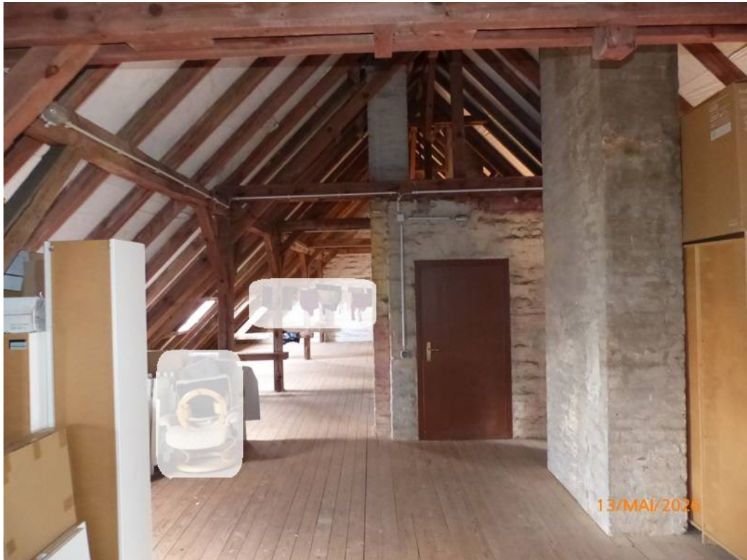
Fotos 18 und 19: Trockenboden im Dachgeschoss (GE)
