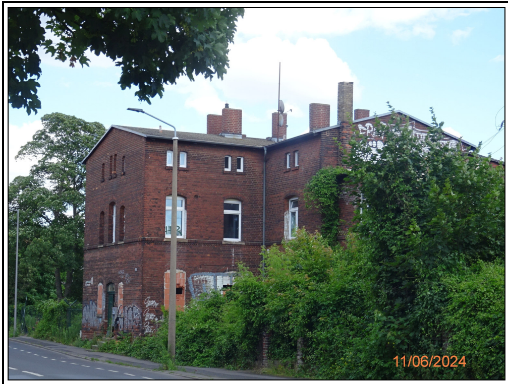
Foto 1: nordwestliche Grundstücksansicht mit dem ehemaligen Eisenbahnerwohnhaus
