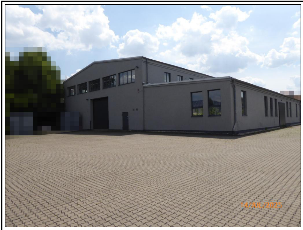
Foto 1: nördliche Ansicht des Hallengebäudes
