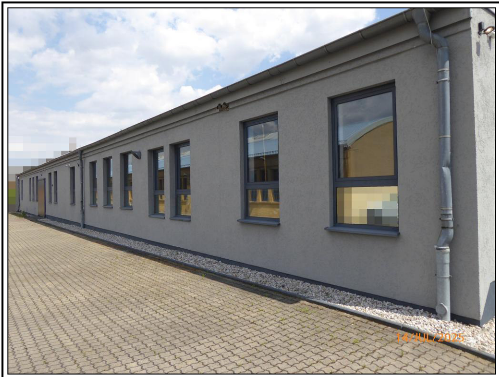
Foto 4: südwestliche Ansicht des Hallengebäudes
