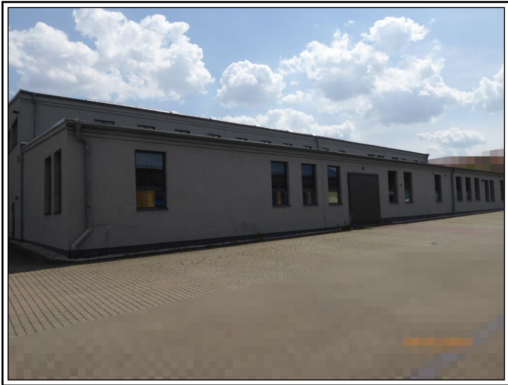
Foto 3: nordwestliche Ansicht des Hallengebäudes
