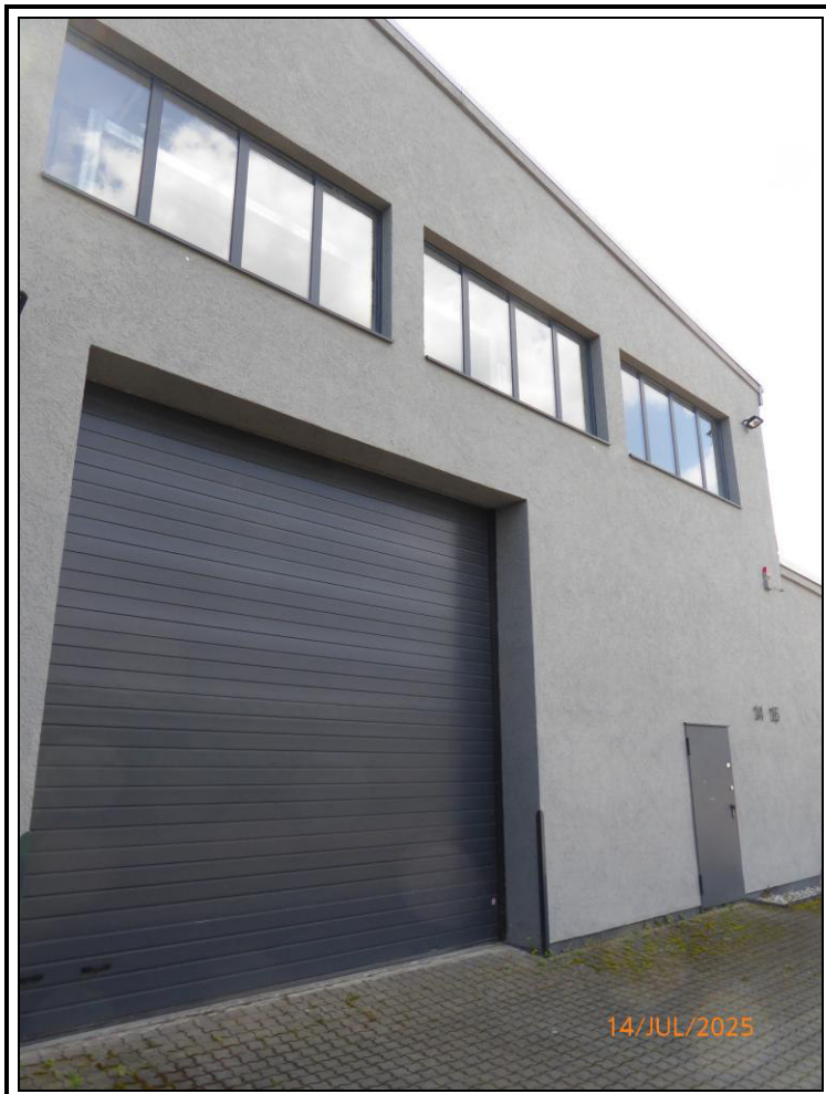
Foto 2: nördliche Teilansicht des Hallengebäudes
