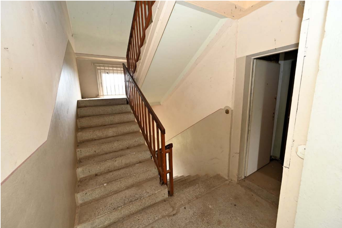
Abb. 51: Treppenhaus Hauseingang 6b, 2. Obergeschoss
