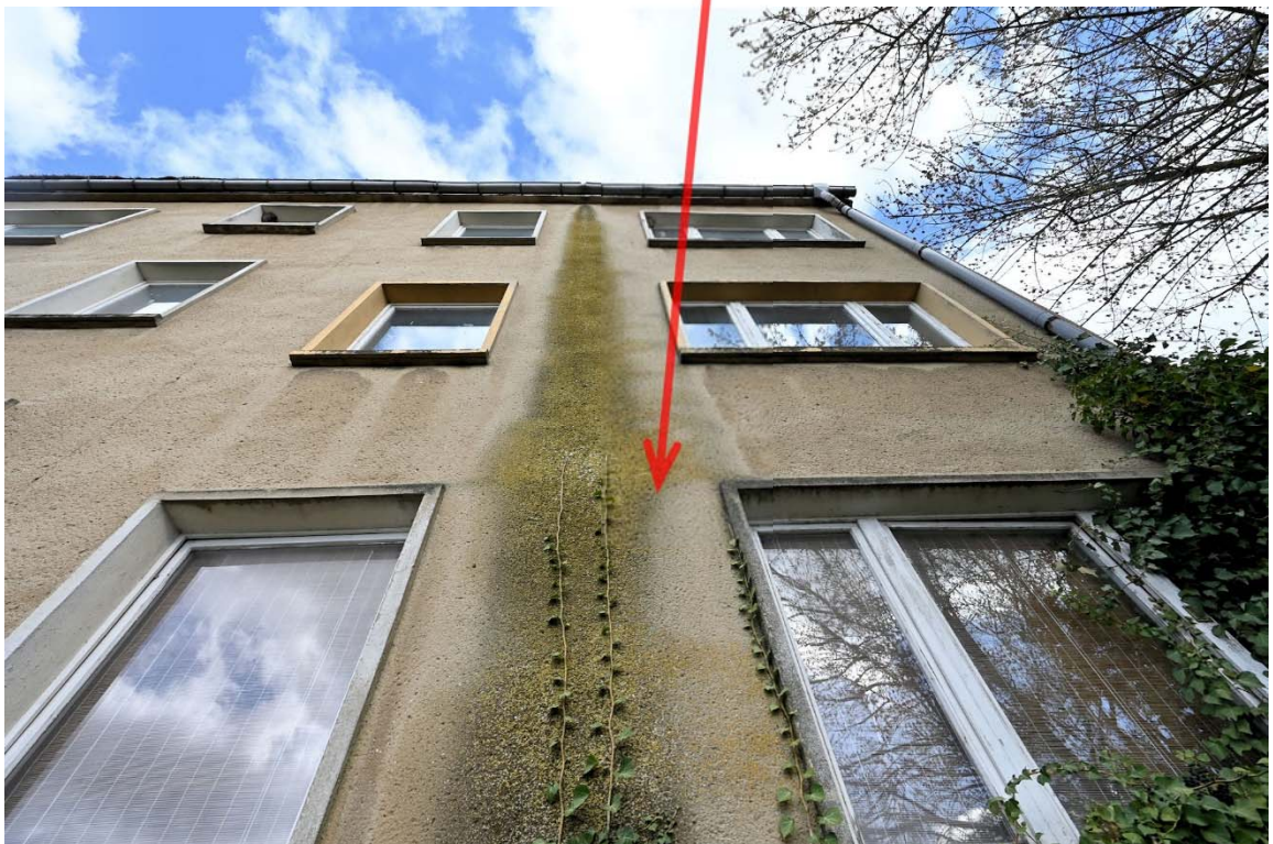
Abb. 6: Gemeinschaftseigentum: Gebäudeansicht, Detail Schäden Dachentwässerung
