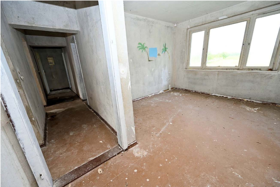
Abb. 23: SE Nr. ④, Wohnraum mit Blick in den Flur
