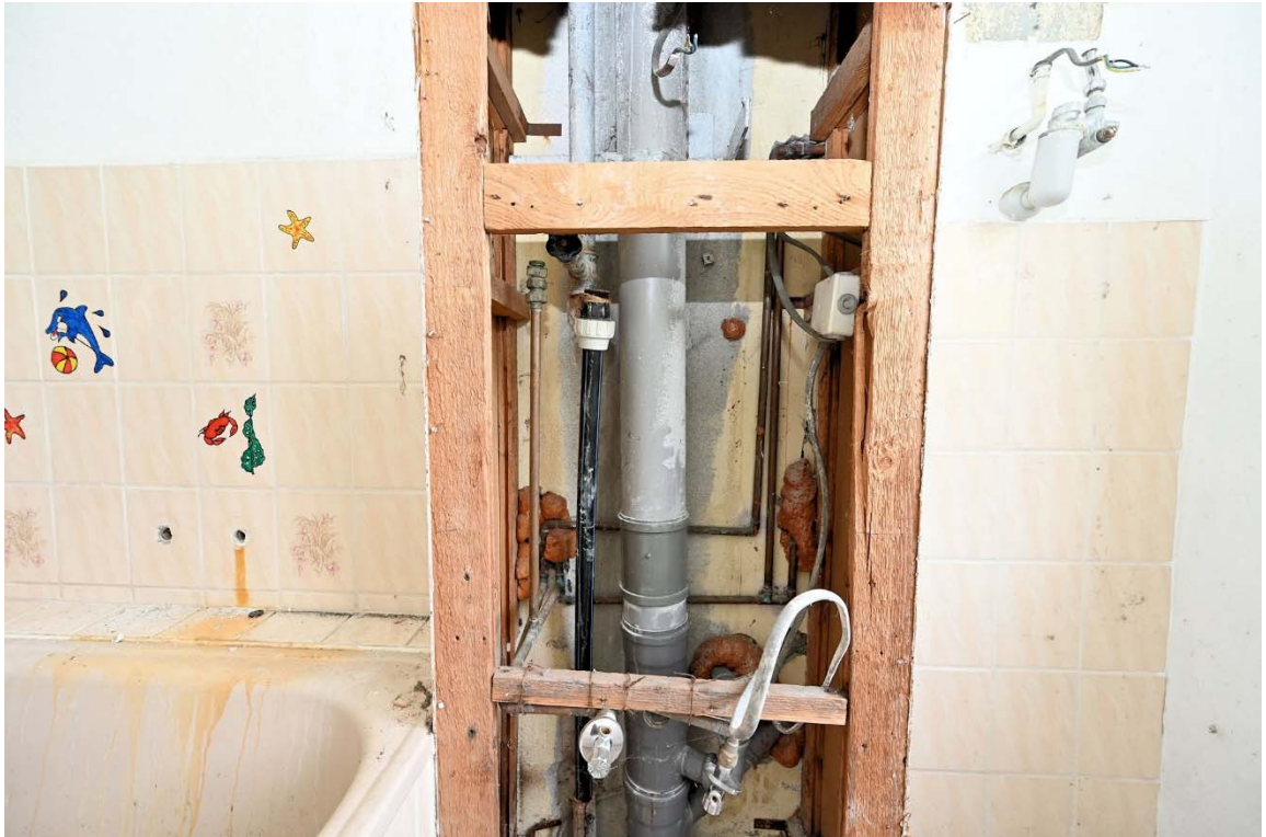
Abb. 13: SE Nr. ①, Bad/WC, Detail Sanitärleitungen
