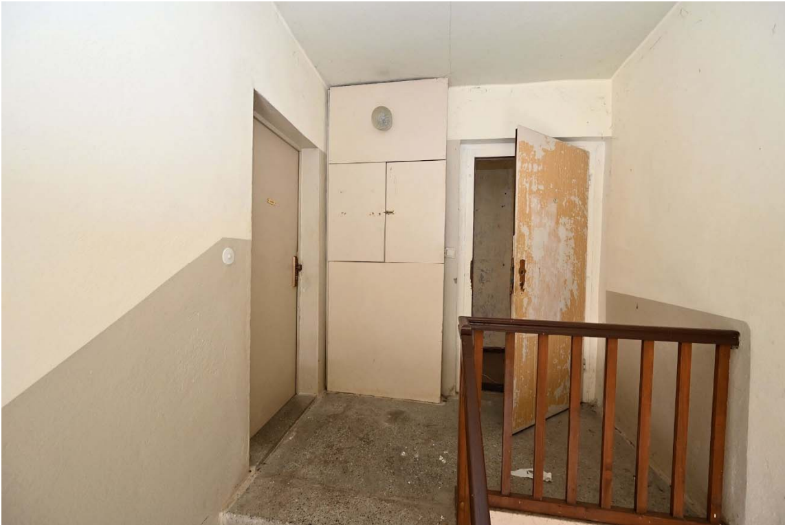
Abb. 35: Treppenhaus Hauseingang 6a, DG, Wohnungseingangstüren zu SE Nr. ⑦ (links) und ⑧ (rechts)
