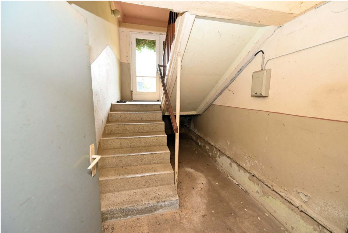
Abb. 7: Gemeinschaftseigentum: Hauseingang 6b, Kellergeschoss
