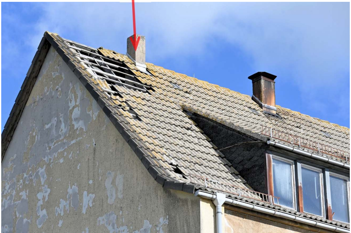
Abb. 2: Gemeinschaftseigentum: Grundstücksansicht von der Kirchgasse, Detail Dacheindeckung
