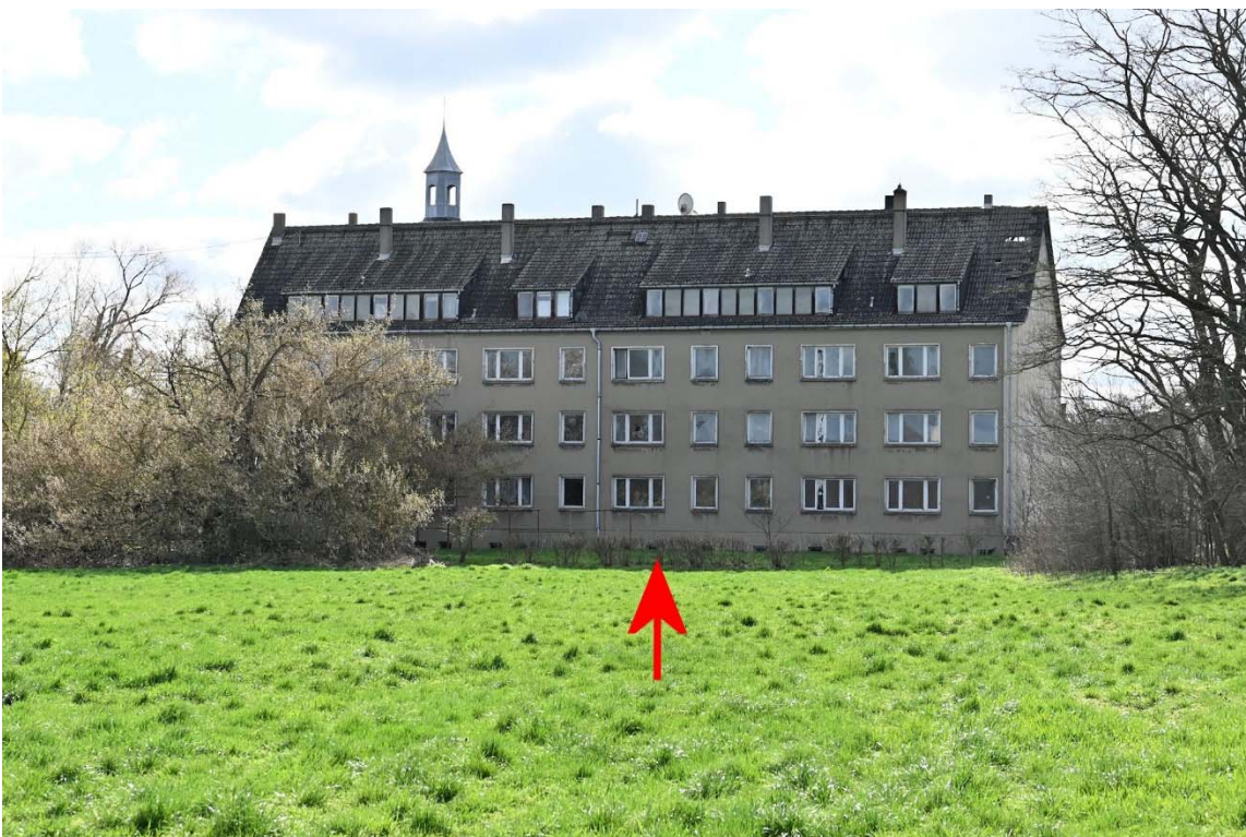
Abb. 4: Gemeinschaftseigentum: Grundstücksansicht, Kennzeichnung relevantes Grundstück
