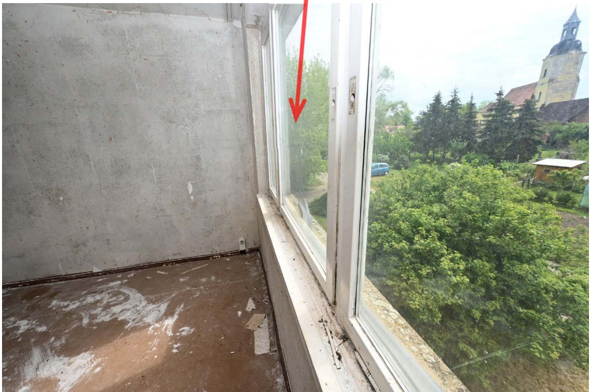
Abb. 22: SE Nr. ④, Wohnraum, Detail Fenster
