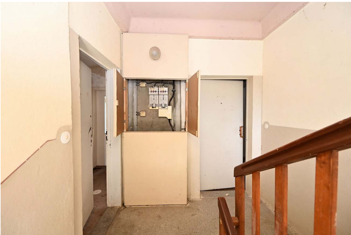
Abb. 24: Treppenhaus Hauseingang 6a, 2. OG, Wohnungseingangstüren zu SE Nr. ⑤ (links) und ⑥ (rechts)
