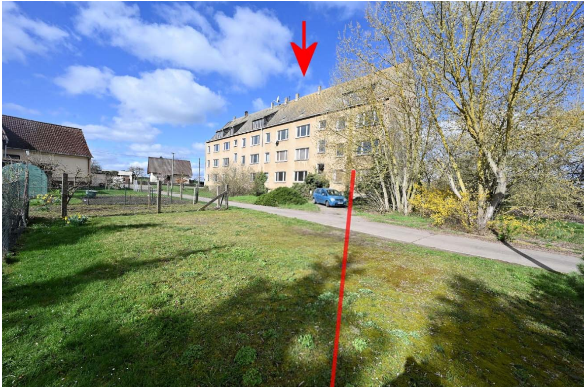
Abb. 5: Gemeinschaftseigentum: Grundstücksansicht, Kennzeichnung relevantes Grundstück
