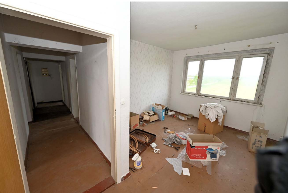
Abb. 32: SE Nr. ⑥, Wohnraum mit Blick in den Flur
