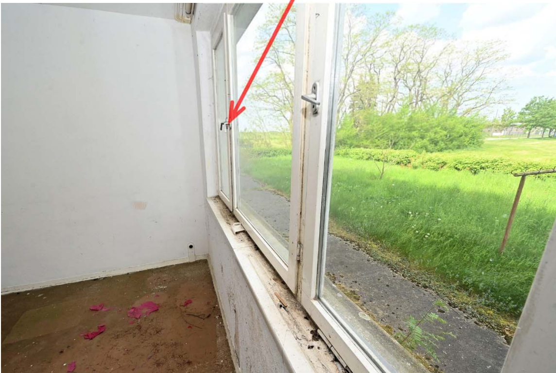
Abb. 16: SE Nr. ②, Wohnraum, Detail Fenster
