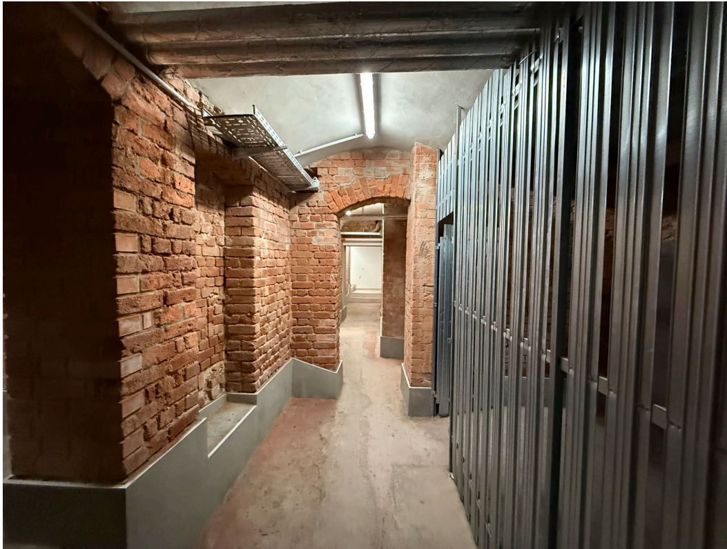
Gang im Kellergeschoss (Gemeinschaftseigentum)
