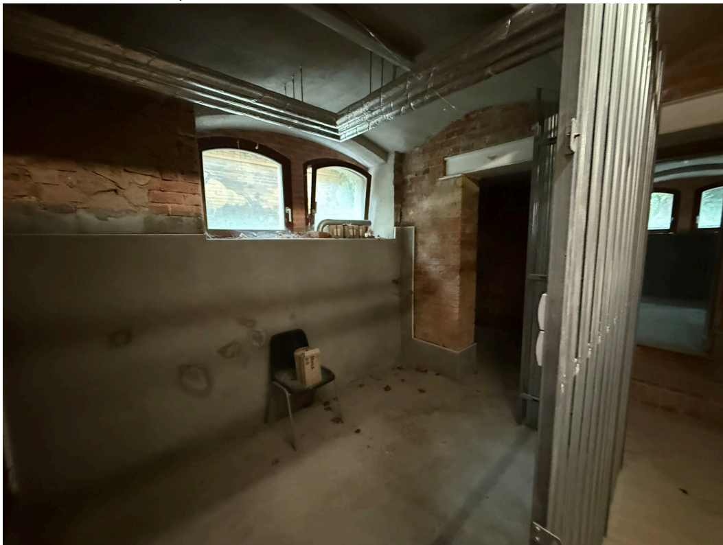
Lageraum 4 im Kellergeschoss
