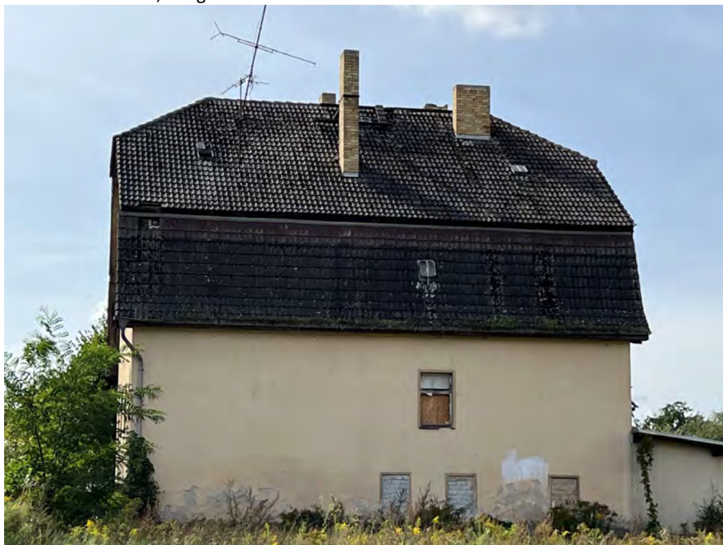
ehem. Herrenhaus; Ostfassade
