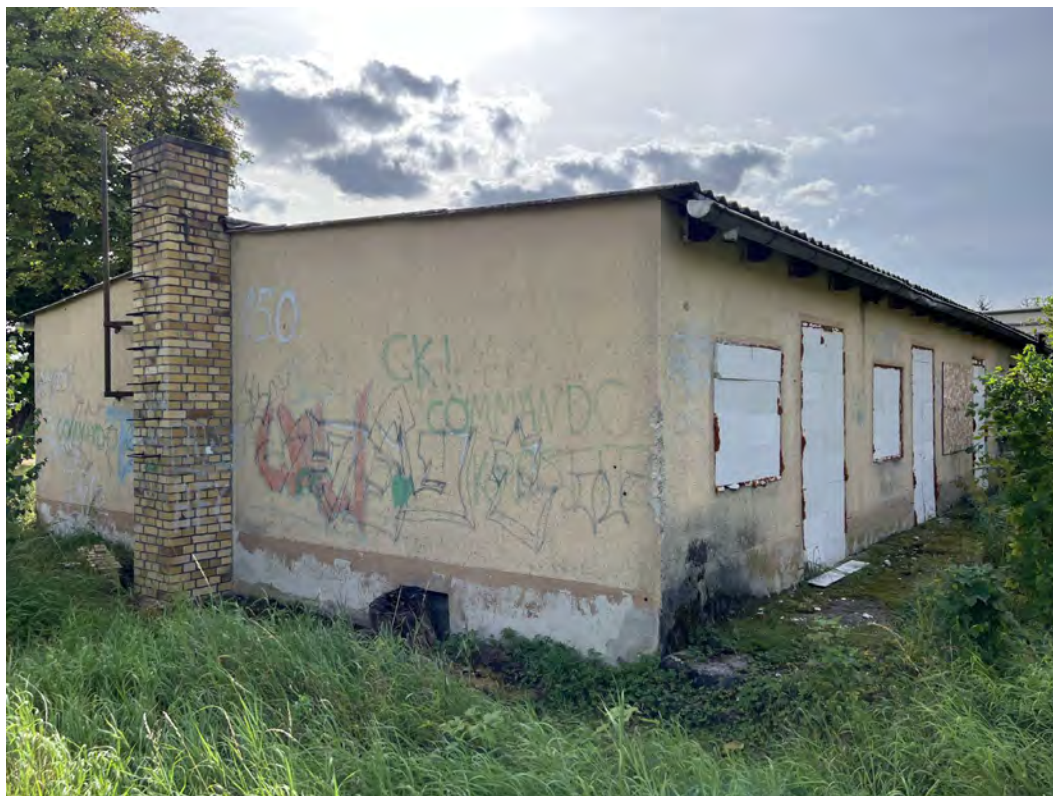
Garage, nordöstliche Gebäudeecke
