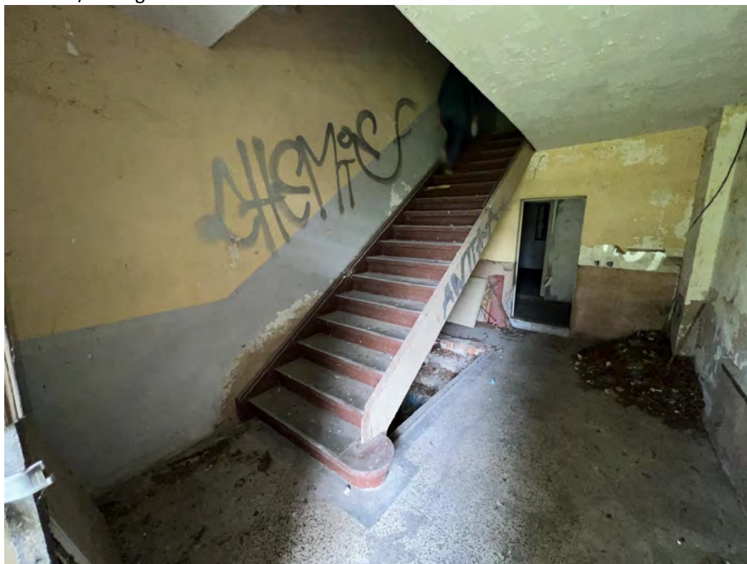
ehem. Herrenhaus; Erdgeschoss
