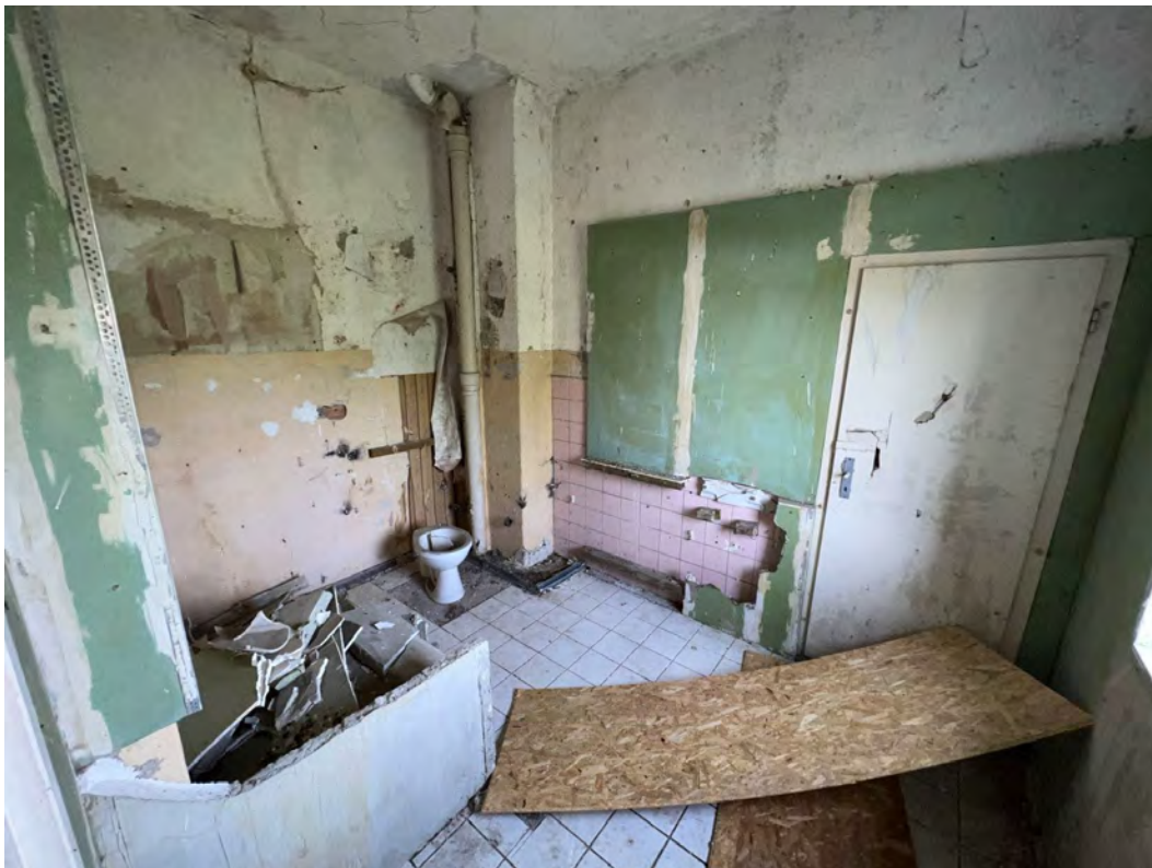
ehem. Herrenhaus; frühere Sanitärräume im Obergeschoss
