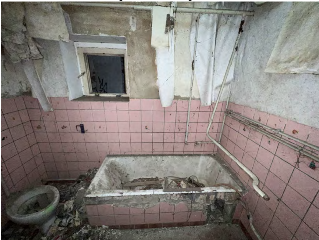
ehem. Herrenhaus; frühere Sanitärräume im Erdgeschoss
