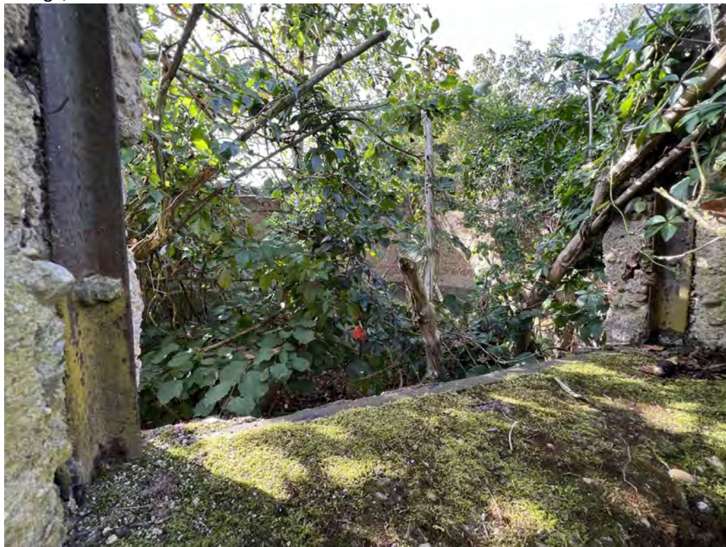
Reste eines weiteren früheren Gebäudes (Ruine)
