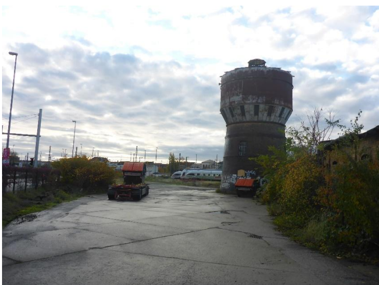
Blick auf den Wasserturm von Nordwesten Richtung Südosten
