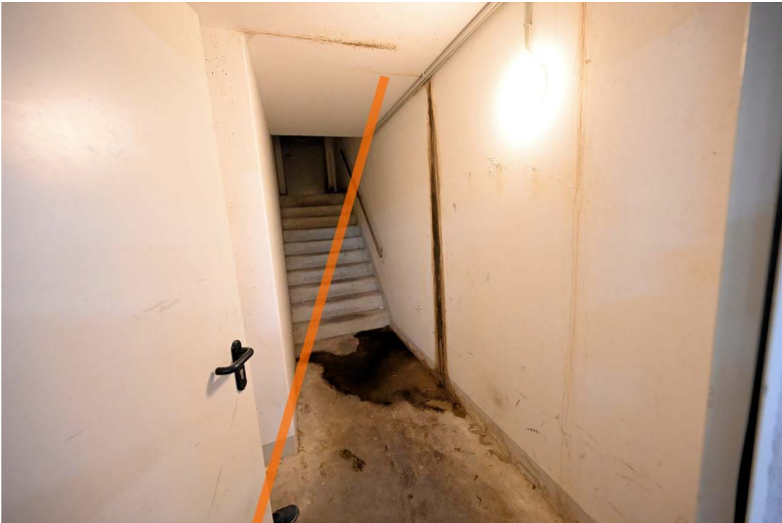
Abb. 15: Gemeinschaftseigentum, südliche Schleuse von der Tiefgarage zu Haus 1
