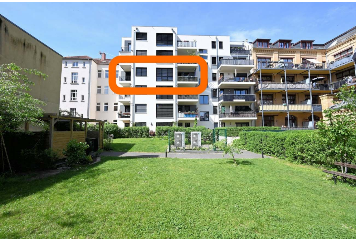
Abb. 4: Gemeinschaftseigentum, Ansicht Haus 7 neben Haus 1, Kennzeichnung SE Nr. 141, im Vordergrund zwei Luft-Wärmepumpen
