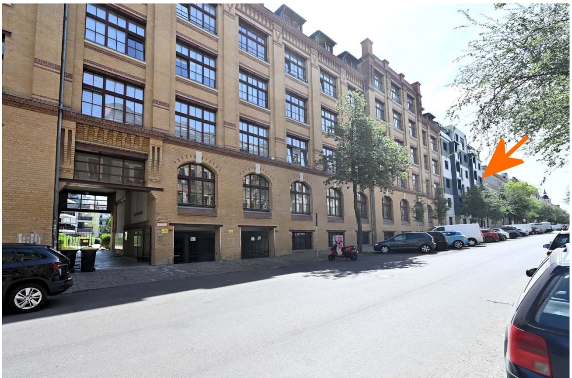
Abb. 2: Gemeinschaftseigentum, Unter Eichstädtsstraße 11 und 11h, Hausdurchfahrt und Tiefgarageneinfahrt, Kennzeichnung Bewertungsobjekt (SE Nr. 141)
