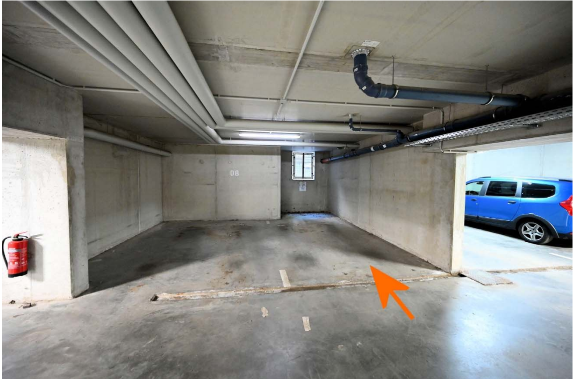
Abb. 17: Gemeinschaftseigentum, Kennzeichnung SNR TG-Stp. P9 zu SE Nr. 141 (nicht unmittelbar an Haus 7 anschließend, sondern zw. Haus 1 und 3 bzw. links von der Tiefgaragenabfahrt)
