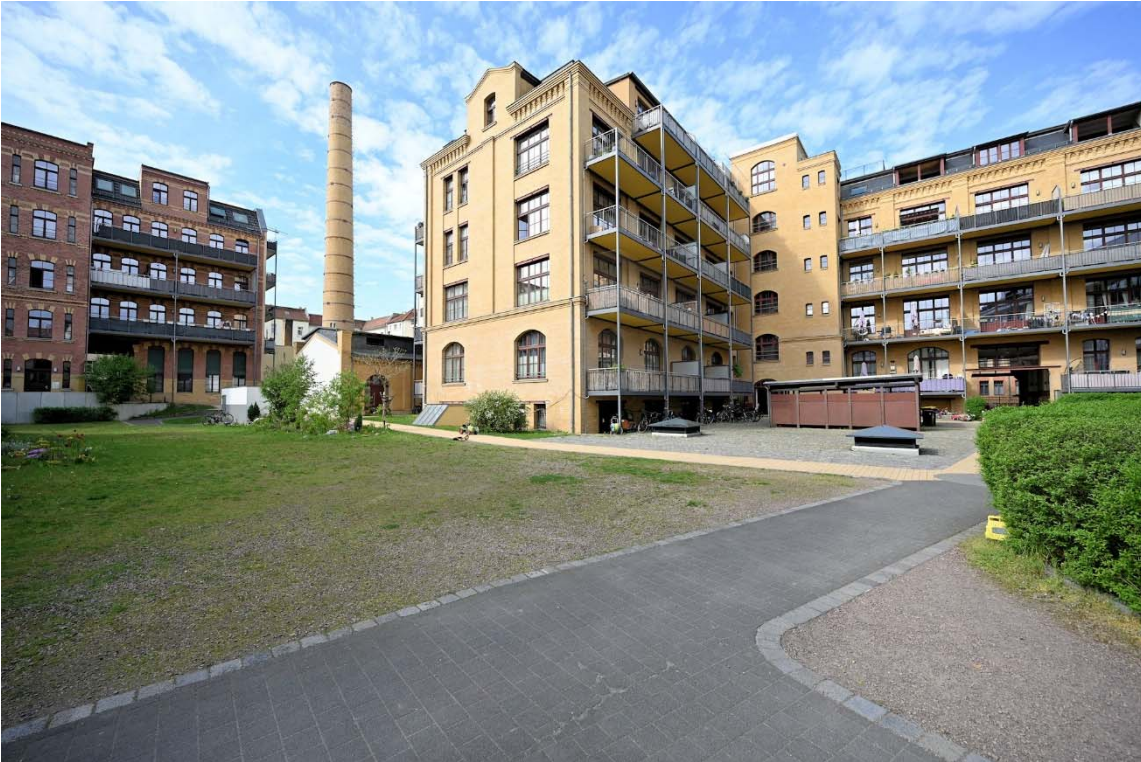
Abb. 3: Gemeinschaftseigentum, Innenhof hinter Haus 1, Bewertungsobjekt (SE Nr. 141 im Haus 7) nicht abgebildet
