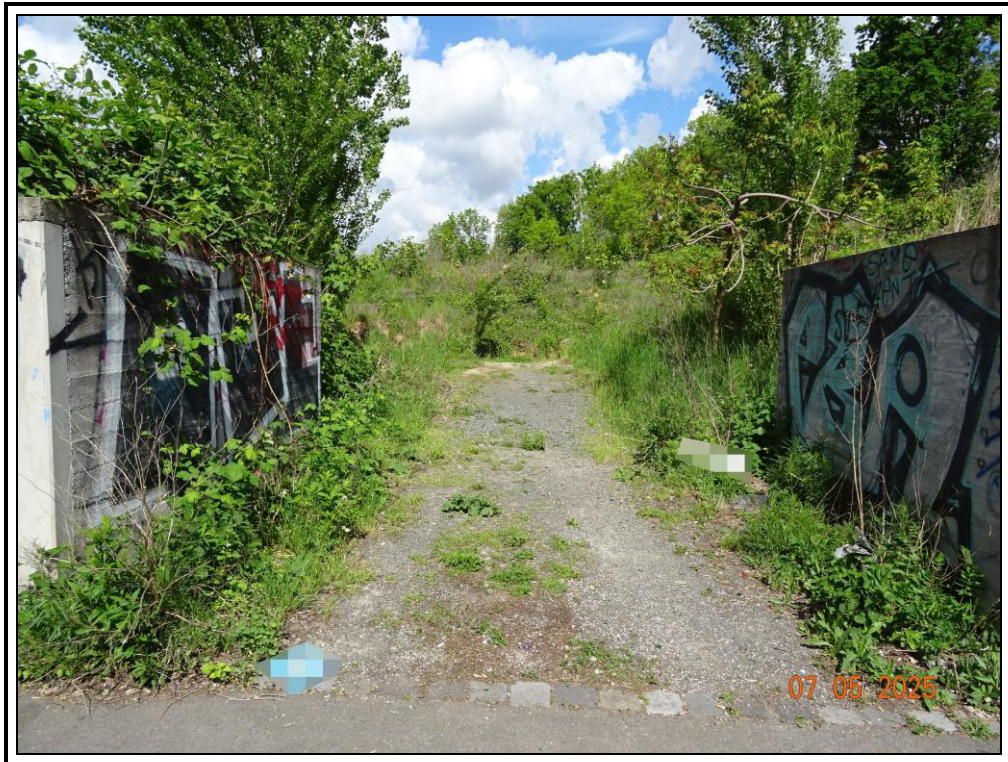
Foto 1: südöstliche Teilansicht des Gesamtgrundstückes (hier insbesondere Flurstück 299/c) mit Zufahrt von der Anliegerstraße „Torgauer Straße“
