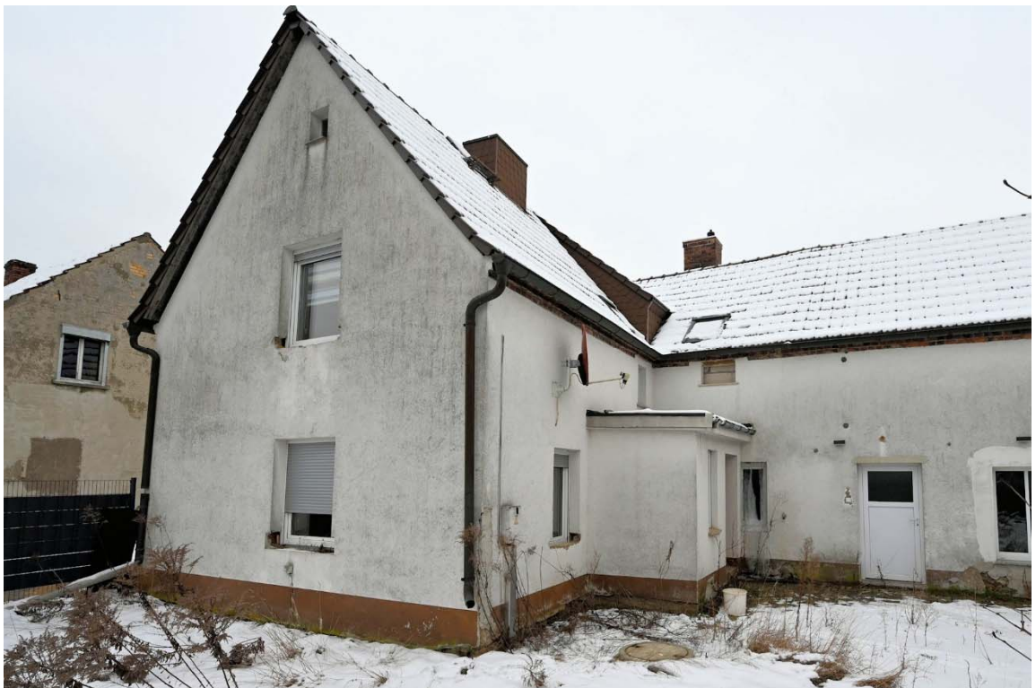
Abb. 6: Wohnhaus (A), Gebäudeansicht vom Hof
