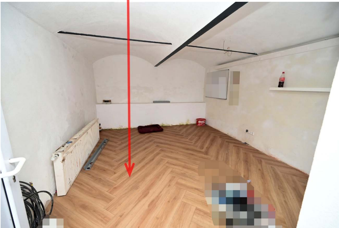
Abb. 40: ehem. Scheune (B), Umbau Büro
