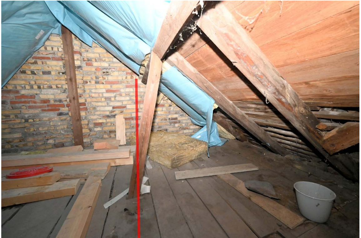
Abb. 37: Wohnhaus (A), Dachspitz, ungewöhnliche Abfangung Dachsparren
