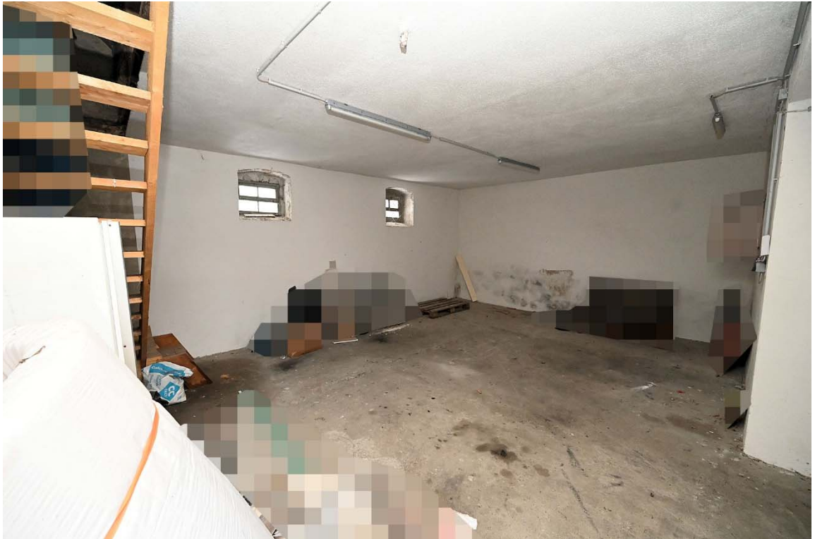
Abb. 45: ehem. Stall (C), Erdgeschoss
