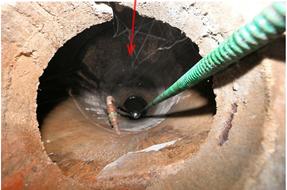
Abb. 18: Wohnhaus (A), Erdgeschoss, Brunnen (bis zur Wasseroberfläche ca. 6,6 m)
