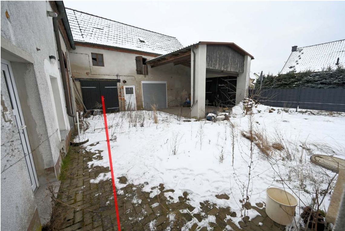
Abb. 43: ehem. Stall (C), Gebäudeansicht (Bildmitte)
