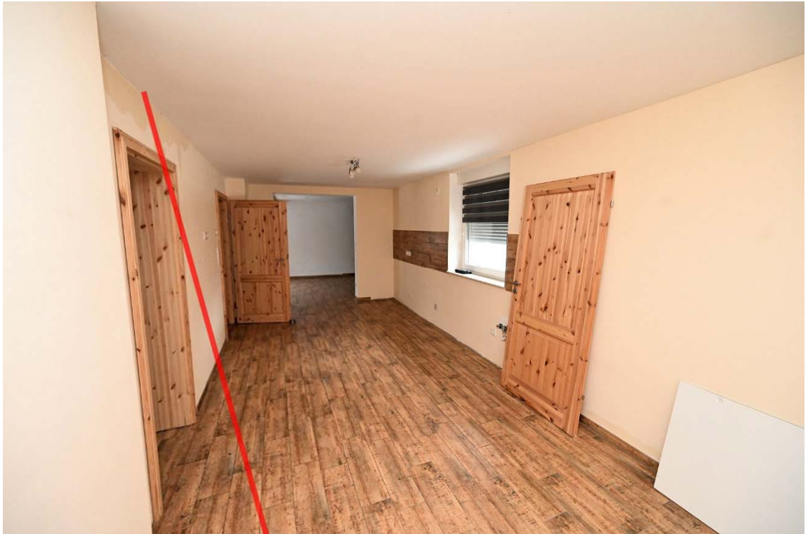
Abb. 21: Wohnhaus (A), Erdgeschoss, Küche
