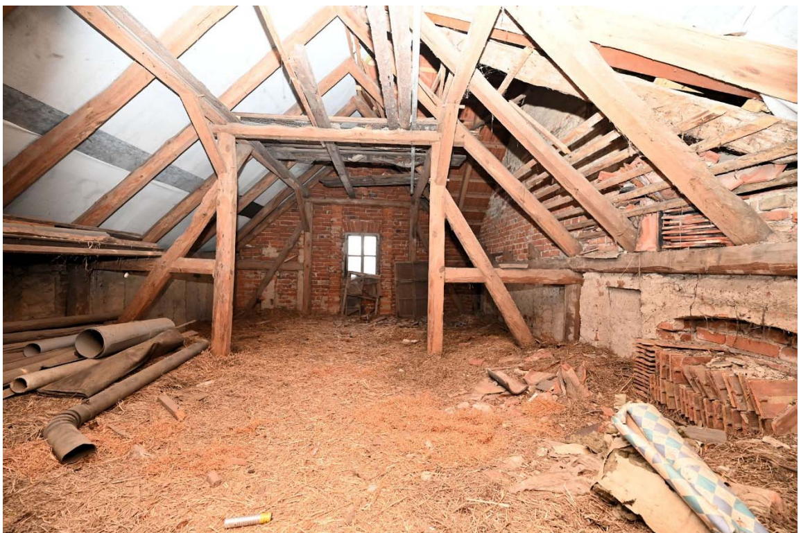
Abb. 42: ehem. Scheune (B), Dachgeschoss mit Südgiebel
