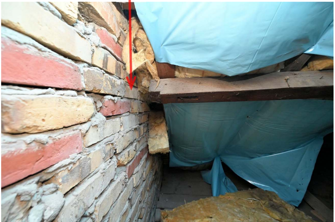
Abb. 38: Wohnhaus (A), Dachspitz, ungewöhnliche Abfangung Dachsparren
