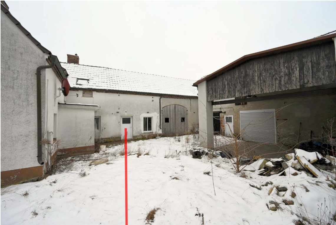
Abb. 39: ehem. Scheune (B), Gebäudeansicht (Bildmitte)
