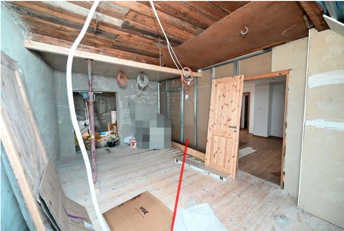
Abb. 31: Wohnhaus (A), Dachgeschoss, östliches Zimmer, Decke abgefangen (unterhalb Abfangung Dachsparren (s. Abb. 37/38))
