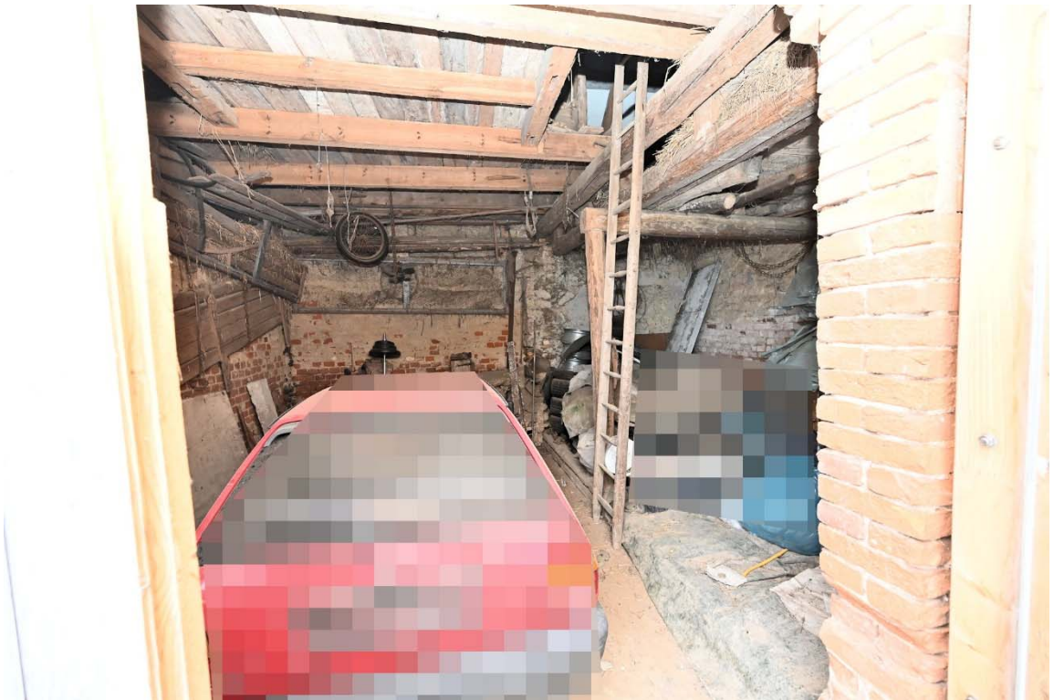
Abb. 41: ehem. Scheune (B), Erdgeschoss
