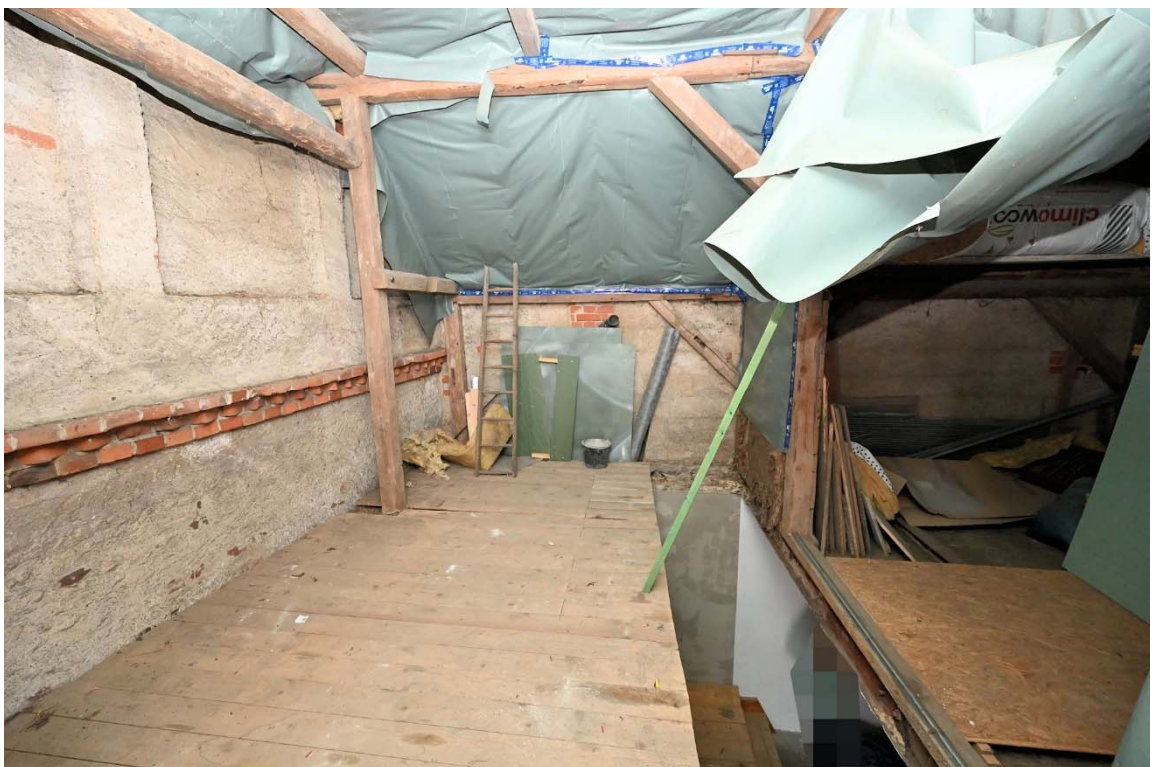
Abb. 46: ehem. Stall (C), Dachgeschoss, tw. wärmegeklämmt
