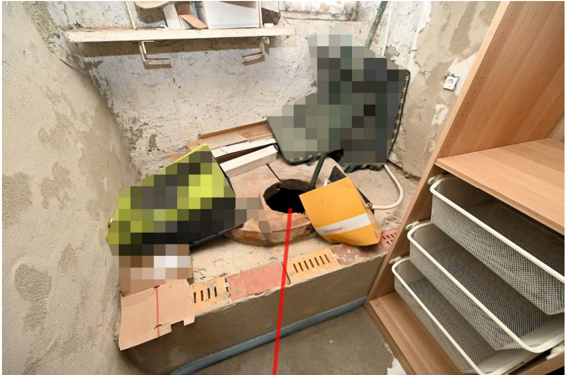
Abb. 17: Wohnhaus (A), Erdgeschoss, "Raum mit Brunnen", Detail Brunnenabdeckung
