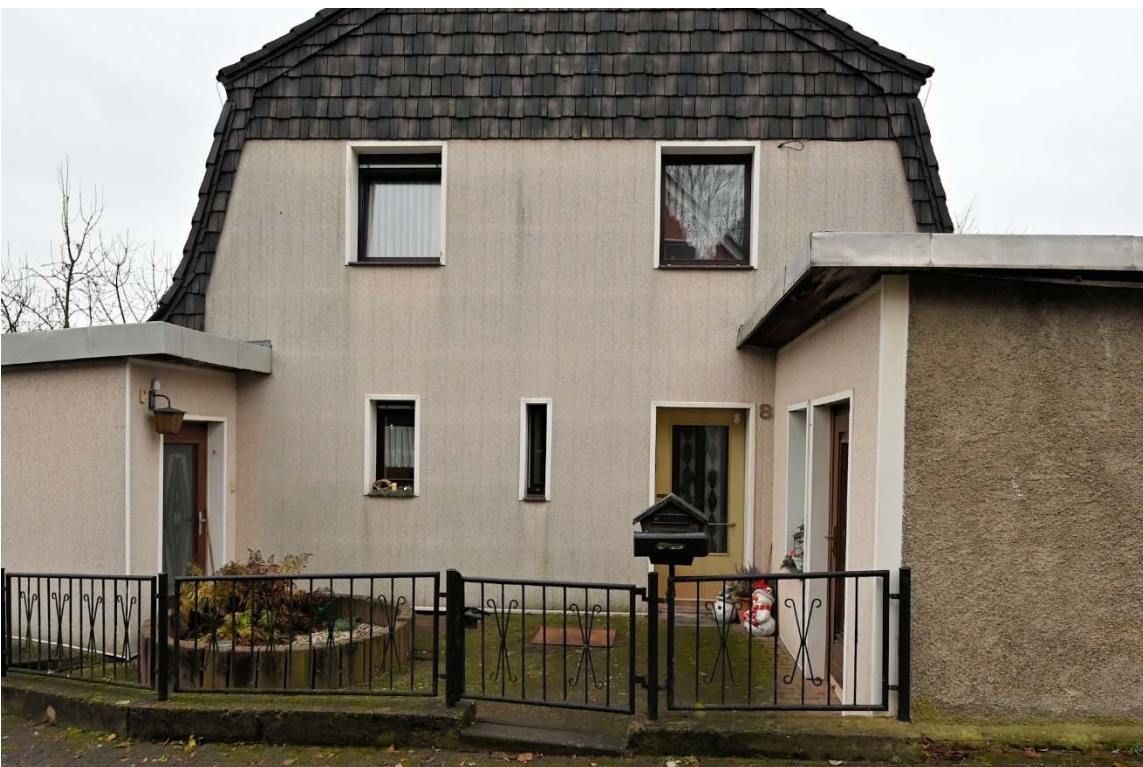
Abb. 4: Flurstück 89, Gebäudeansicht vom Heideweg, links der Anbau (so gen. Kohlebunker (KG) mit Zimmer (EG)), rechts ehem. Gästezimmer (so gen. Garage)
