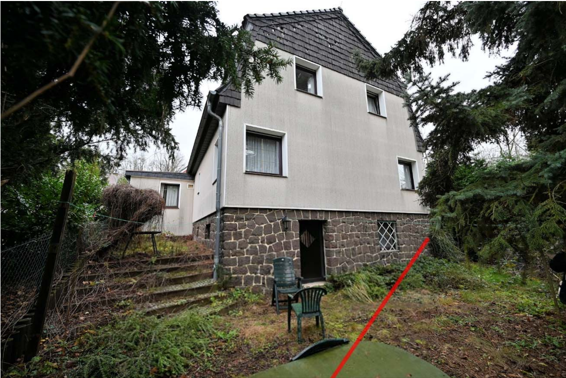
Abb. 7: Flurstück 89, gartenseitige Gebäudeansicht, links ehem. Gästezimmer (so gen. Garage)
