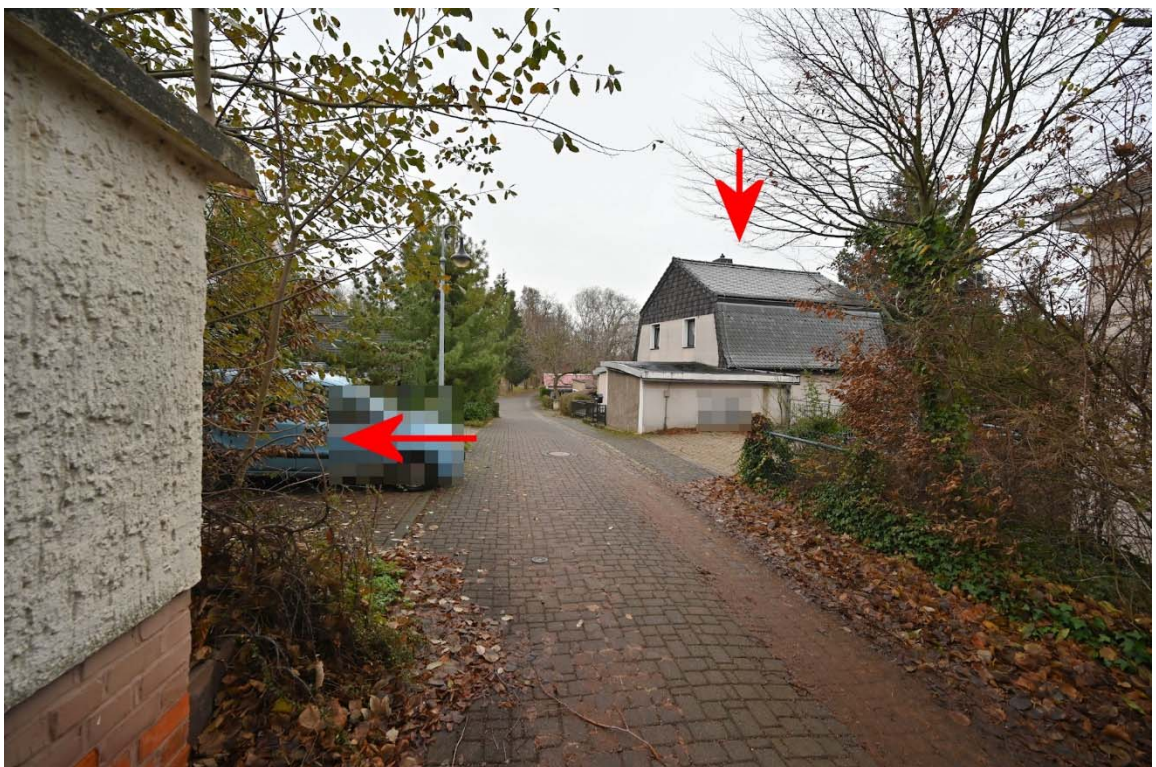
Abb. 2: Heideweg, Blickrichtung Südosten, Kennzeichnung Bewertungsobjekt (links Flurstück 91/6 mit Garage, rechts Flurstück 89 mit Wohnhaus)
