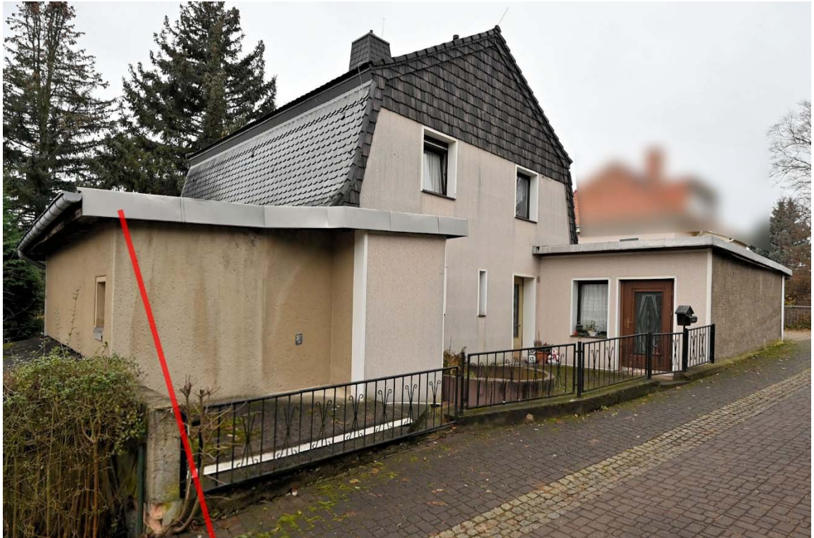
Abb. 5: Flurstück 89, Gebäudeansicht vom Heideweg, links der Anbau (so gen. Kohlebunker (KG) mit Zimmer (EG)), rechts ehem. Gästezimmer (so gen. Garage)
