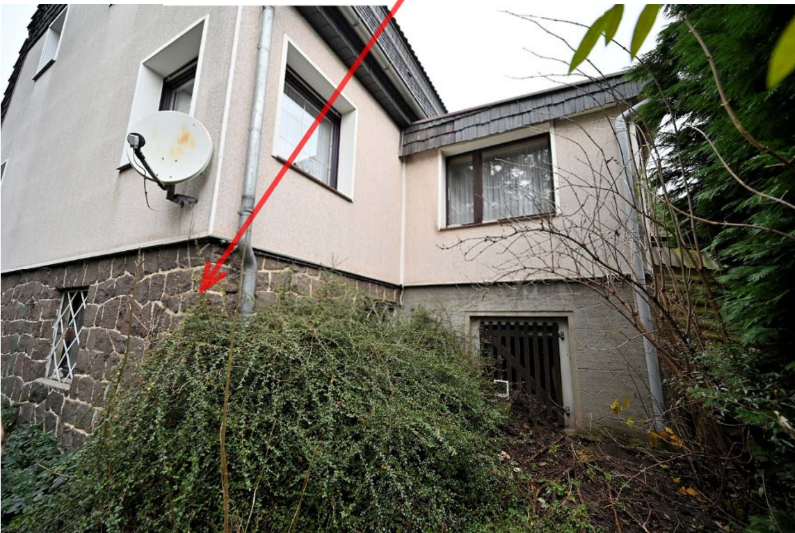
Abb. 8: Flurstück 89, gartenseitige Gebäudeansicht, rechts der Anbau (so gen. Kohlebunker (KG) mit Zimmer (EG))
