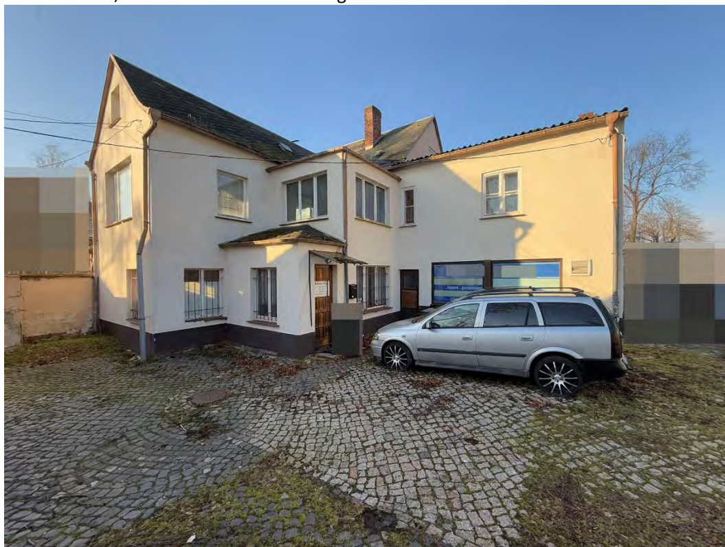
Flurstück 620; Nebeneingang zu den ehem. Büros im Ober- und Dachgeschoss
