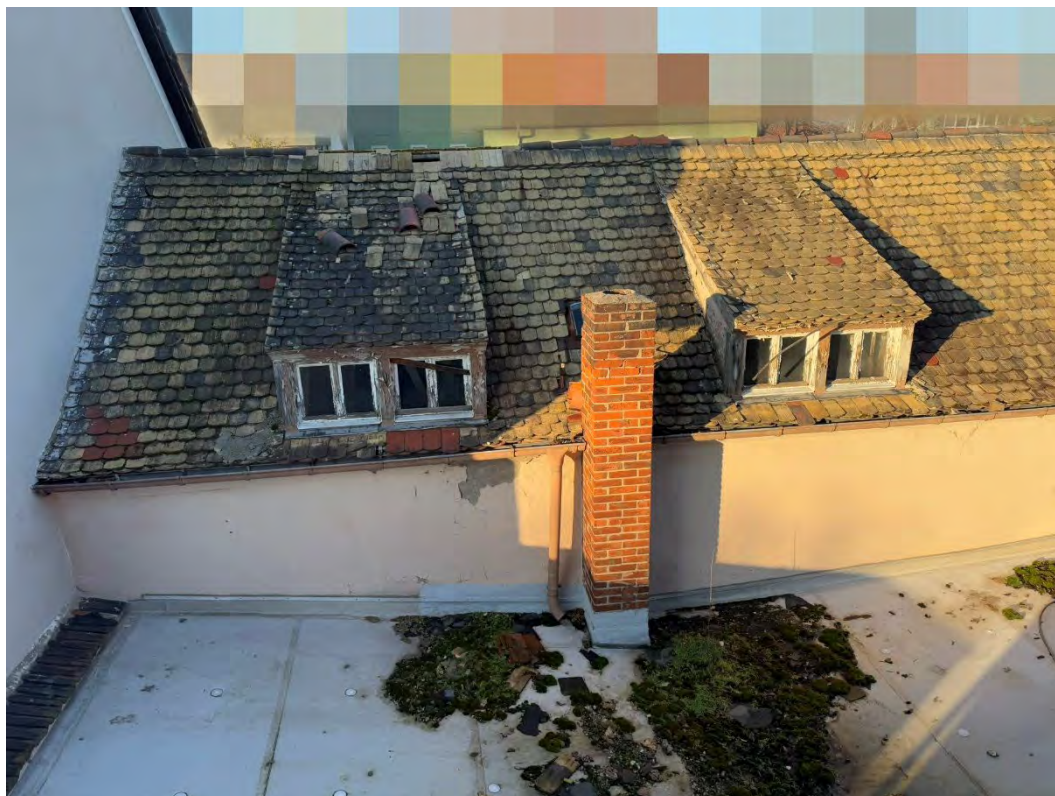
Flurstück 620; Dachfläche des an der August-Bebel-Straße befindlichen Gebäudeteils ...
