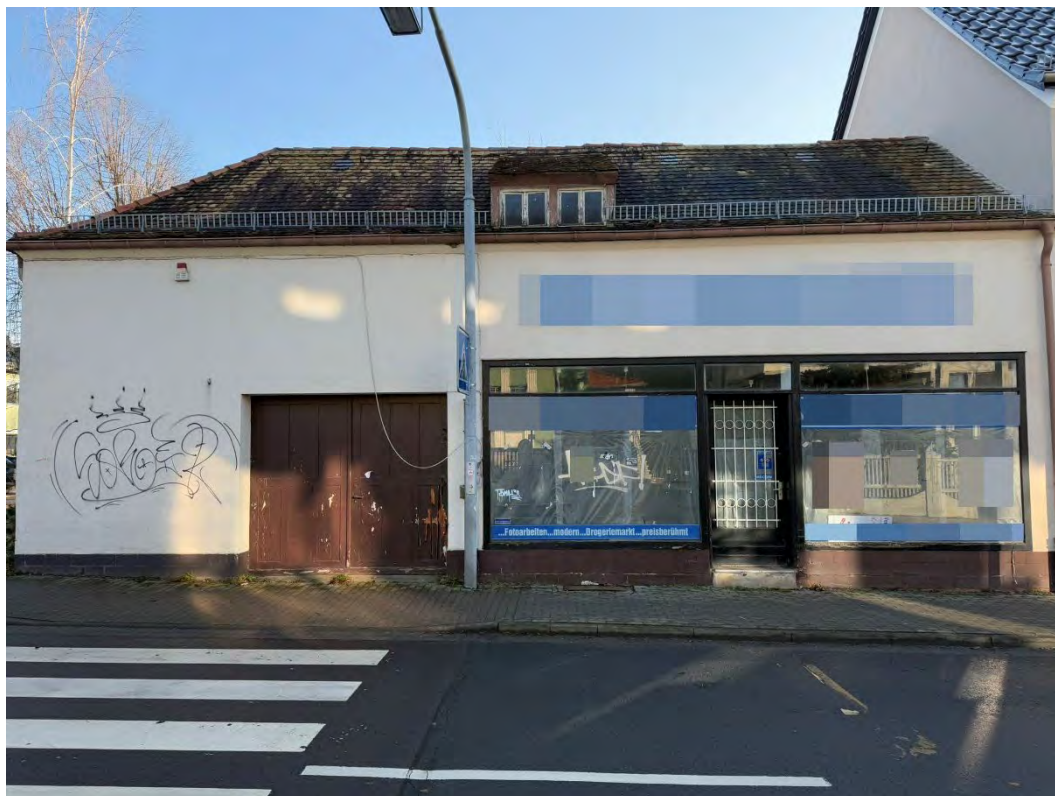
Flurstück 620; Haupteingang zum früheren Drogeriemarkt an der August-Bebel-Straße
