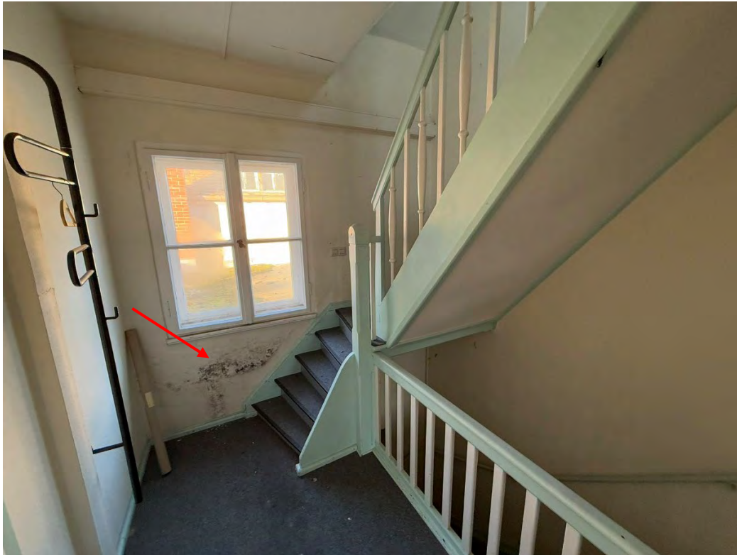
Flurstück 620; Treppenhaus im Obergeschoss (nasse Außenwand infolge unzureichender Abdichtung)
