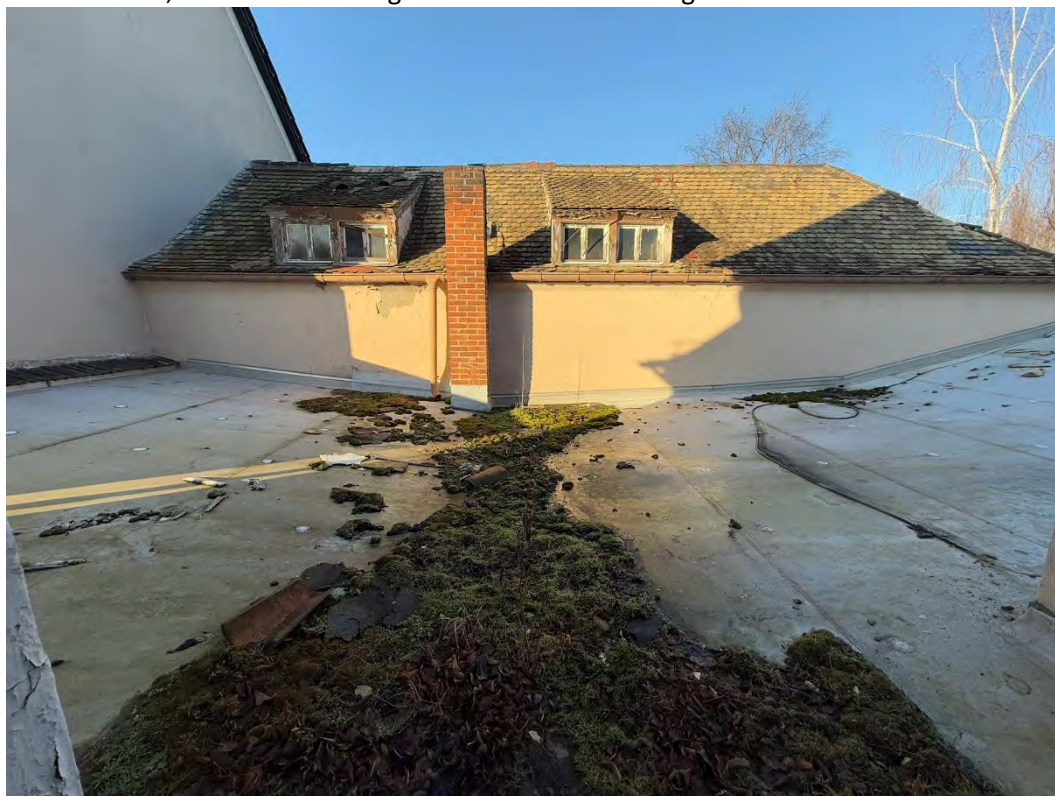
... des über dem Verkaufsraum befindlichen Schmetterlingsdaches
