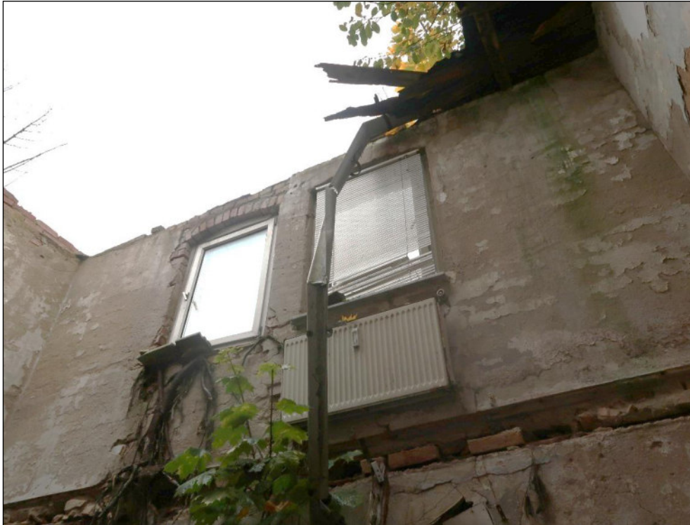
Bild 19: Blick vom Treppenhaus auf die eingestürzten hofseitigen Anbauten
