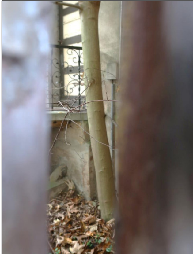
Bild 22: Blick durch das Hoftor auf den hinteren Zugang zum Treppenhaus
