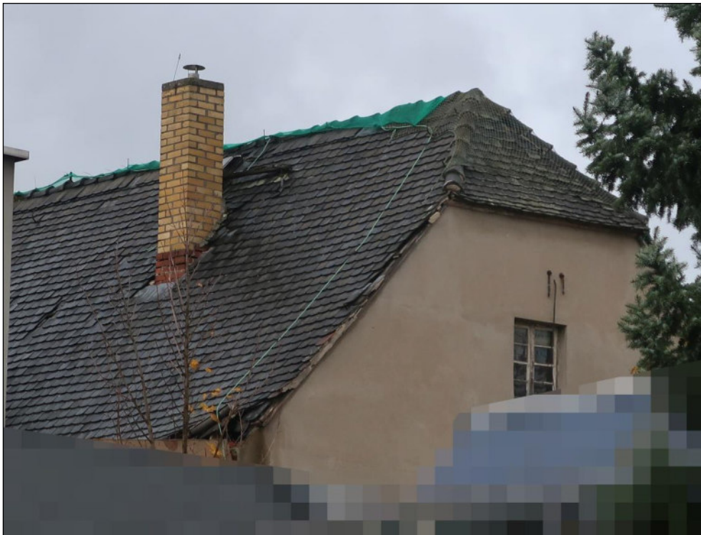
Bild 11: Blick vom Schwanengäßchen auf die Dacheindeckung des Hauptgebäudes (Hofseite)
