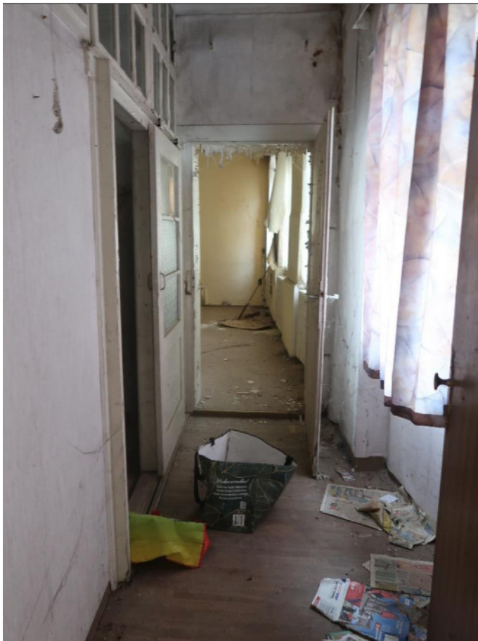
Bild 13: EG, ehem. Wohnung, Flur
