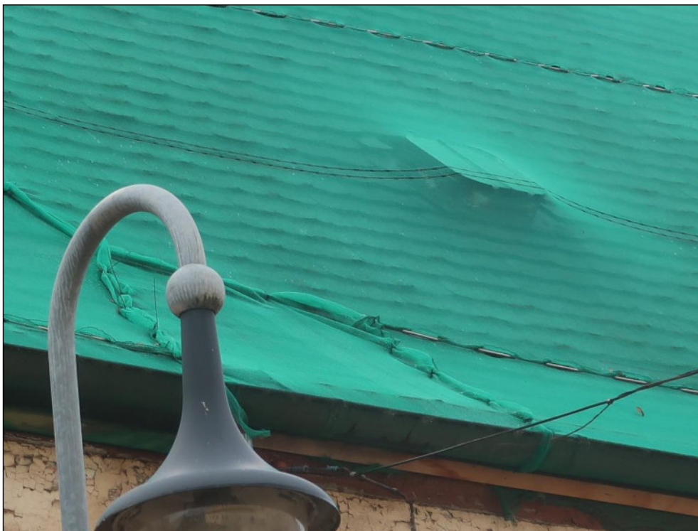
Bild 10: straßenseitige Notsicherung des Daches am gesamten Gebäude
