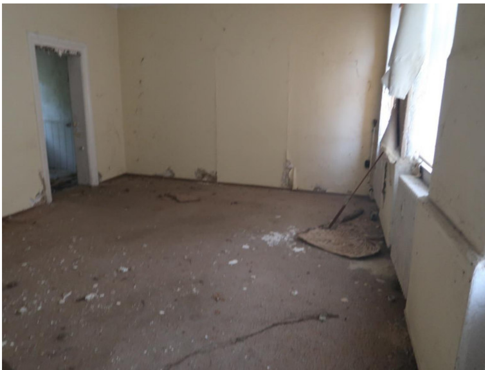
Bild 14: EG, ehem. Wohnung, Wohnzimmer
