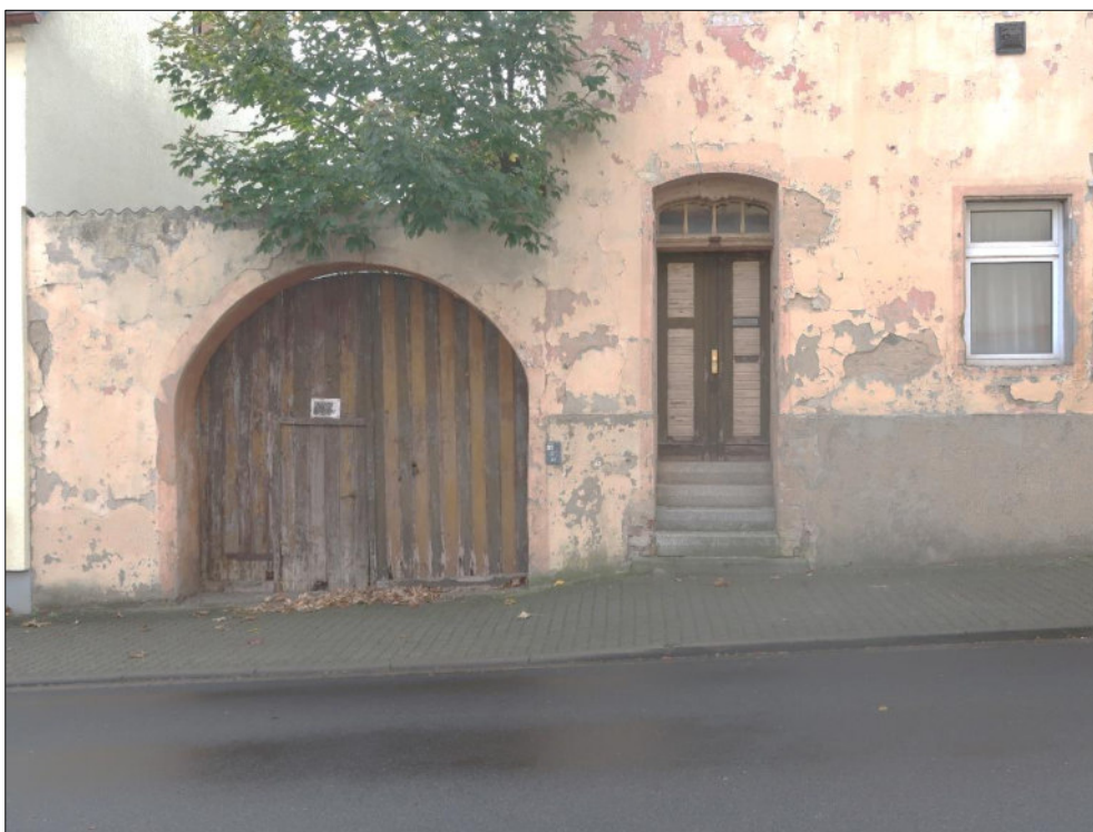
Bild 8: straßenseitiger Hauseingang August-Bebel-Straße zum Treppenhaus sowie Zugang Innenhof
