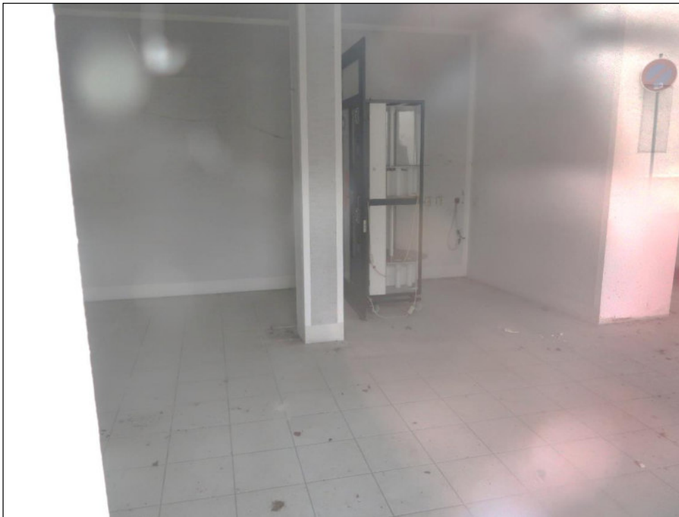
Bild 7: Blick durch die Eingangstür der Ladeneinheit
