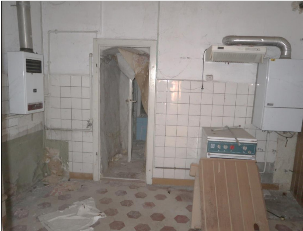
Bild 15: EG, ehem. Wohnung, Küche
