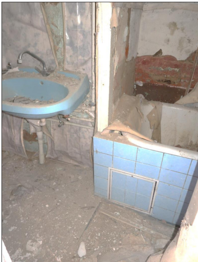
Bild 16: EG, ehem. Wohnung, Bad
