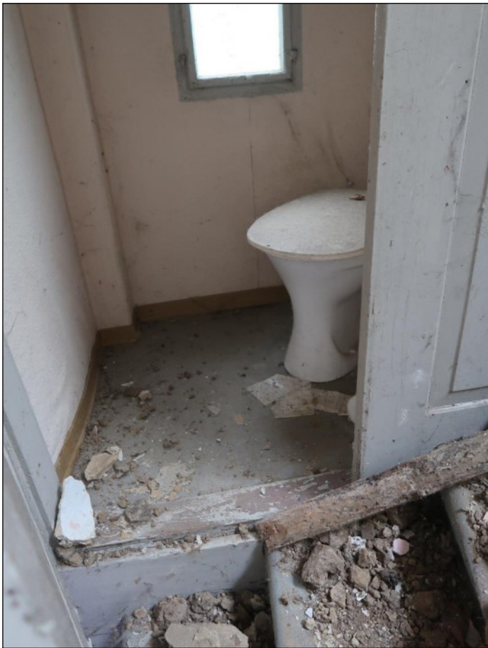
Bild 17: WC auf halber Treppe zum OG
