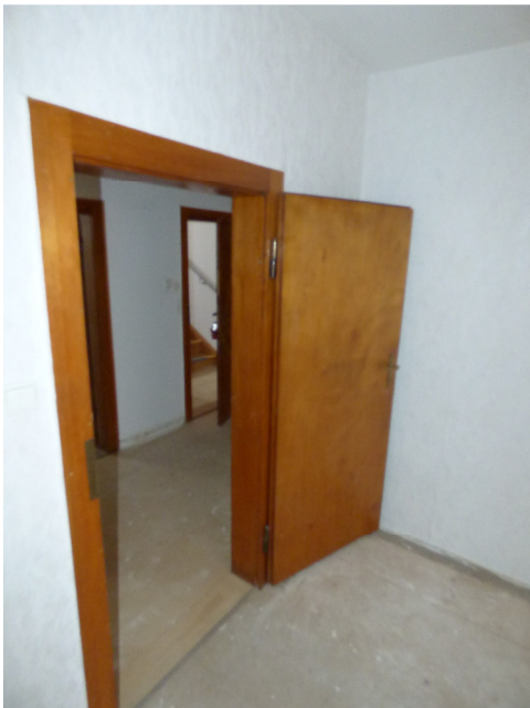
Bild 31: EG: Detail Innentüren
