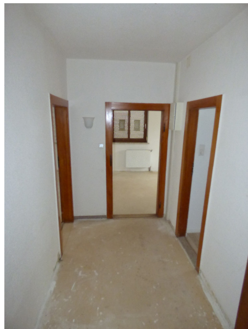
Bild 28: EG: Wohnungsflur im Renovierungszustand
