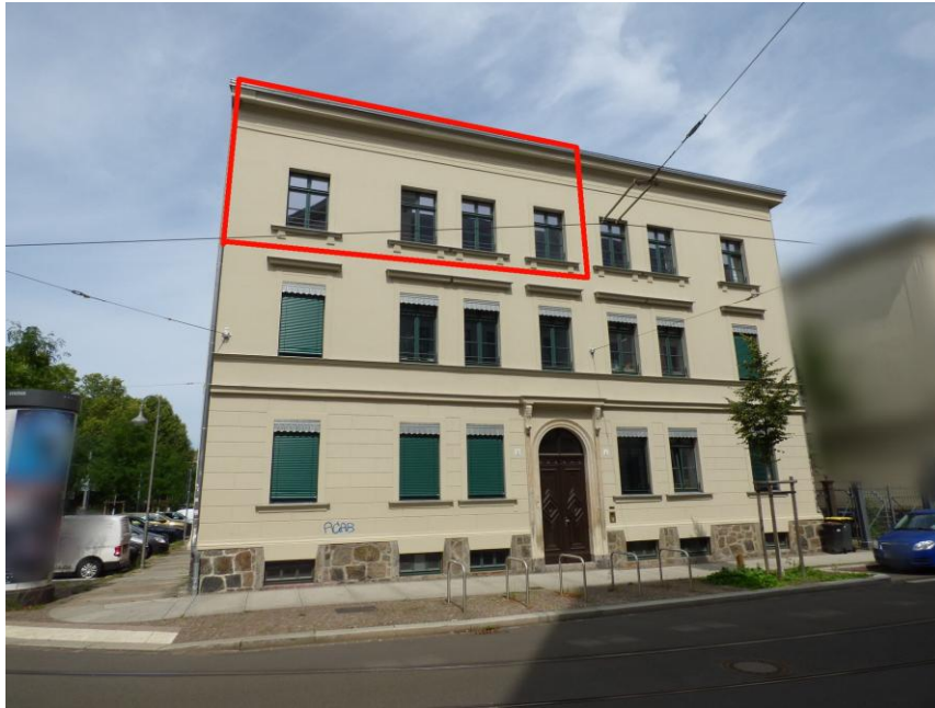
Bild 1: Straßenansicht von Süden mit Kennzeichnung der Lage der Wohnung
