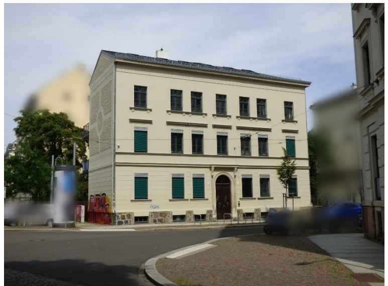
Abbildung 2 - Straßenansicht von Südwesten
