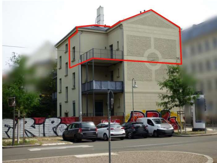
Bild 3: Blick von Westen mit Kennzeichnung der Lage der Wohnung
