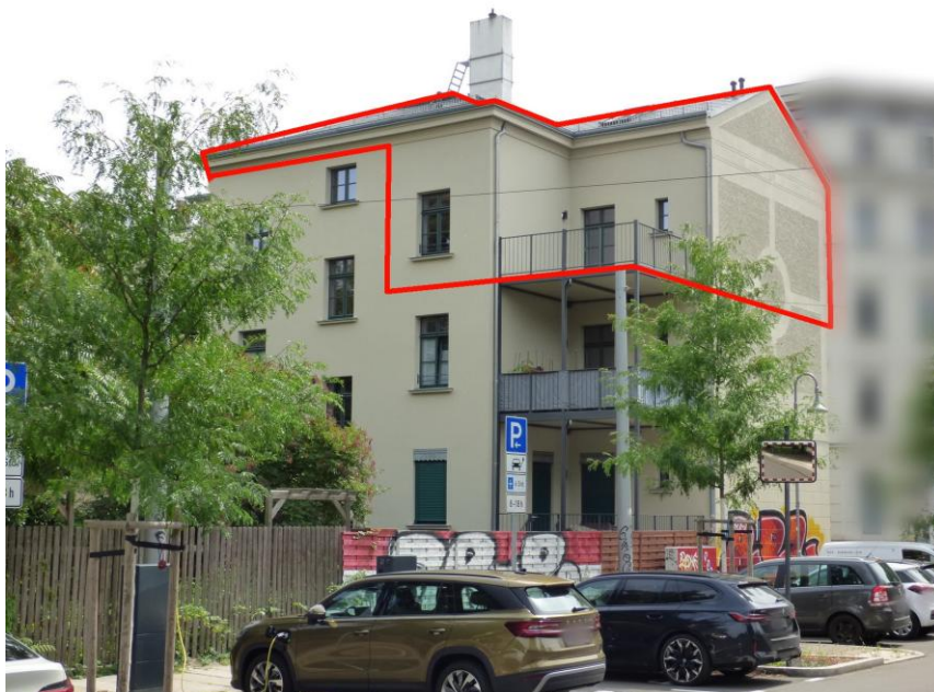
Bild 2: Blick von Norden mit Kennzeichnung der Lage der Wohnung (inkl. komplettes Dachgeschoss)
