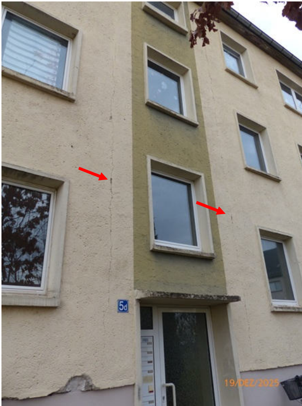
Fotos 33, 34 und 35: senkrechte Risse sowie Farb- und Putzabplatzungen in den Fassaden (beispielhaft)
