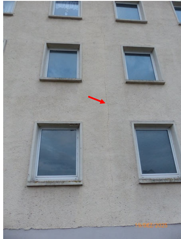
Fotos 33, 34 und 35: senkrechte Risse sowie Farb- und Putzabplatzungen in den Fassaden (beispielhaft)
