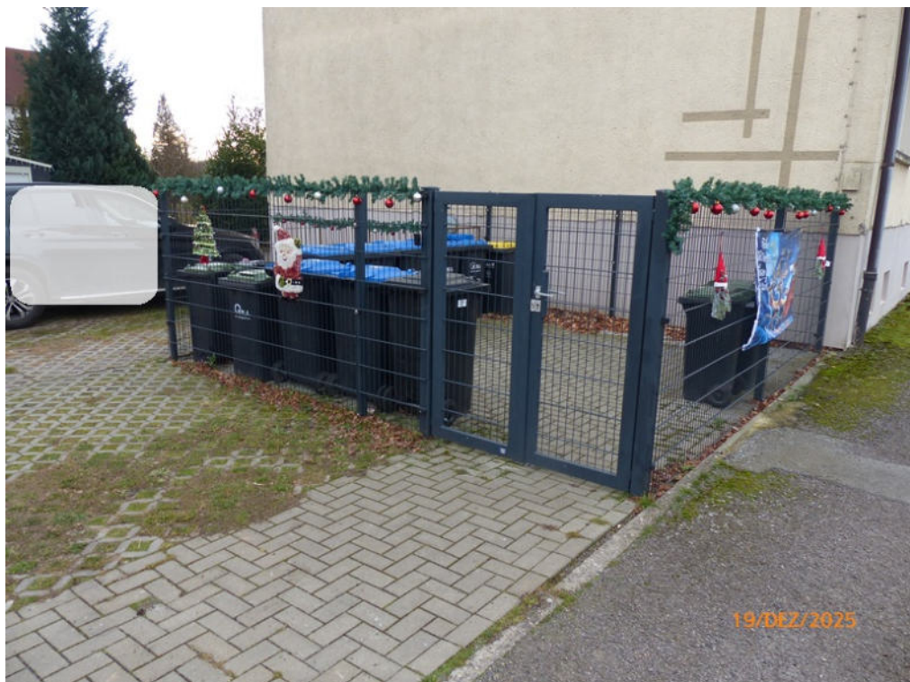
Foto 23: Gemeinschaftliche Außenanlagen - abschließbarer Abfallbehälterstellplatz
