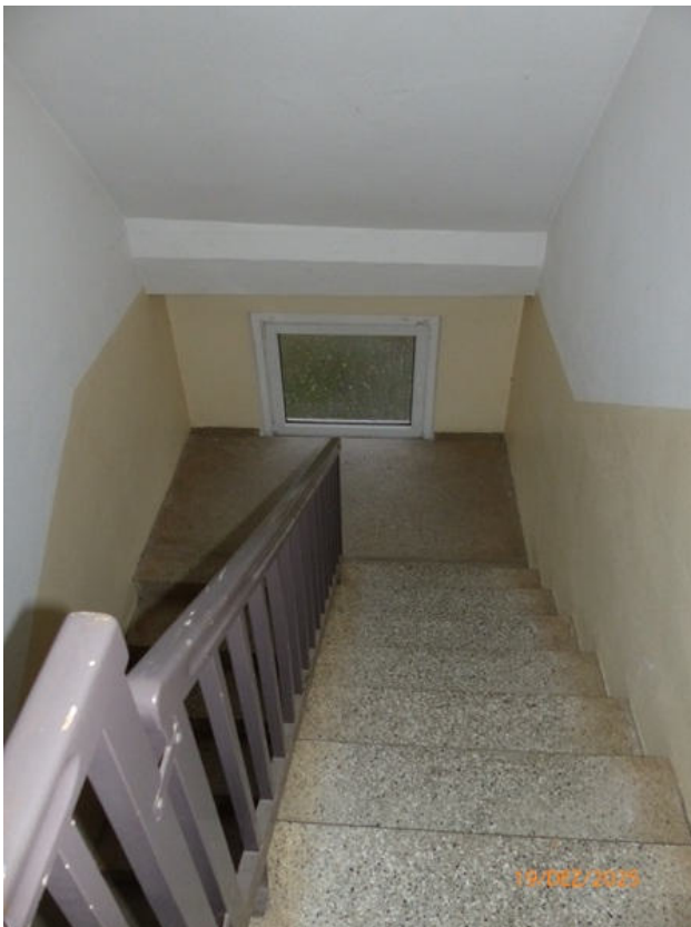
Fotos 16 und 17: Treppenhaus Dachgeschoss (GE)
