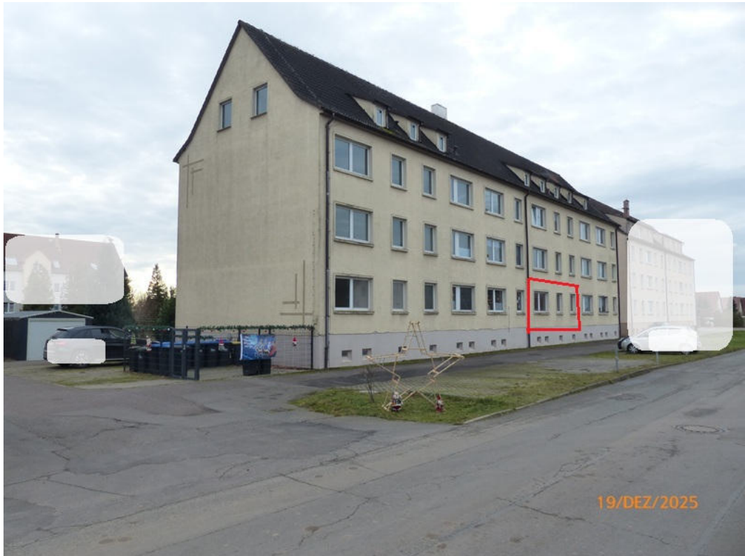
Foto 3: Straßenansicht Wohneigentumsanlage Nitzschkaer Straße 5c, 5d (Gemeinschaftseigentum – GE)
