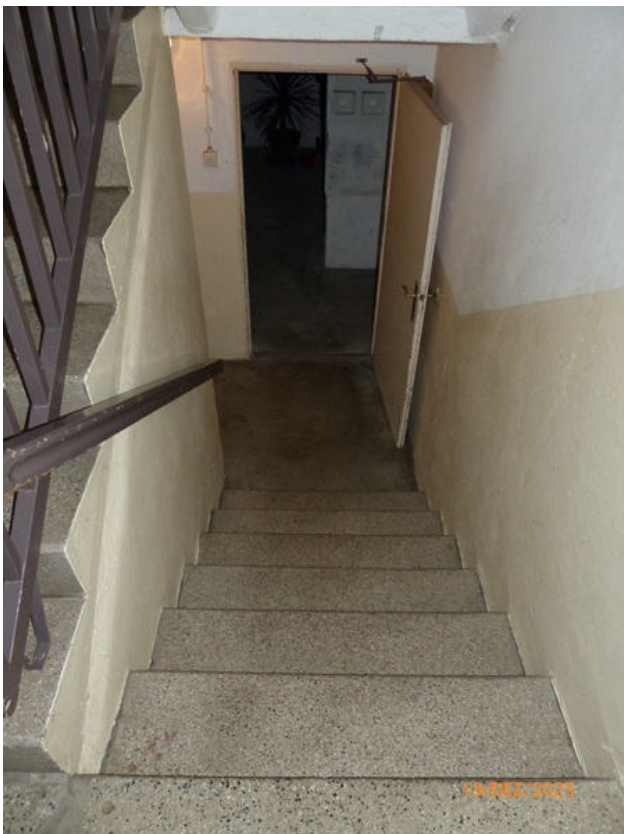
Fotos 18 und 19: Kellertreppe und Kellergang (GE)
