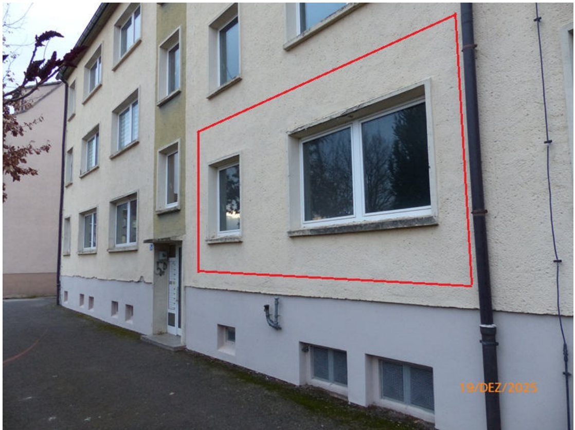
Foto 7: Ansicht Rückseite Nitzschkaer Straße 5d – Bereich WE 2 (GE)
