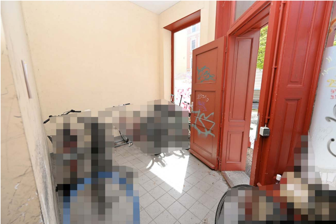
Abb. 19: Gemeinschaftseigentum, Erdgeschoss, Fahrradraum (ehem. Laden)
