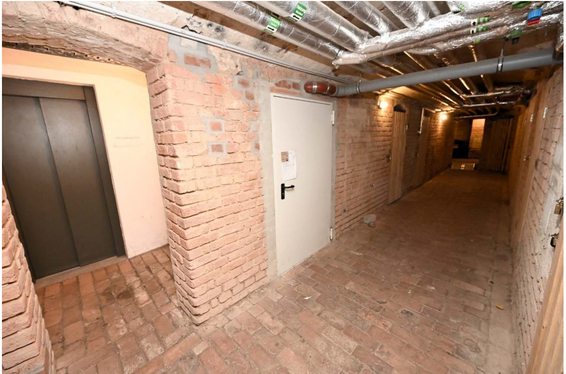
Abb. 17: Gemeinschaftseigentum, Kellergeschoss, Gang
