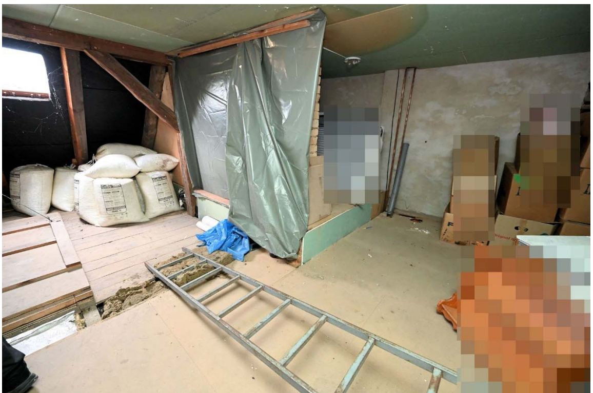
Abb. 22: Dachgeschoss, Bereich über Bad/WC (angehobene Decke)
