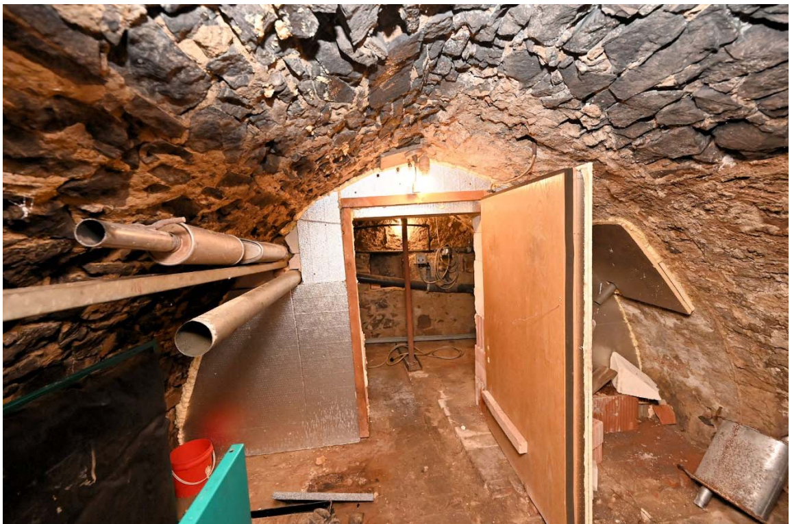
Abb. 10: Teilkeller, Gewölbekeller aus Bruchstein
