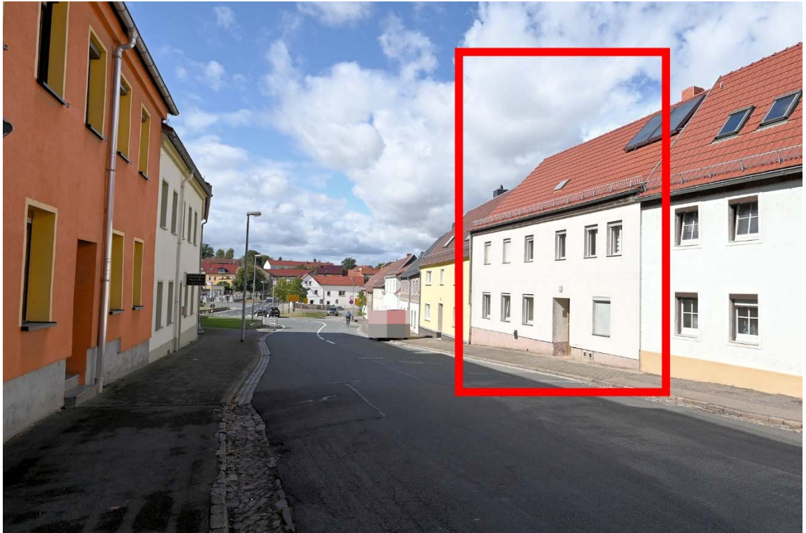
Abb. 1: Lindenstraße, Blickrichtung Westen, ungefähre Kennzeichnung Bewertungsobjekt
