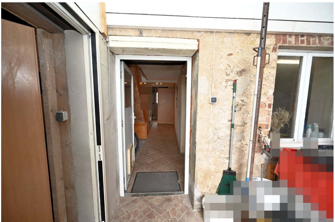
Abb. 26: Erdgeschoss, Blick aus dem Hof in den Hausflur
