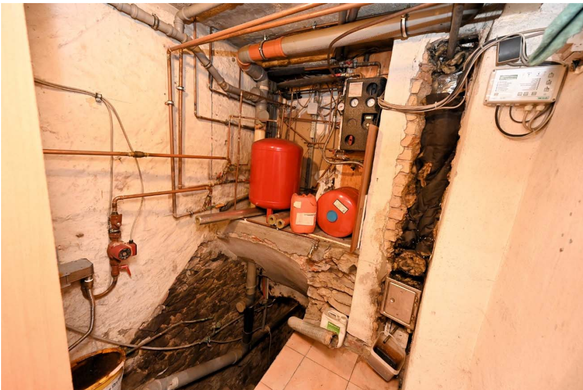
Abb. 8: Erdgeschoss, Raum WC und Kellerabgang, Decke unter Bad/WC massiv (urspr. Holzbalkendecke entfernt)
