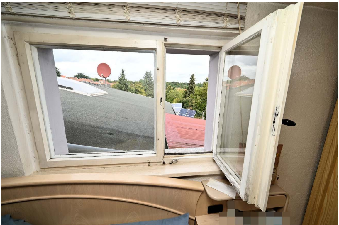
Abb. 18: Obergeschoss, Schlafzimmer, Fenster zum Garten
