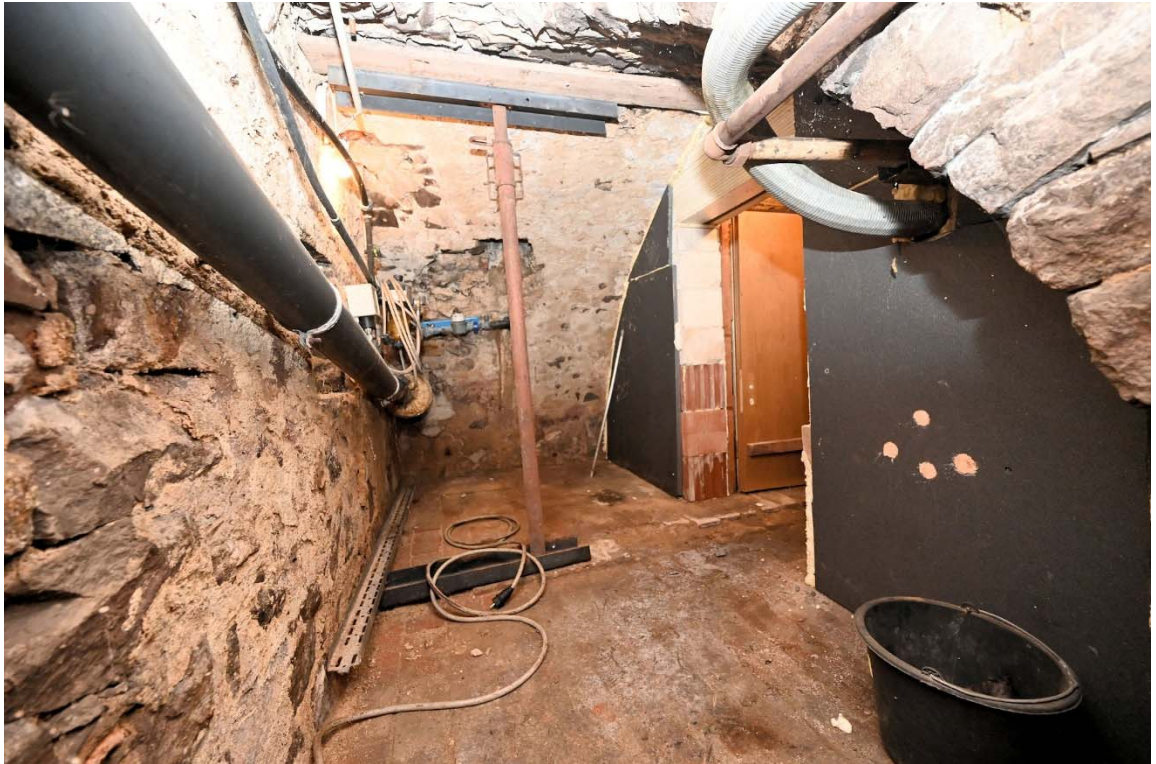
Abb. 9: Teilkeller, Gewölbekeller aus Bruchstein
