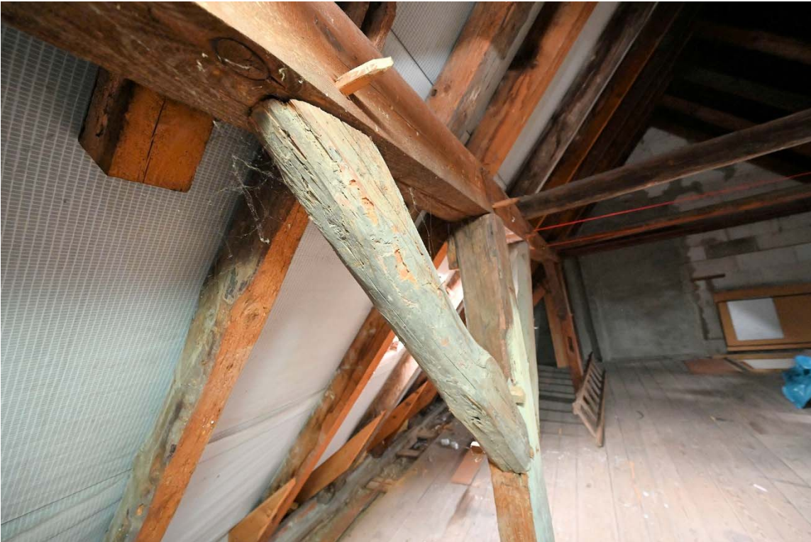
Abb. 23: Dachgeschoss, Kopfband
