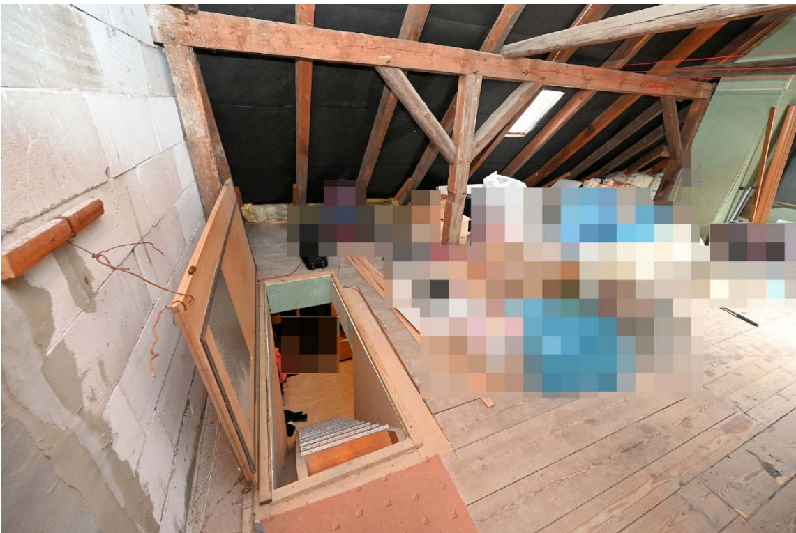
Abb. 20: Dachgeschoss, Bereich Stiege
