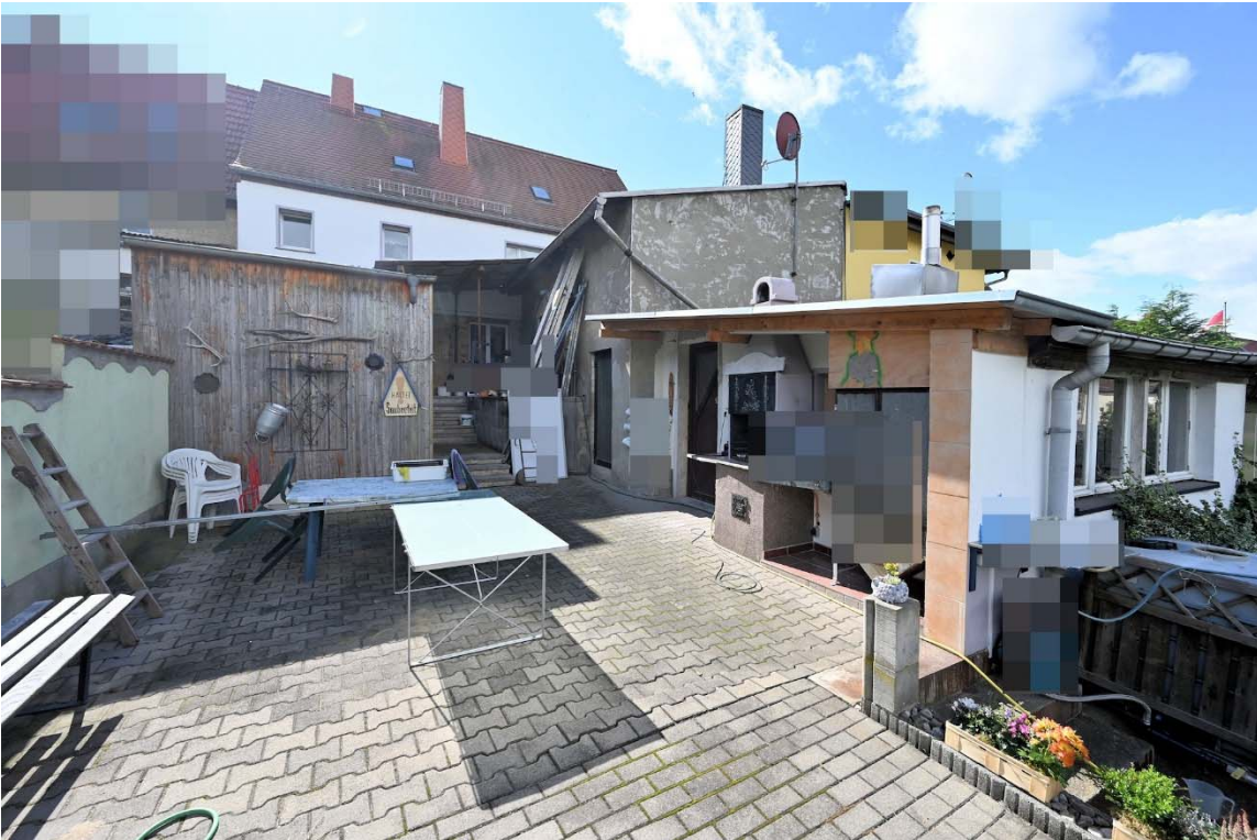
Abb. 31: Hof, Blick auf die Nebengebäude und Rückansicht Wohnhaus
