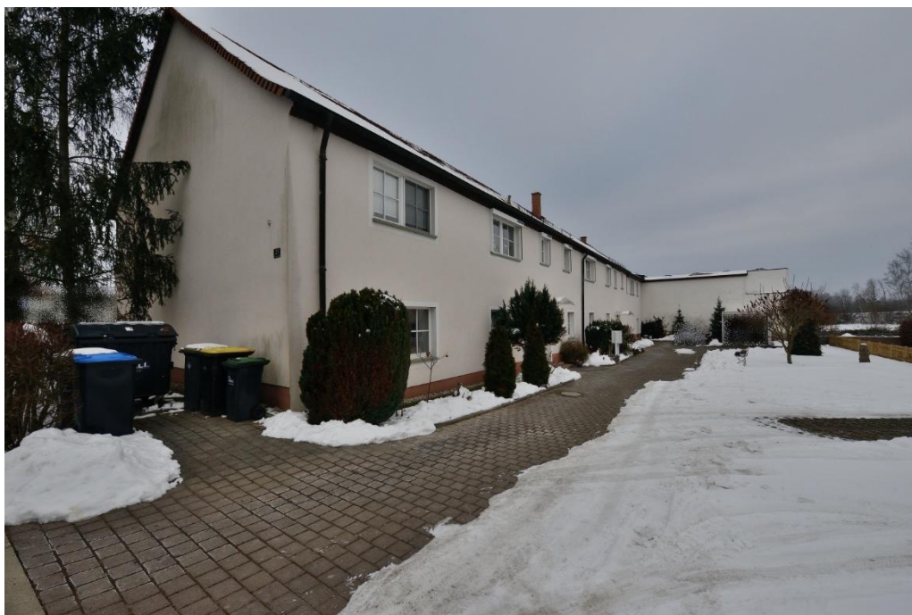
Mietshaus Vorderansichten mit Hauseingang und Stellplätzen
