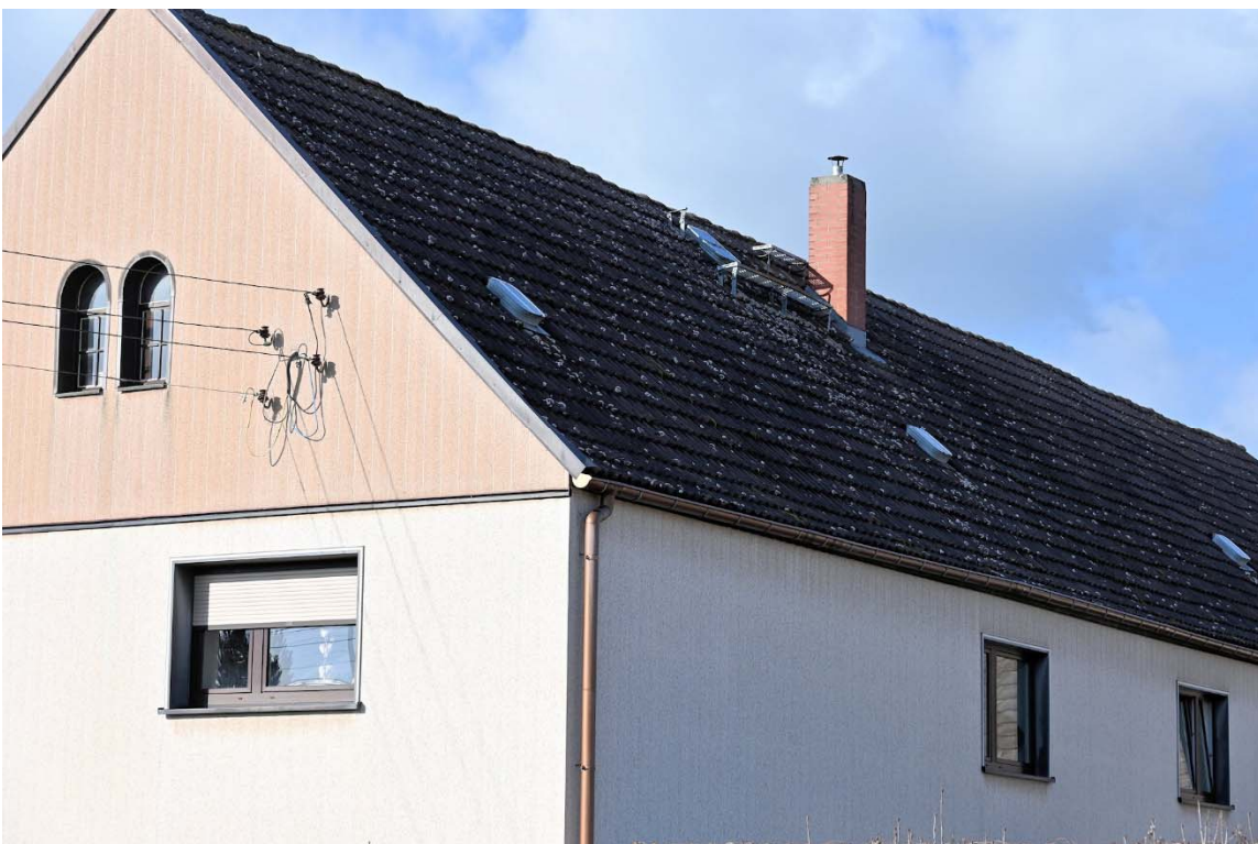
Abb. 4: Grundstücksansicht von der Dorfstraße, Detail Ober- und Dachgeschoss
