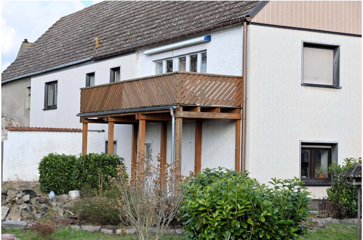
Abb. 9: Grundstücksansicht von der Dorfstraße, Detail Fassade zum Garten
