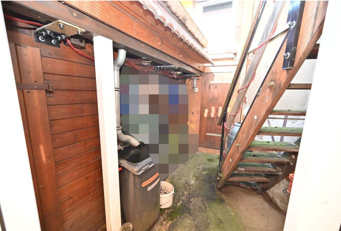
Abb. 23: Innenhof mit Überdachung und Schuppen (B)
