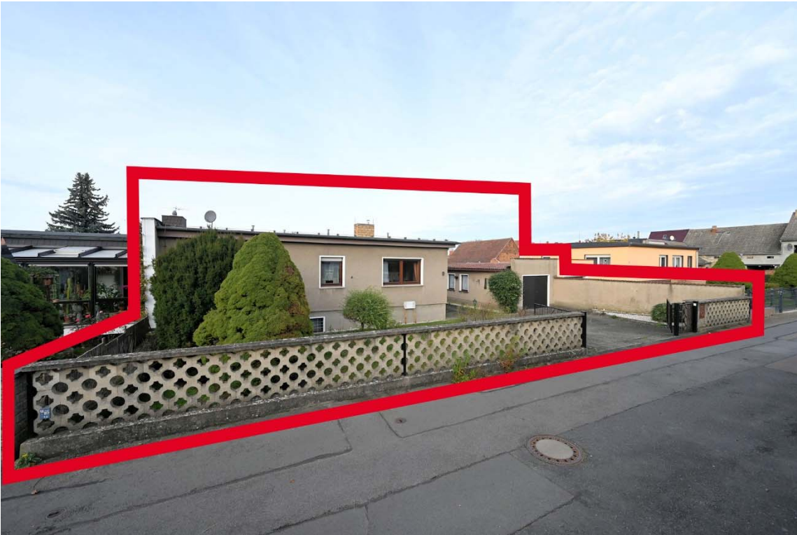
Abb. 3: Grundstücksansicht vom Stadtgraben
