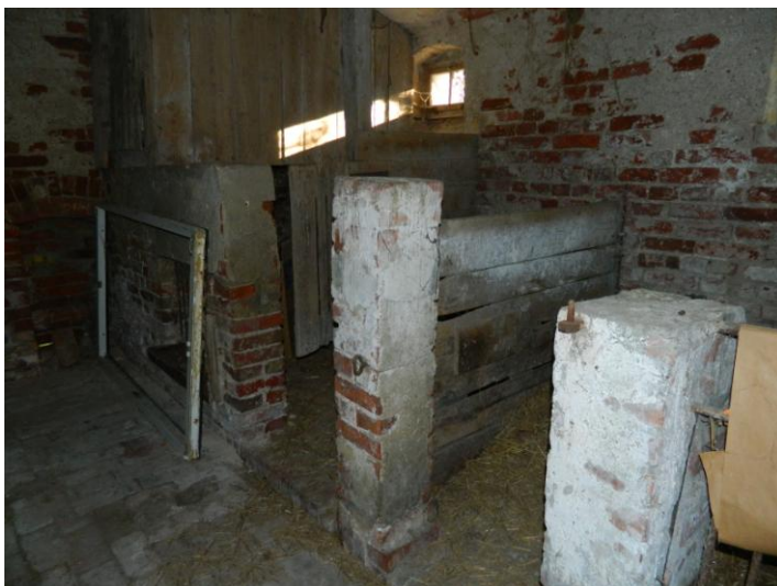
Abb. 12: Mehrzweckgebäude, Innenansicht Stallungen
