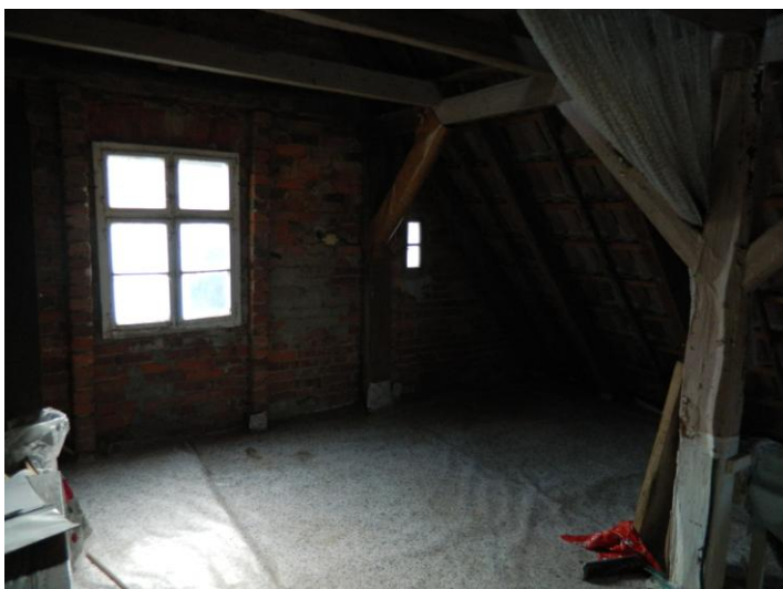
Abb. 6: Dachraum des Wohnhauses
