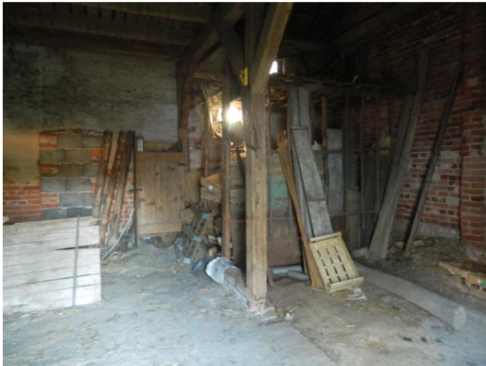
Abb. 10: Mehrzweckgebäude, Innenansicht Scheunenteil
