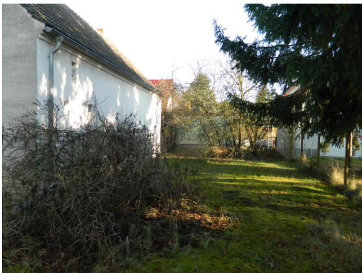
Abb. 9: Freifläche südlich des Mehrzweckgebäudes
