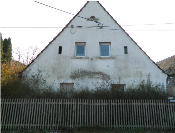
Abb. 1: Wohnhaus, Nordseite; Ansicht von der Weidenhainer Straße
