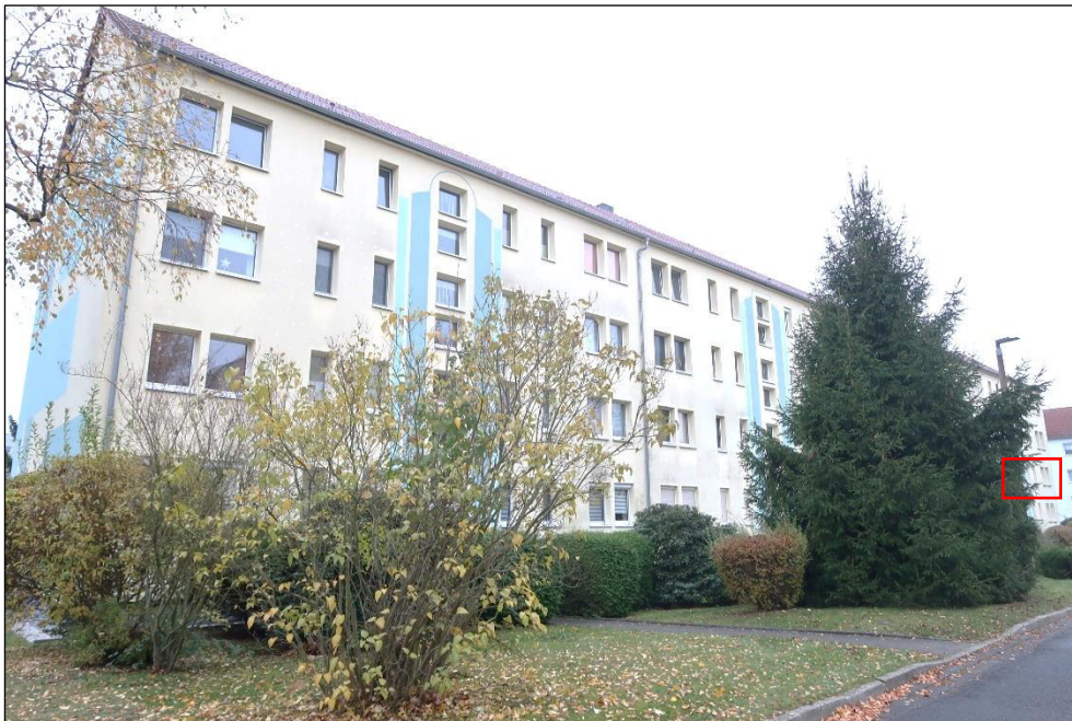
Bild 2: Gesamtansicht des Wohnblocks Goethestraße 2, 4, 6, 8 (rote Umrandung der ETW Nr. 4)
