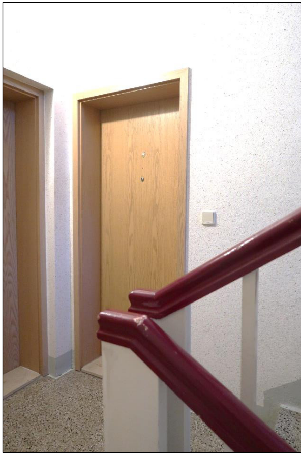
Bild 11: Hauseingang Nr. 2, 1. OG, Zugang zur Wohnung Nr. 4
