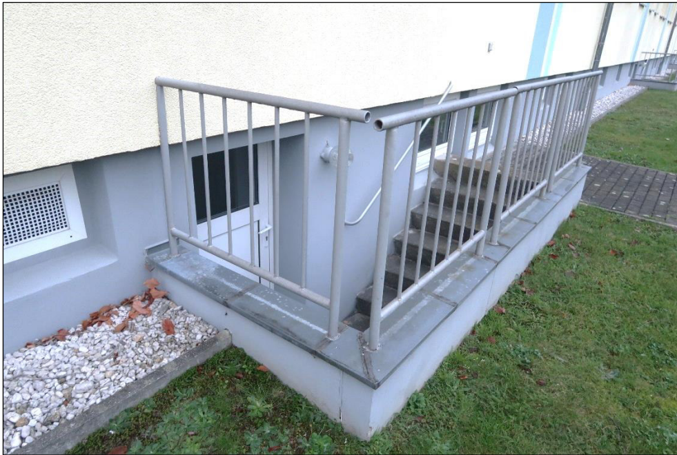
Bild 5: Kelleraußentreppe an der Gebäuderückseite, Hauseingang Nr. 2
