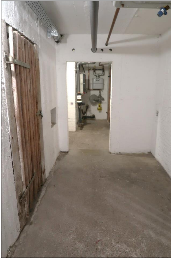
Bild 7: Hauseingang Nr. 2, KG, Flur
