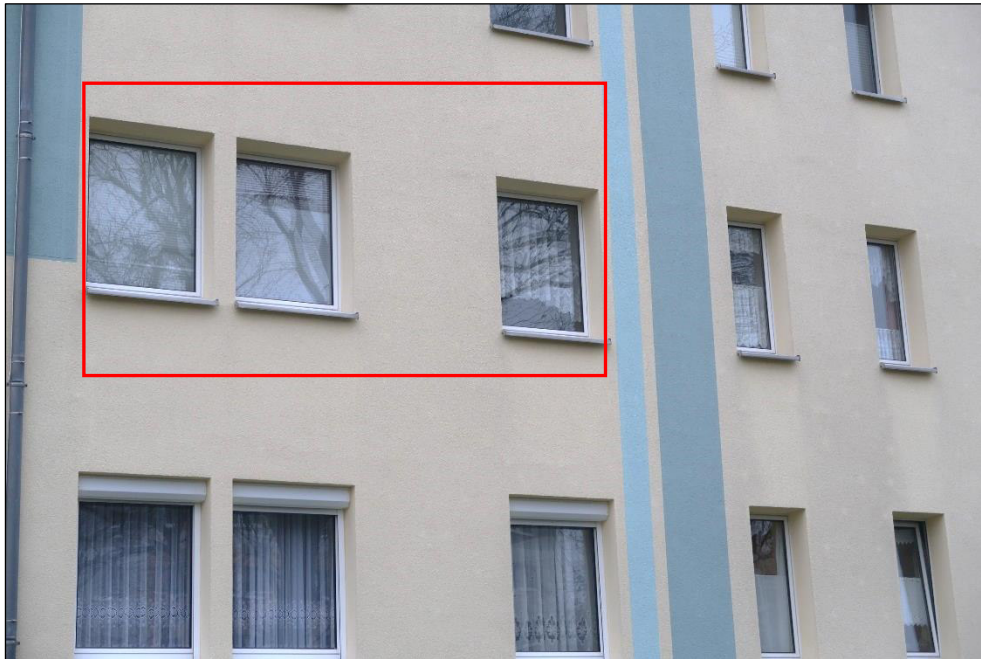
Bild 3: rückwärtige Gebäudeansicht mit Kennzeichnung der Lage der ETW Nr. 4
