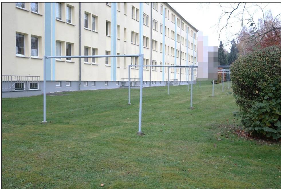
Bild 4: rückwärtige Ansicht des Wohnblocks mit Wäscheplatz (ETW Nr. 4 nicht im Bild)
