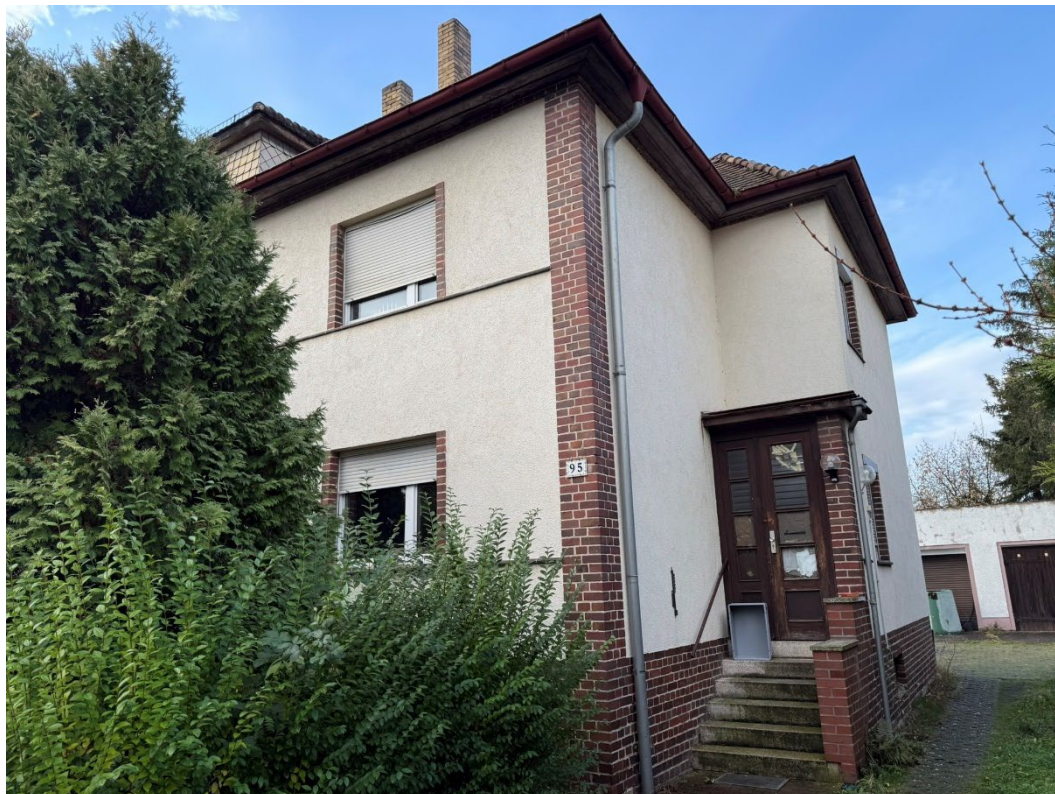
nordöstliche Gebäudeecke mit dem Hauseingang am Nordgiebel
