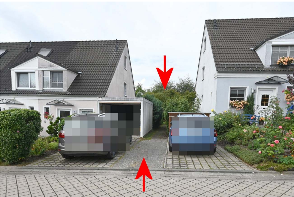
Abb. 7: bspw. Flurstück 109/61 (Verkehrsfläche): Gemeinschaftseigentum , Fußweg zw. der Straße "Am Rain" und Flurstück 109/50 (gemeinschaftl. Grünfläche)
