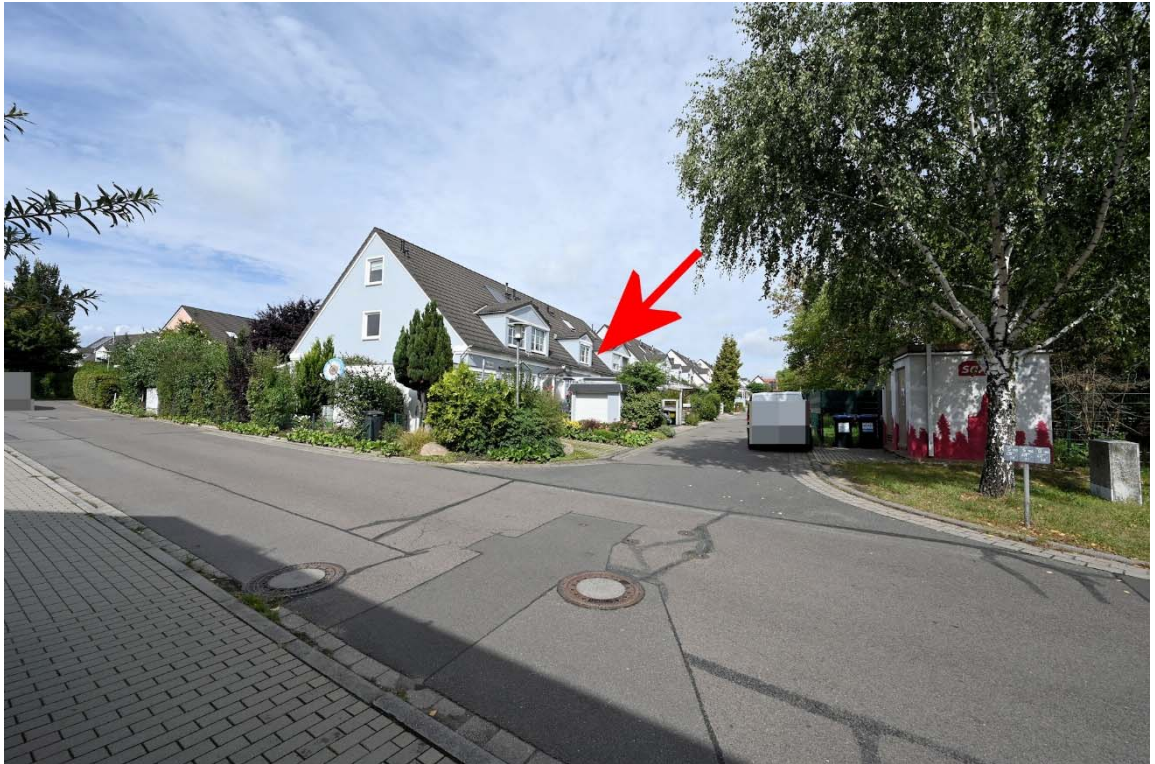
Abb. 1: Wohnumfeld, Blick aus der Straße "An der Landesgrenze", Kennzeichnung Bewertungsobjekt (Flurstück 109/80, RMH)
