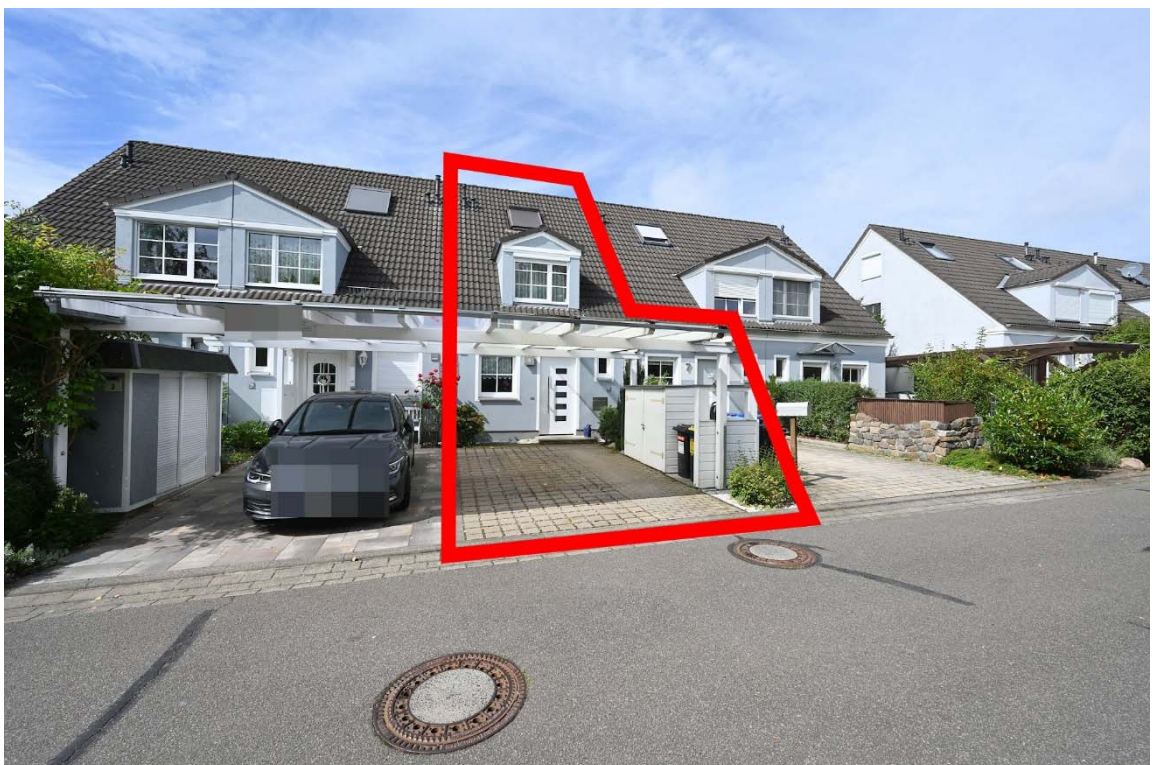
Abb. 2: Flurstück 109/80 (RMH): Grundstücksansicht aus der Straße "Am Rain", ungefähre Kennzeichnung Bewertungsobjekt
