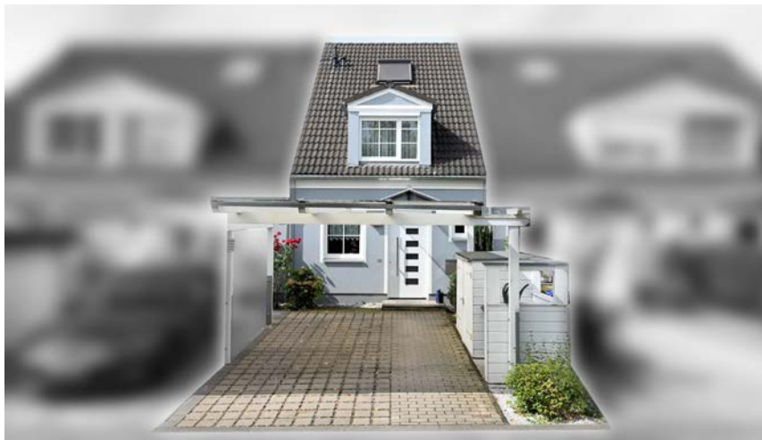
GB-Blatt 4645: Ansicht Reihemittelhaus von der Straße
