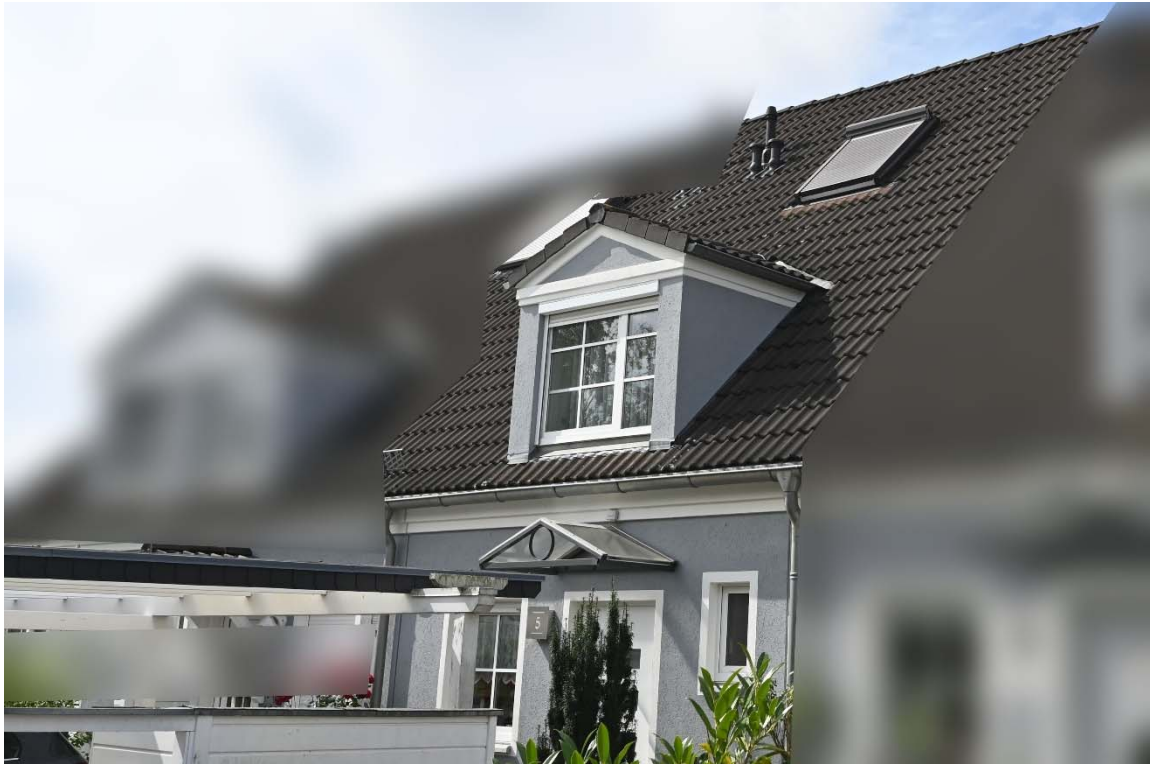
Abb. 4: Flurstück 109/80 (RMH): Gebäudeteilansicht aus der Straße "Am Rain"
