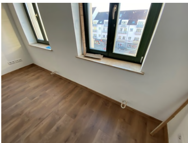
fehlende Heizkörper
