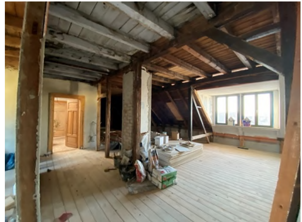
straßenseitige Dachgaube und Baumaterial
