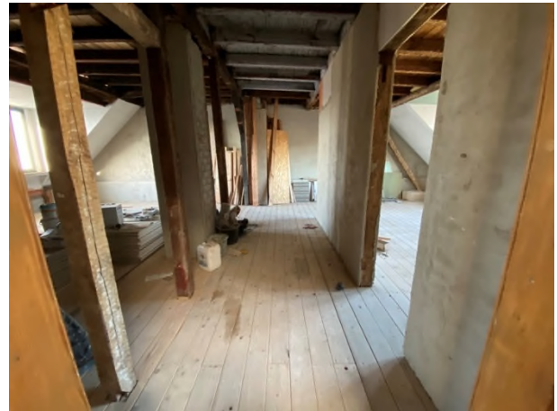
nicht ausgebautes DG
