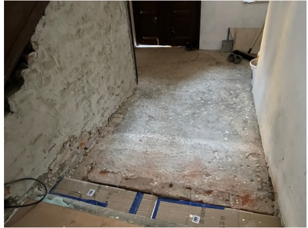
Treppenhaus im EG
