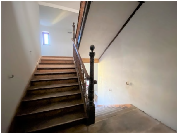
nicht fertig gestellte Treppenhaus zum DG
