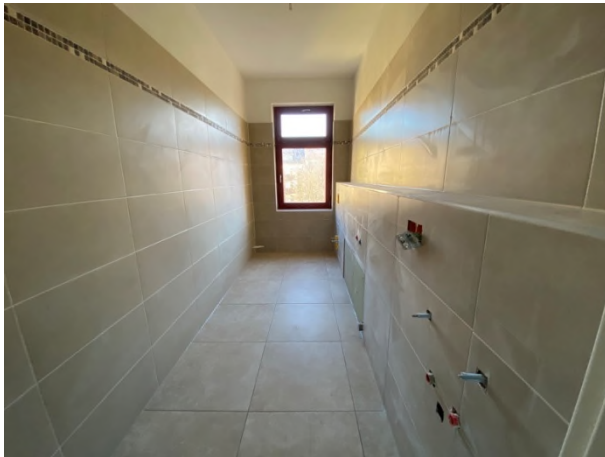
Bad ohne Sanitärausstattung/ Heizkörper
