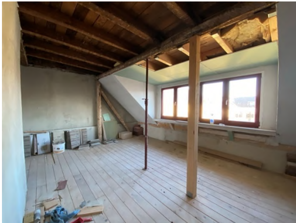
hofseitige Dachgaube mit neuen Fenstern
