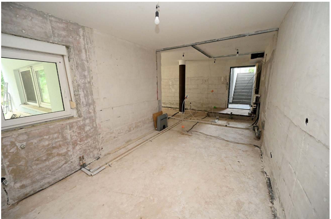
Abb. 10: SE Nr. ①⑥ (Souterrain), urspr. Schlafzimmer, Blick zur Wohnungseingangstür
