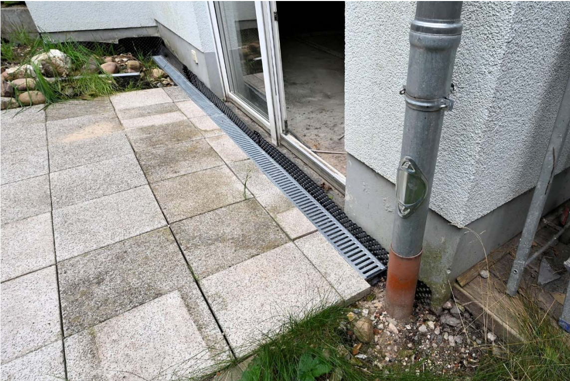
Abb. 19: zu SE Nr. ①⑥ (Souterrain), Terrasse, nachträgliche Abdichtungsmaßnahmen (nach Norden)
