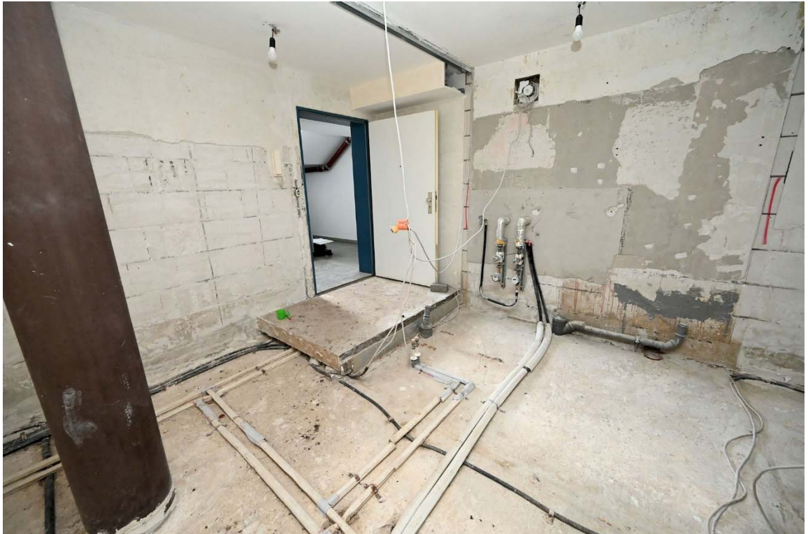
Abb. 9: SE Nr. ①⑥ (Souterrain), Blick zur Wohnungseingangstür, rechts davon das urspr. Bad/WC
