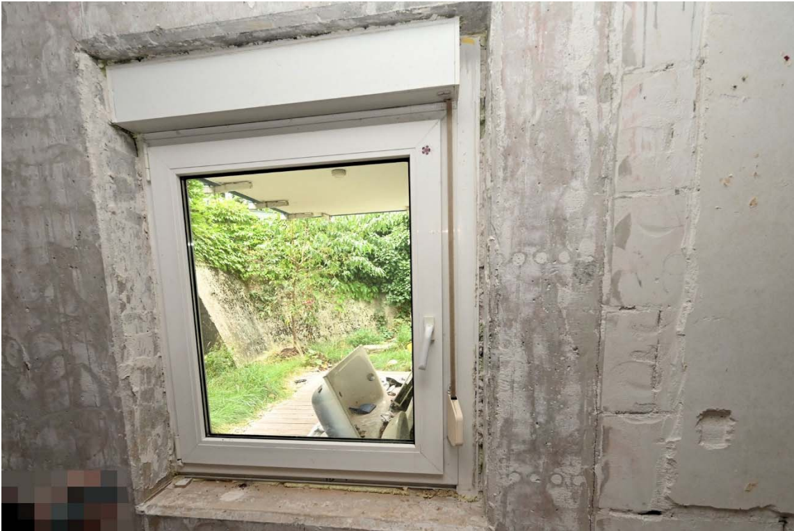
Abb. 11: SE Nr. ①⑥ (Souterrain), urspr. Schlafzimmer, Detail Fenster (Versatz)
