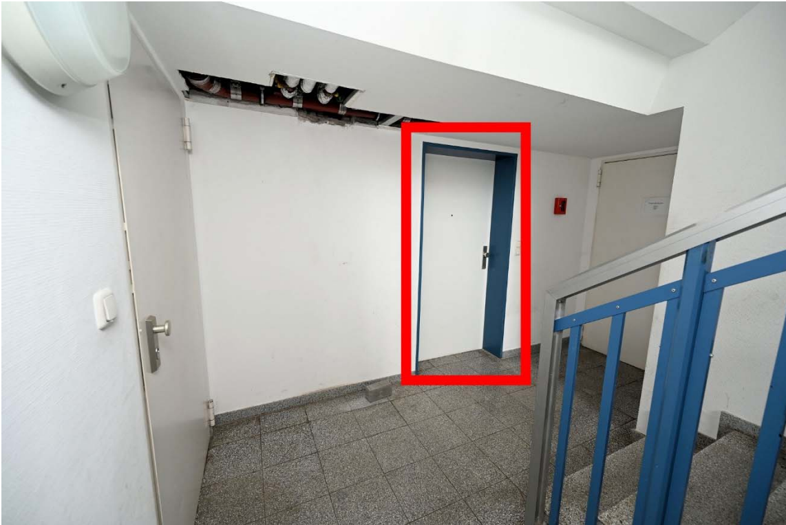
Abb. 7: Gemeinschaftseigentum: Kellergeschoss, Treppenhaus, Kennzeichnung Wohnungseingangstür SE Nr. ①⑥
