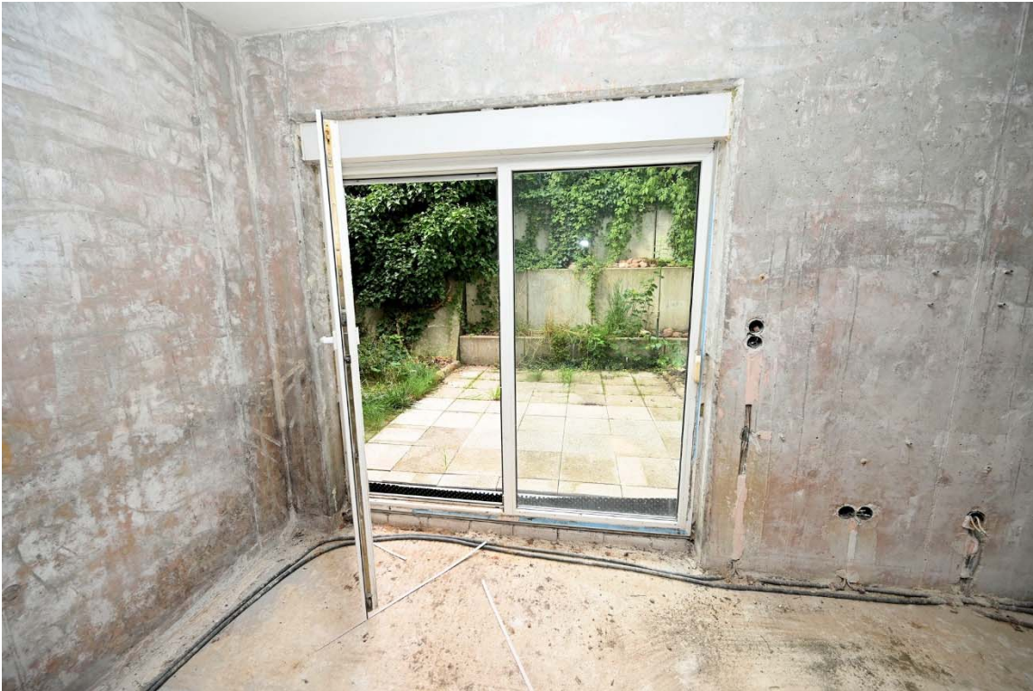
Abb. 15: SE Nr. ①⑥ (Souterrain), urspr. Wohnzimmer, Terrassentür
