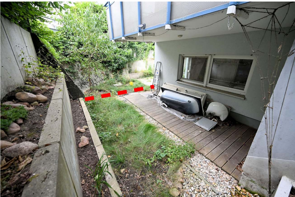
Abb. 20: Gemeinschaftseigentum: Blick auf den Teil der Terrasse, der formal nicht SE Nr. ①⑥ zugeordnet ist; gebrauchte Baumaterialien als mögl. Zubehör
