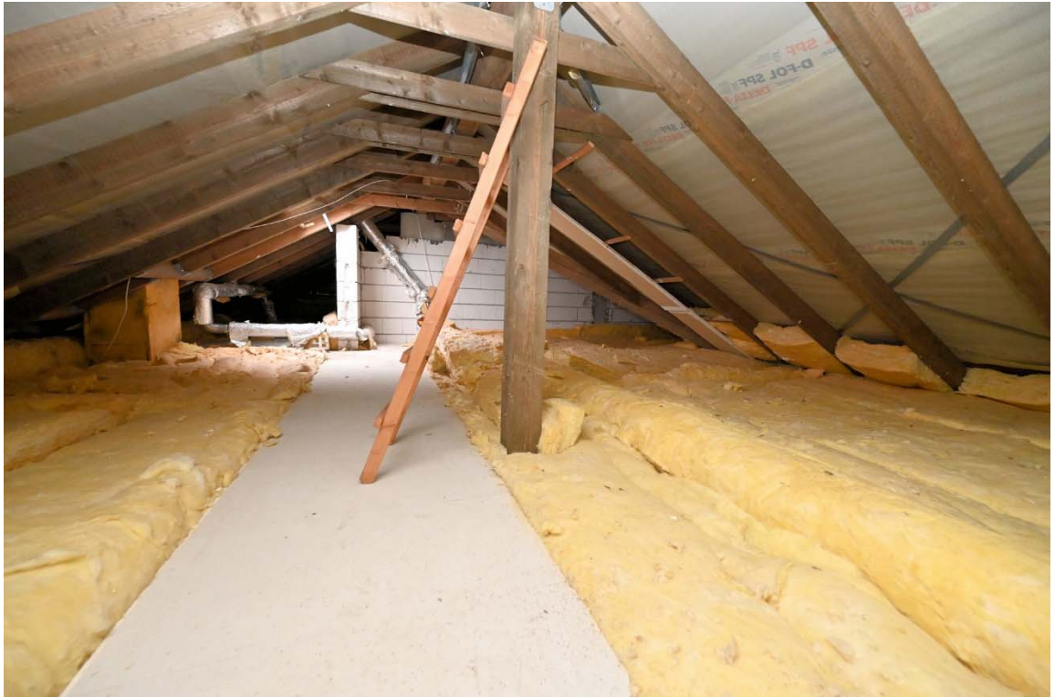
Abb. 25: Gemeinschaftseigentum: Dachspitz in der Gebäudehälfte 9b
