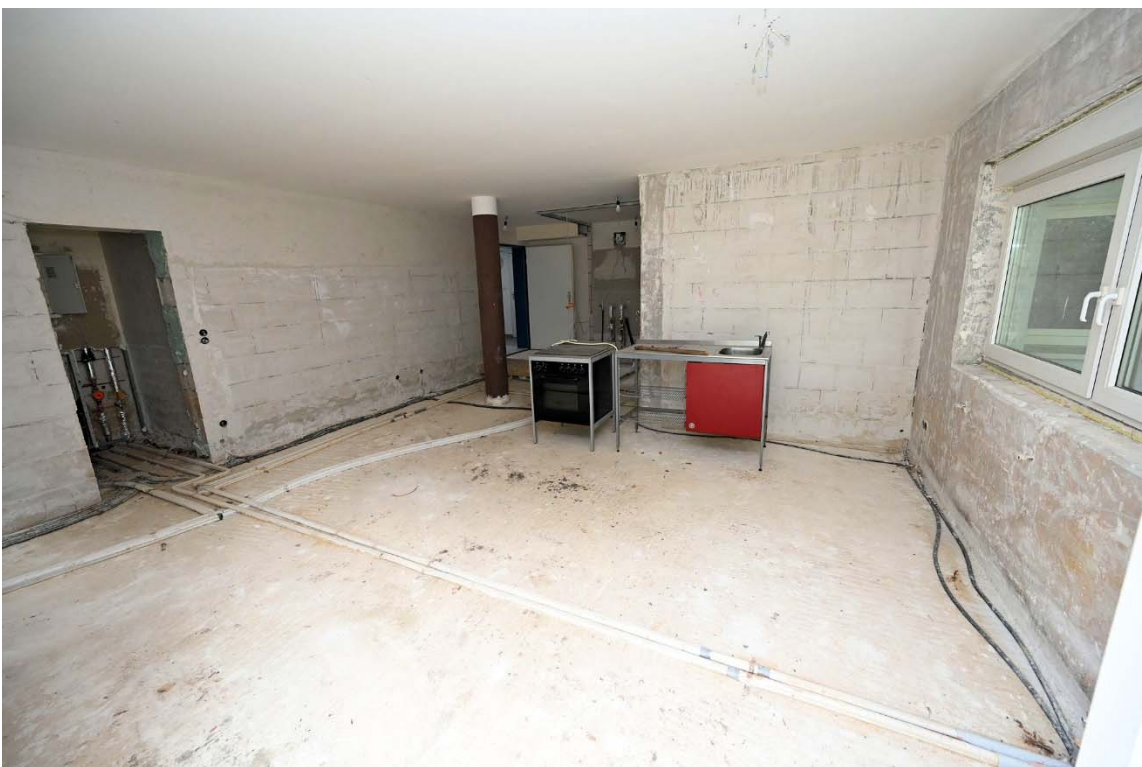
Abb. 12: SE Nr. ①⑥ (Souterrain), urspr. Wohnzimmer, Blick zur Wohnungseingangstür, links der ASR
