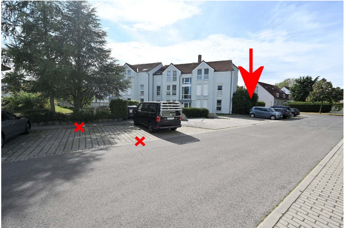
Abb. 1: Gemeinschaftseigentum: Grundstücksansicht vom Lärchenweg, Kennzeichnung Grenzpunkte im Bereich von Stellflächen und SE Nr. ①⑥ (Souterrain)
