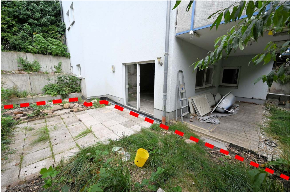
Abb. 17: zu SE Nr. ⑩ (Souterrain): Terrasse, Kennzeichnung SNR Terrasse nach Aktenlage; gebrauchte Baumaterialien als mögl. Zubehör
