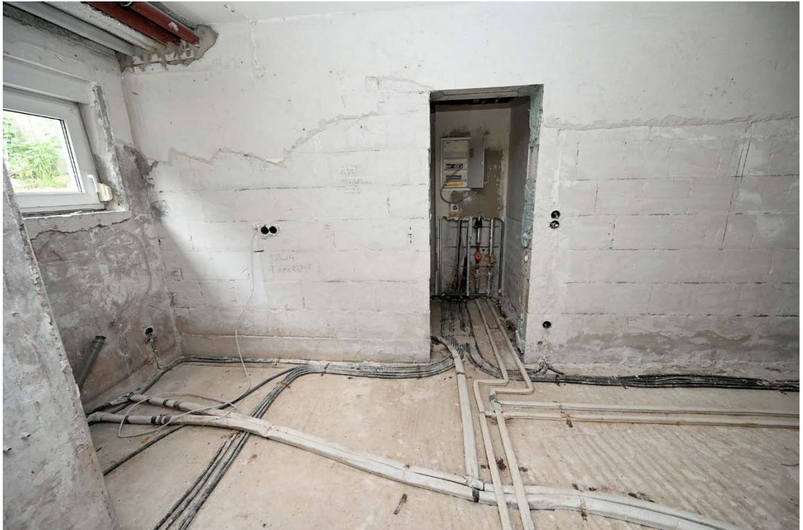
Abb. 13: SE Nr. ①⑥ (Souterrain), urspr. Wohnzimmer, Blick zum Abstellraum, links die Kochecke
