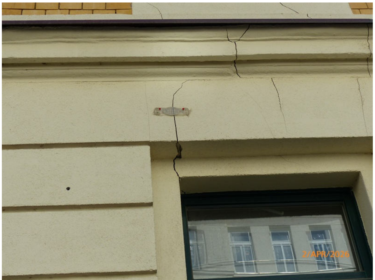
(Fenstersturz im EG)
