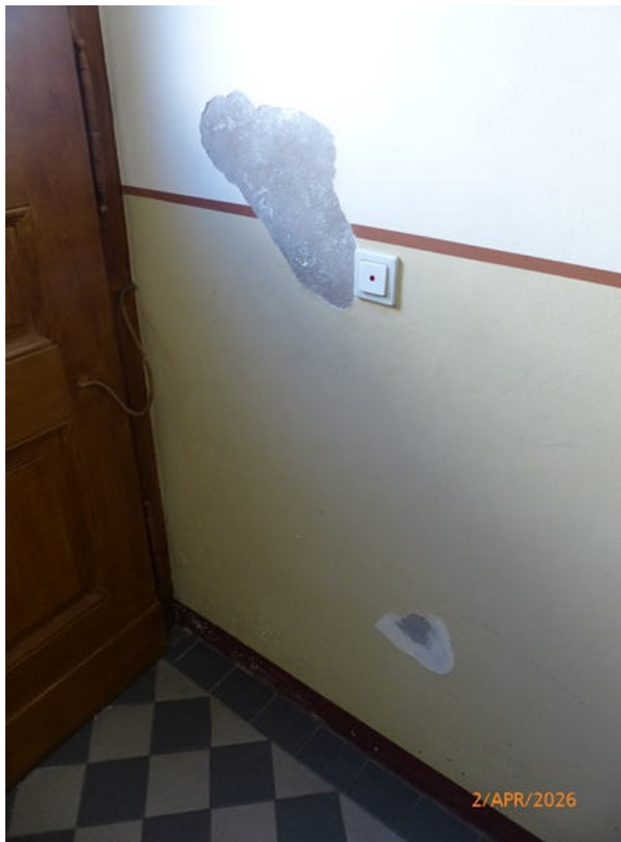
Foto 27: Putz- und Farbabplatzungen an der Wand im TH/Hauseingangsbereich
