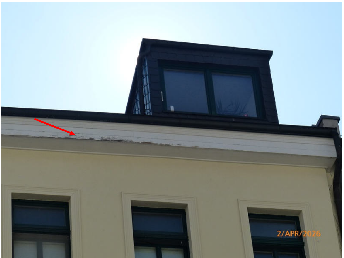
Foto 42: Farbabplatzungen straßenseitiger Dachkanten - südlicher Fassadenbereich
