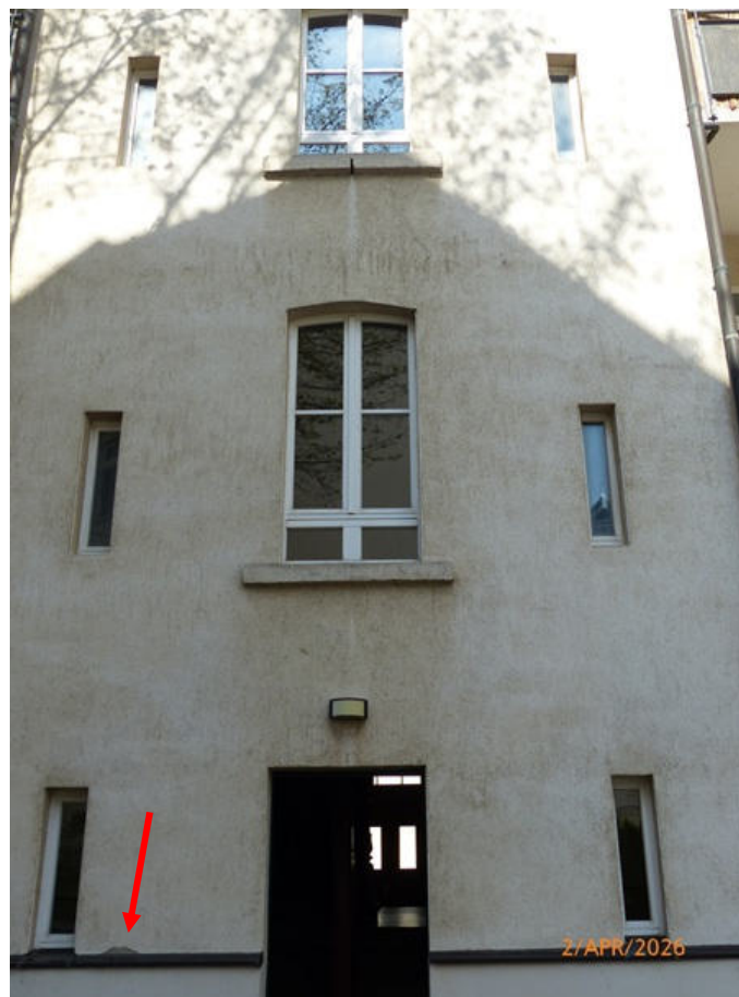
Foto 31: verschmutzte hofseitige Fassade, kleiner Putzschaden über Sockelblech (GE)
