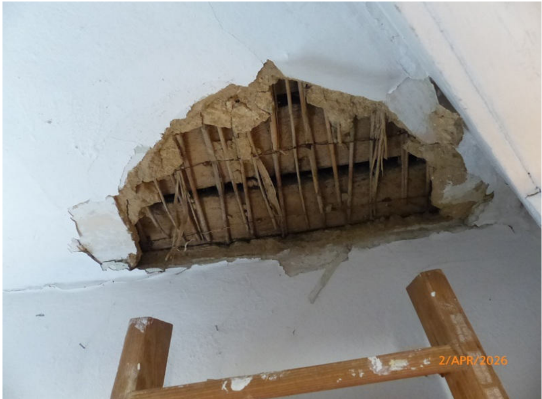
Foto 27: Putz- und Farbabplatzungen an der Wand im TH/Hauseingangsbereich
