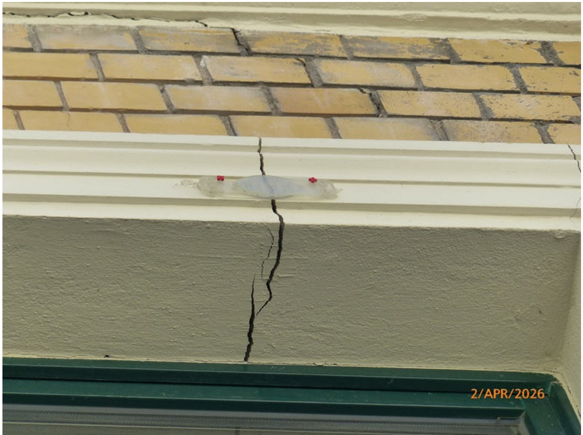
(Fenstersturz im 2. OG)
