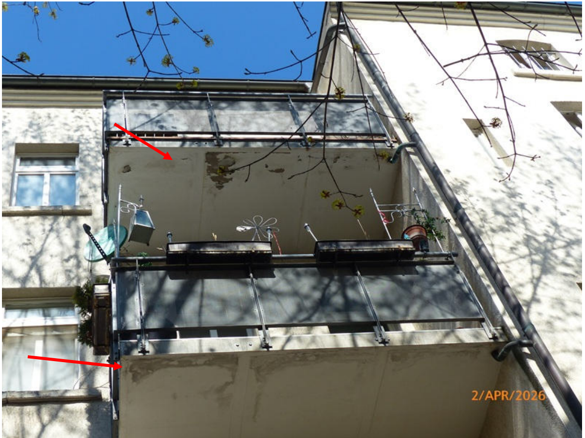
Foto 42: Farbabplatzungen straßenseitiger Dachkanten - südlicher Fassadenbereich
