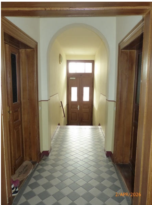
Fotos 9 und 10: Treppenhaus im Erdgeschoss (GE)
