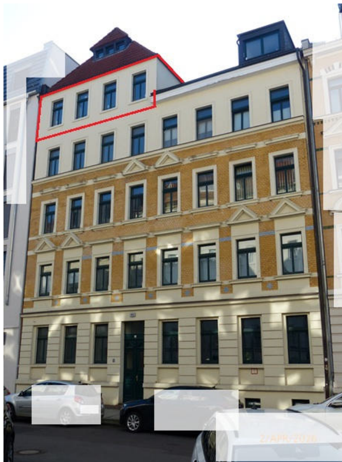
Foto 4: straßenseitige Ansicht Mehrfamilienhaus (Gemeinschaftseigentum - GE)
