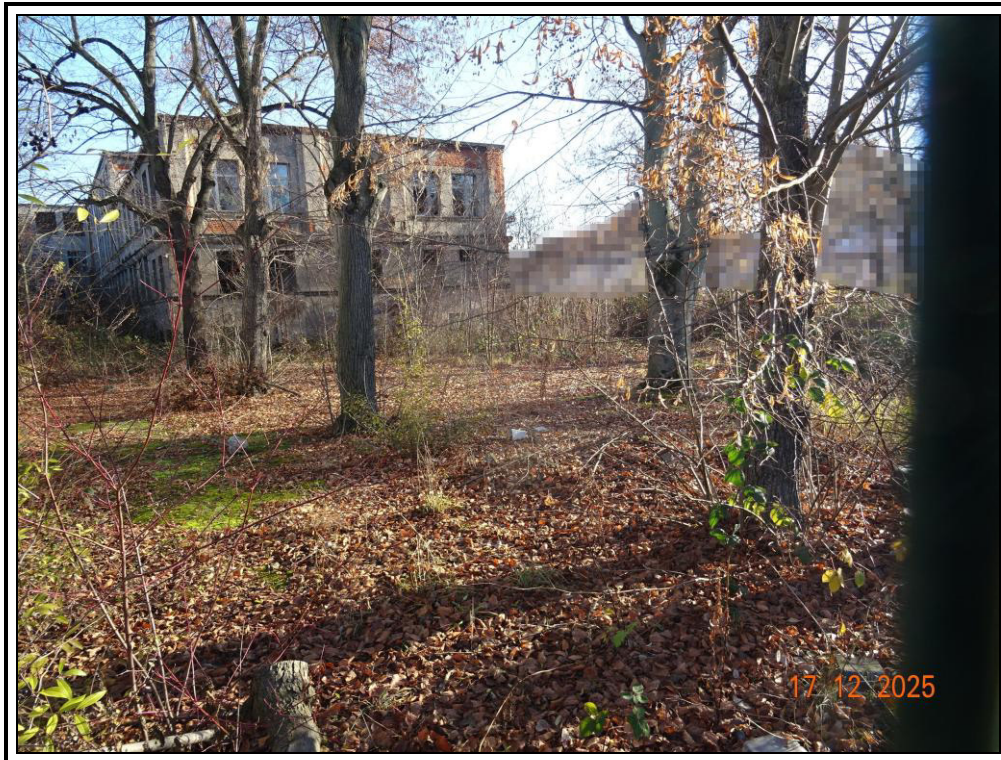
Foto 3: Freifläche nordwestlich des Büro- und Verwaltungsgebäudes
