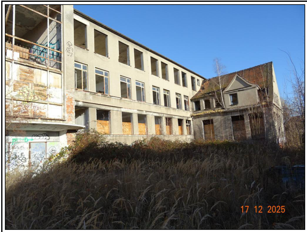
Foto 13: südliche Teilansicht des Büro- und Verwaltungsgebäudes (östlicher Gebäudeteil)
