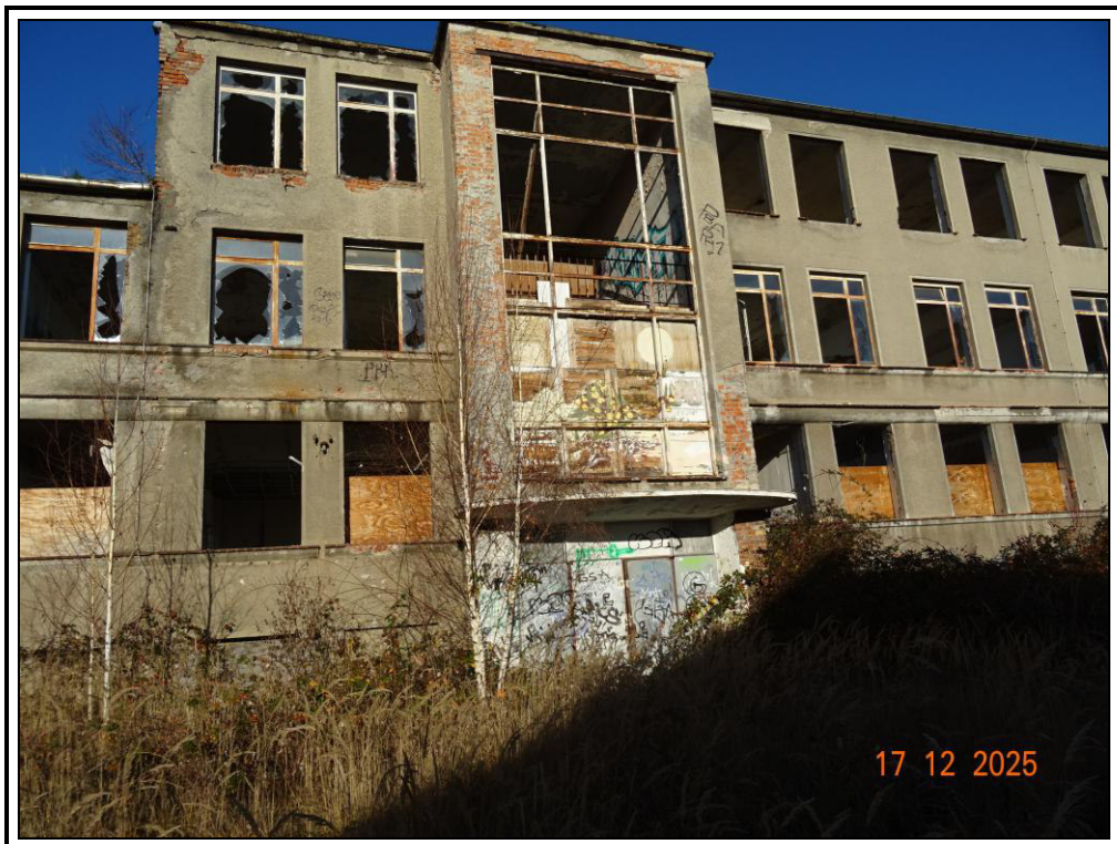
Foto 12: südliche Teilansicht des Büro- und Verwaltungsgebäudes (zentraler Gebäudeteil)
