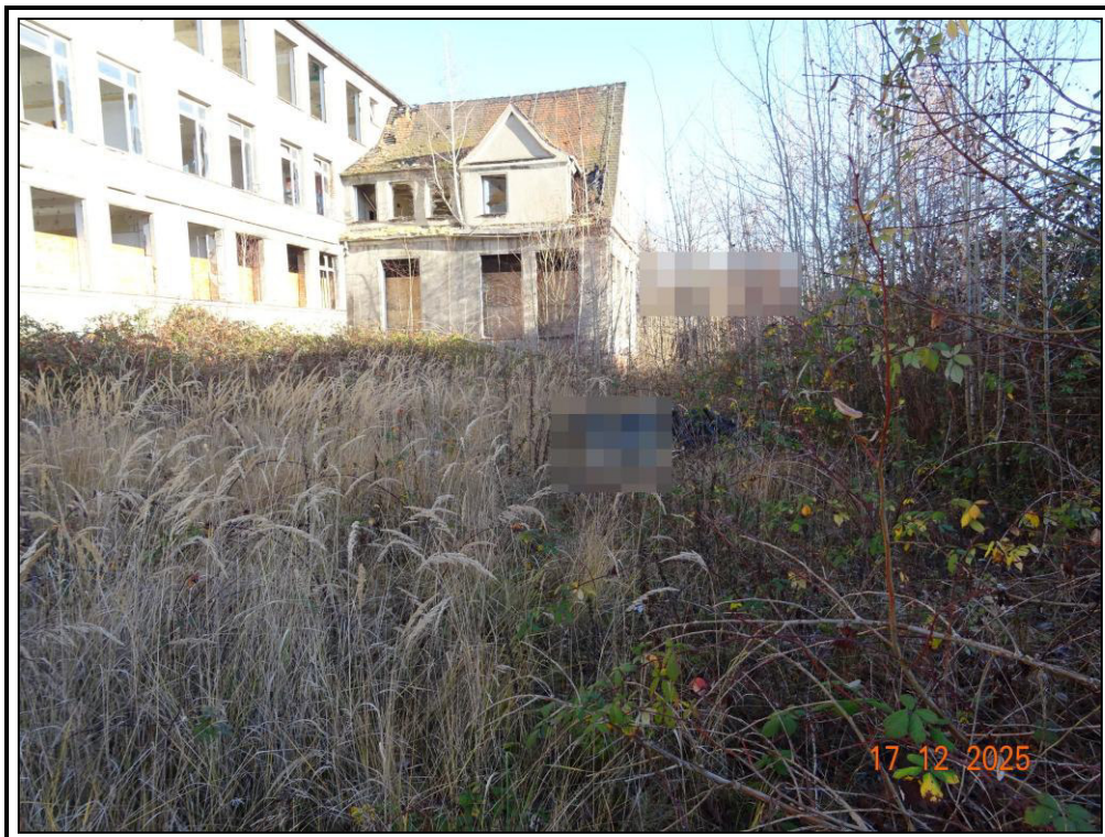
Foto 6: Freifläche südlich des Büro- und Verwaltungsgebäudes
