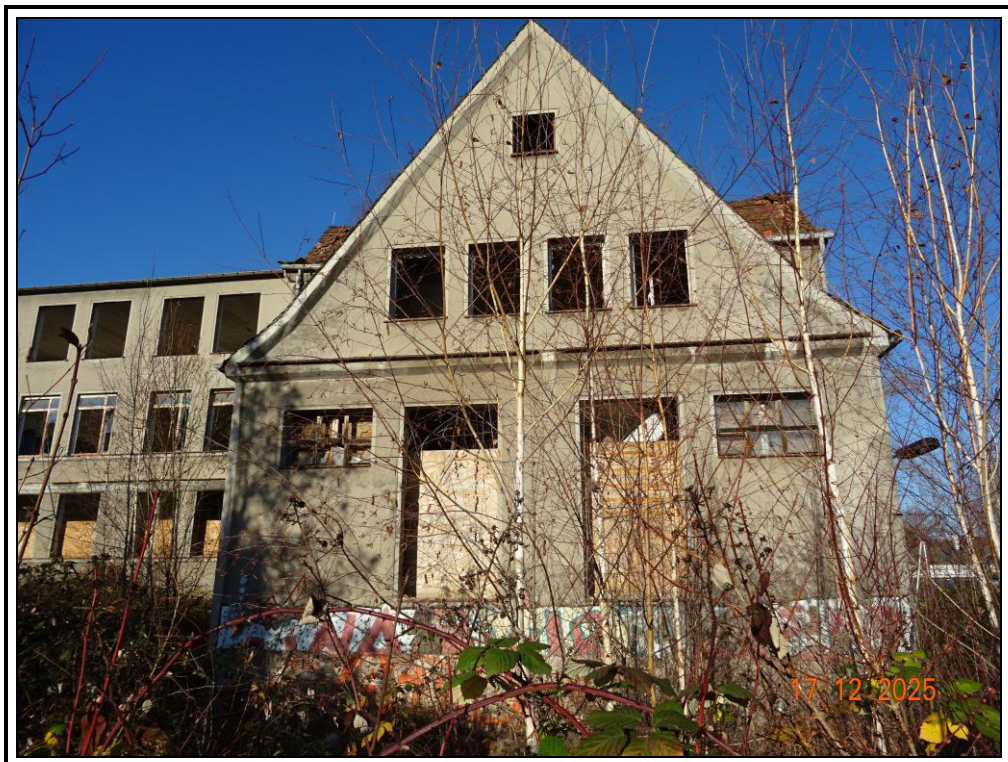
Foto 14: südliche Teilansicht des Büro- und Verwaltungsgebäudes (Seitenflügel)
