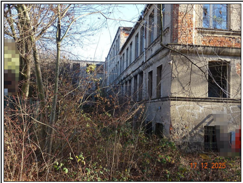
Foto 8: nordwestliche Teilansicht des Büro- und Verwaltungsgebäudes
