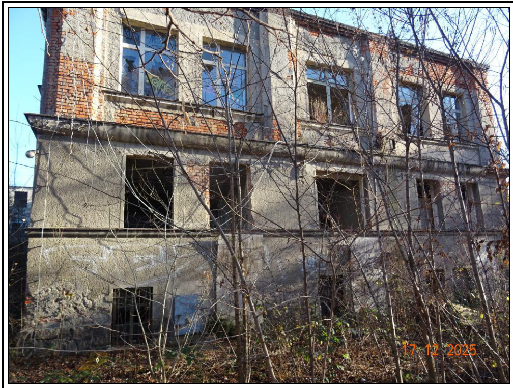
Foto 9: westliche Teilansicht des Büro- und Verwaltungsgebäudes
