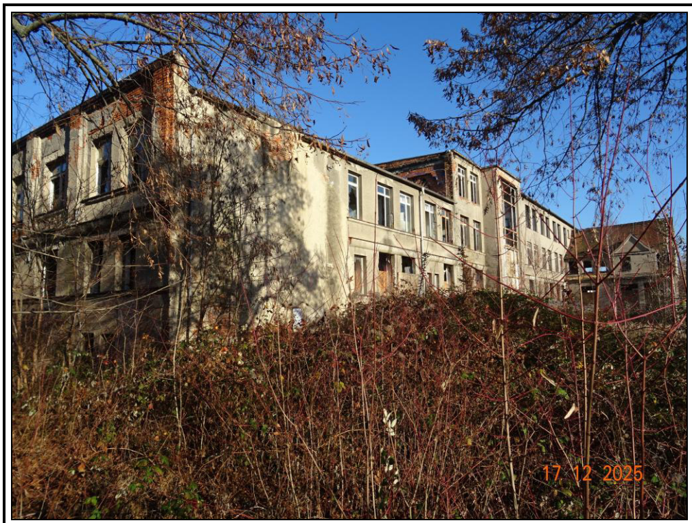
Foto 10: südwestliche Ansicht des Büro- und Verwaltungsgebäudes
