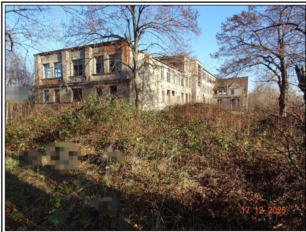
Foto 4: Freifläche westlich des Büro- und Verwaltungsgebäudes
