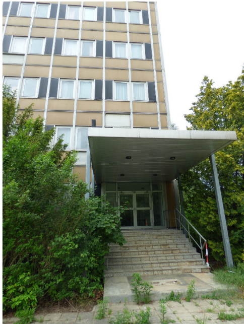
Bild 5: nördlicher Hauseingang an der Gebäudeostseite
