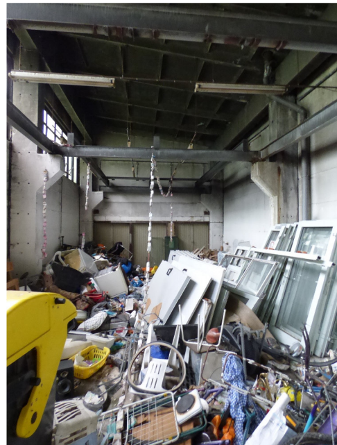
Bild 12: Zustand im Inneren des Heizhauses
