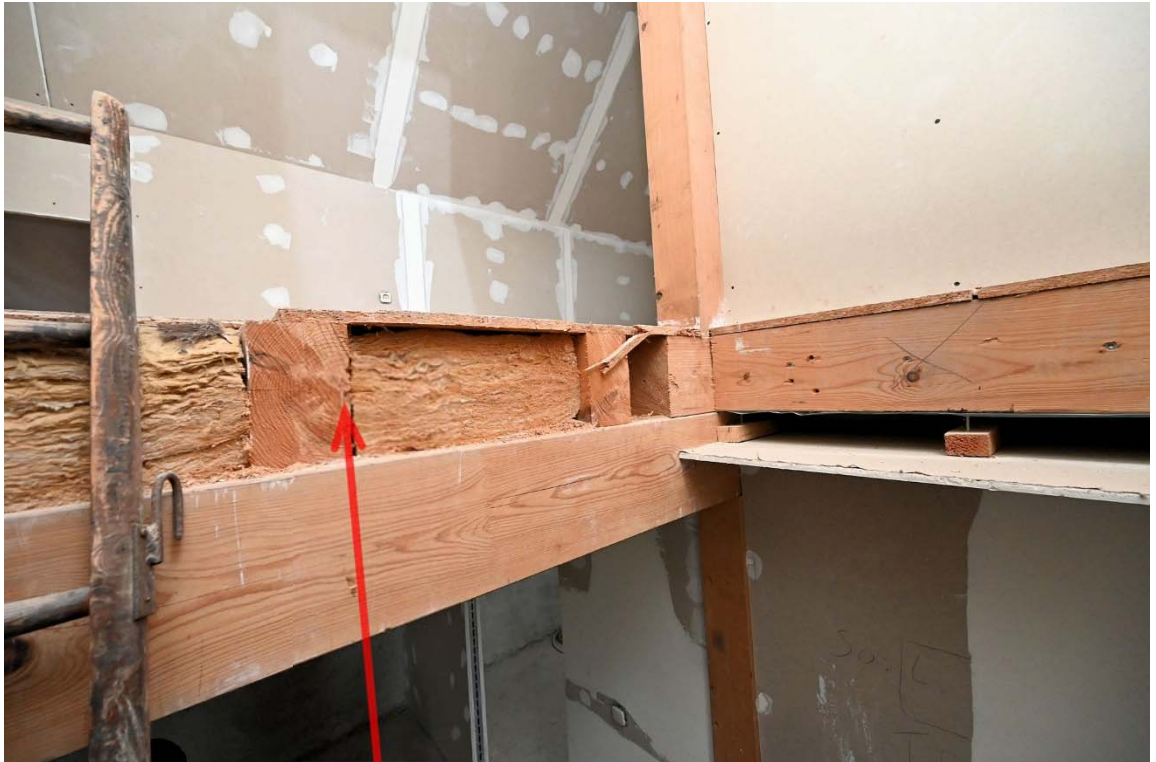
Abb. 17: Wohnhaus, Treppenauge Ober-/ Dachgeschoss, Konstruktion Decke
