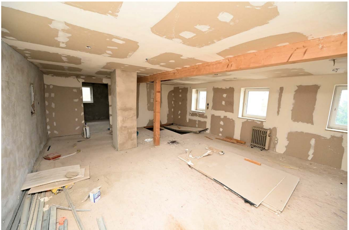
Abb. 14: Wohnhaus, Obergeschoss, großes Zimmer (entgegengesetzter Blick)
