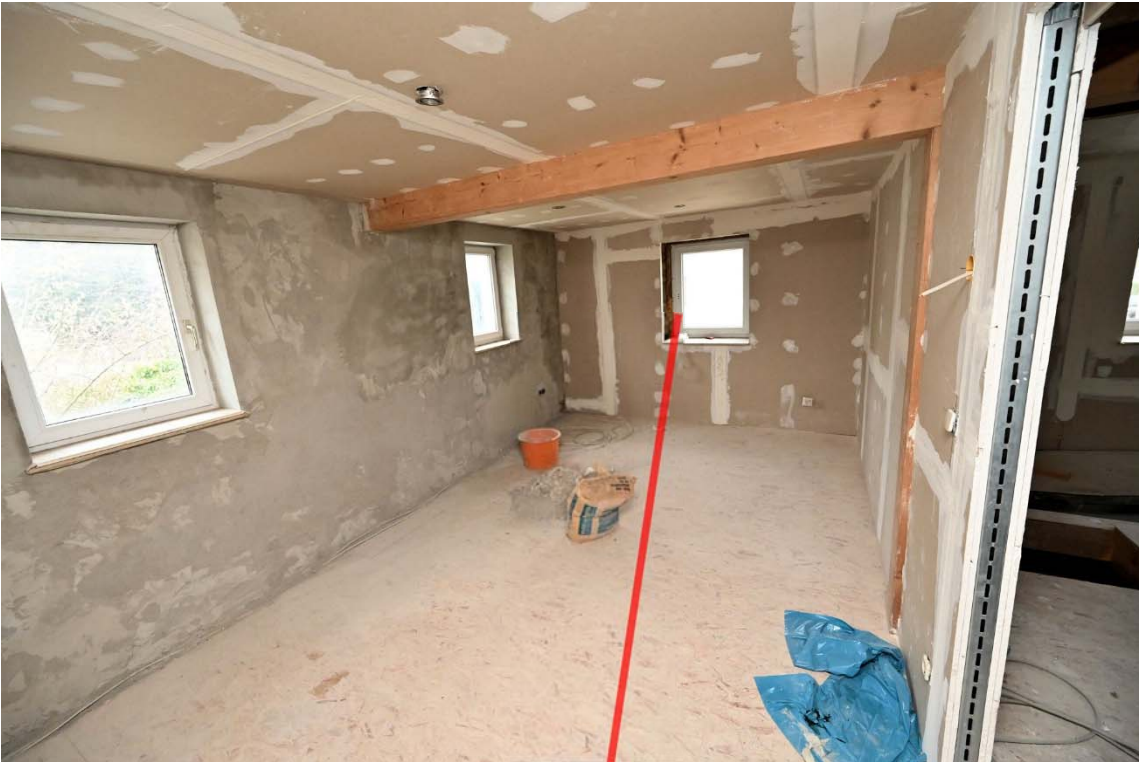
Abb. 15: Wohnhaus, Obergeschoss, kleines Zimmer
