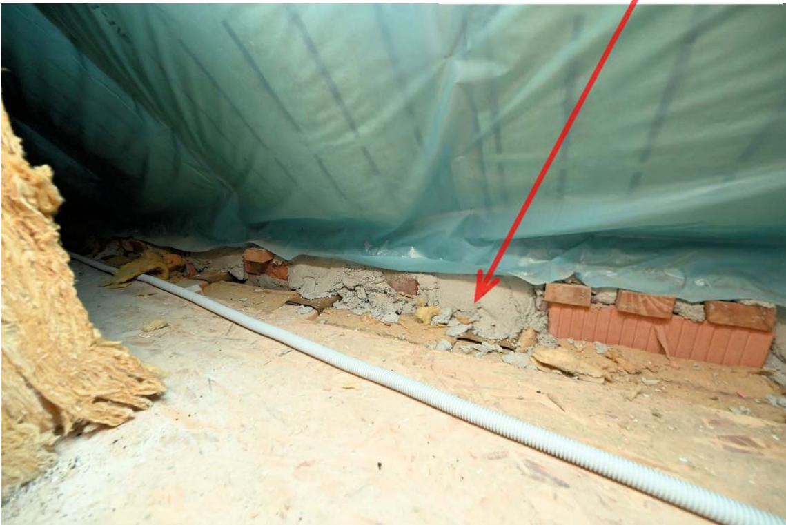
Abb. 20: Wohnhaus, Dachgeschoss, nördliches Zimmer, Blick hinter die Abseite (Deckenbalken neu, Dachwärmesdämmung zw. den Sparren)
