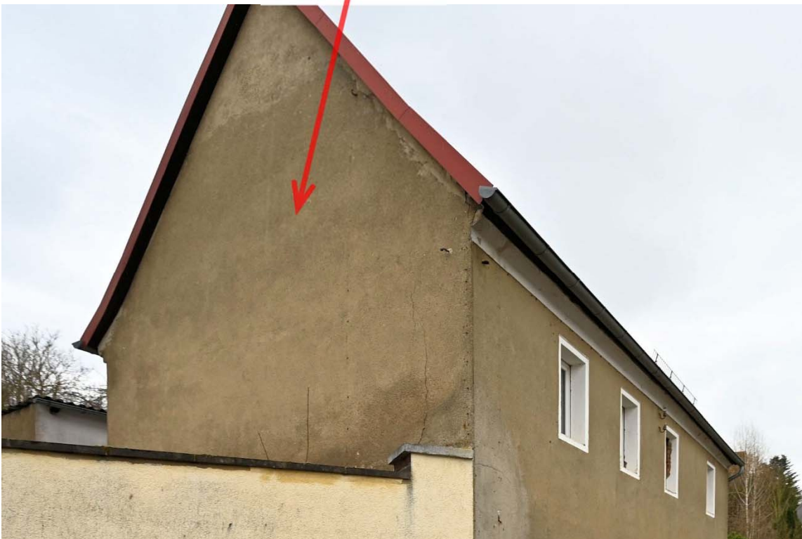
Abb. 4: Ansicht Wohnhaus von der Straße, Giebel nach Nordwesten
