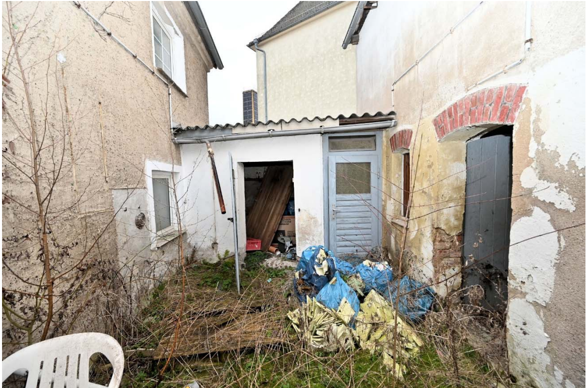
Abb. 21: Schuppen (zw. Wohnhaus und ehem. Stall)
