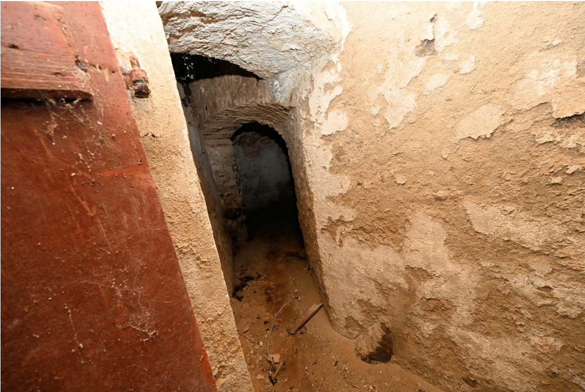
Abb. 27: Zugang zum Erdkeller vom ehem. Stall aus
