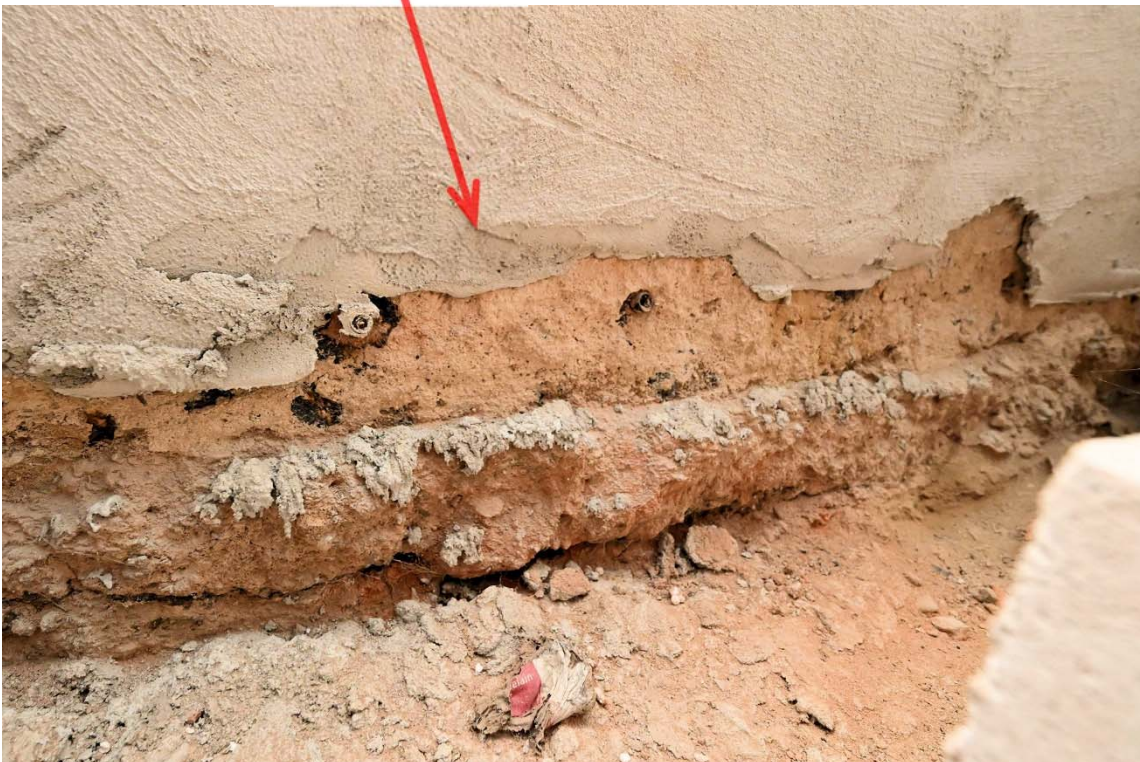
Abb. 12: Wohnhaus, Erdgeschoss, geplante Küche, Detail Bohrlöcher von Mauerwerksinjektion (mit Druck)
