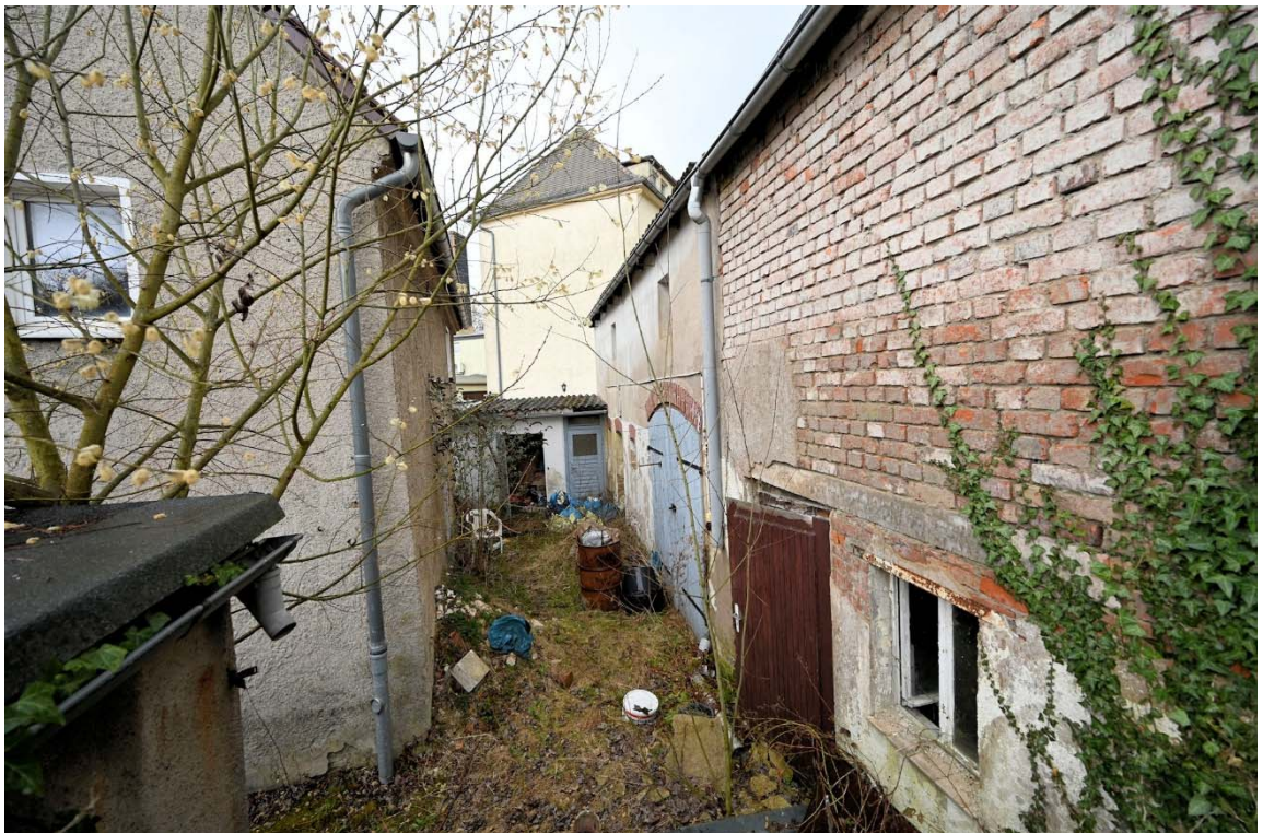
Abb. 22: Hof und ehem. Stall auf der rechten Seite
