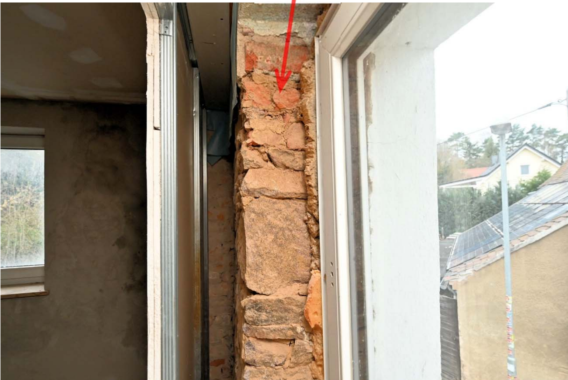
Abb. 16: Wohnhaus, Obergeschoss, kleines Zimmer, Vorwand
