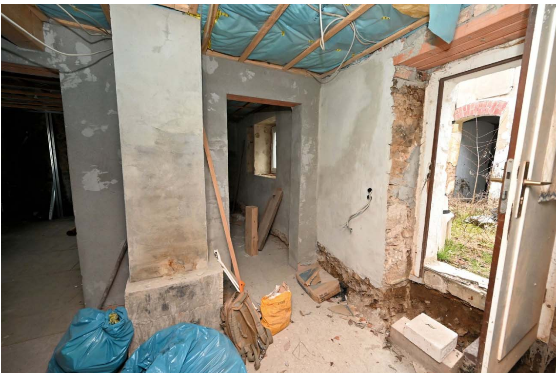
Abb. 8: Wohnhaus, Erdgeschoss, Flur mit Hauseingang
