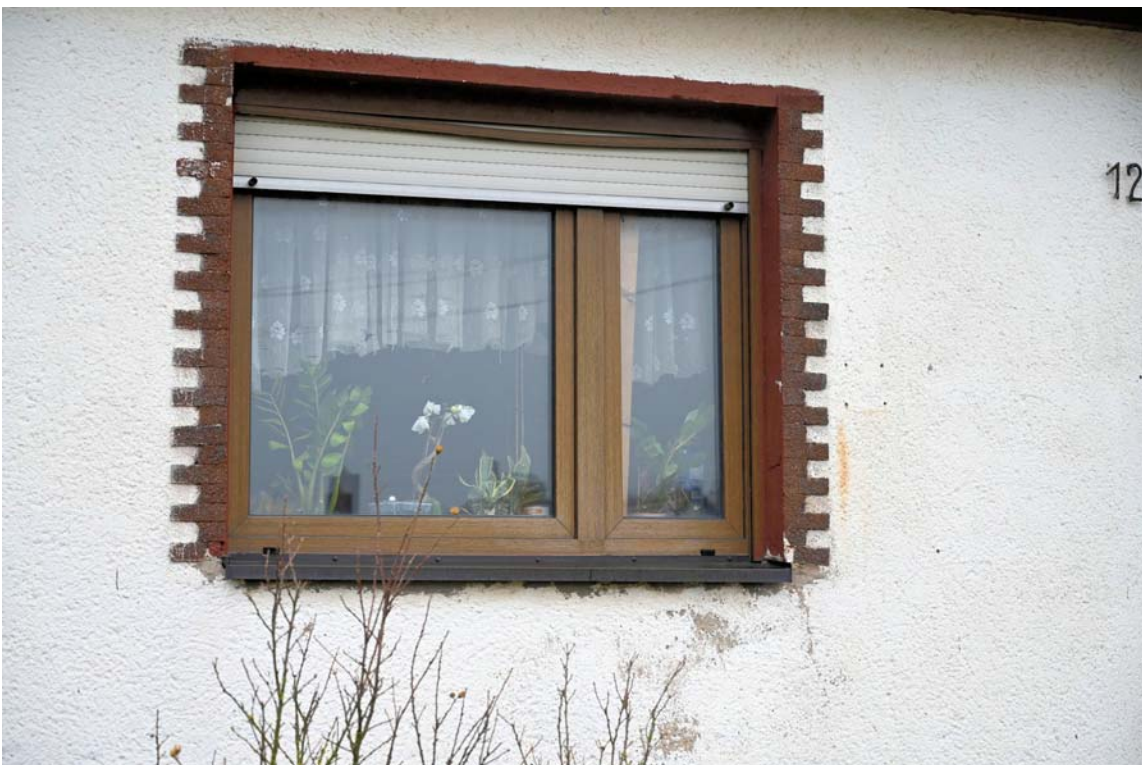
Abb. 4: Gebäudeansicht, Detail Fenster Küche
