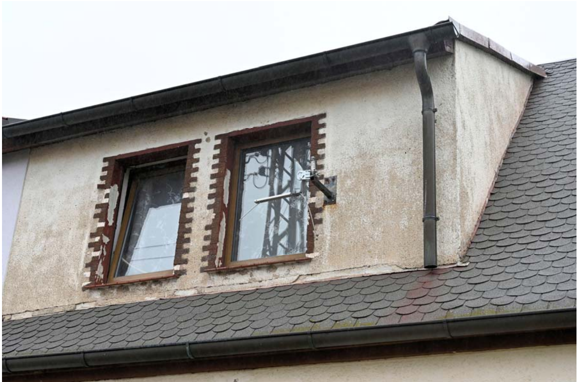
Abb. 5: Gebäudeansicht, Detail Gaupe
