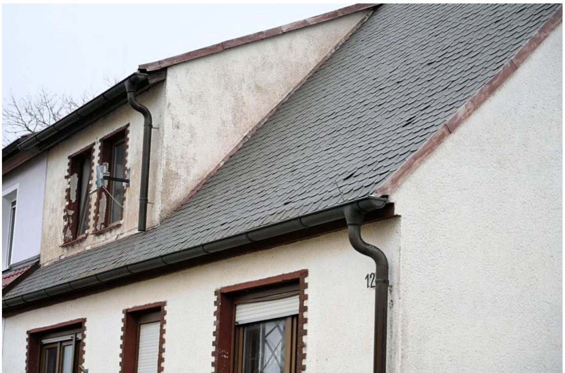
Abb. 6: Gebäudeansicht, Detail Dachgeschoss
