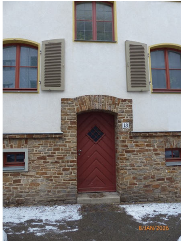
Foto 9: Hauseingang Slevogtstraße 18 (GE)
