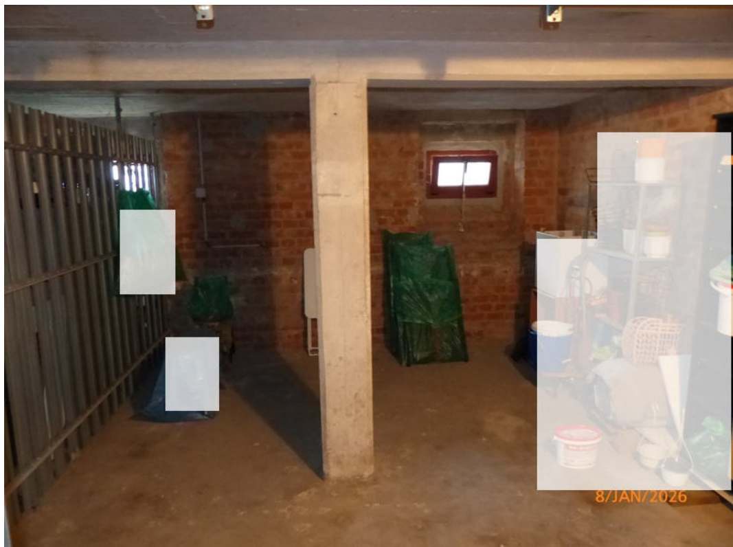
Foto 22: Blick in den Kellerabstellraum MKE 4 (GE)
