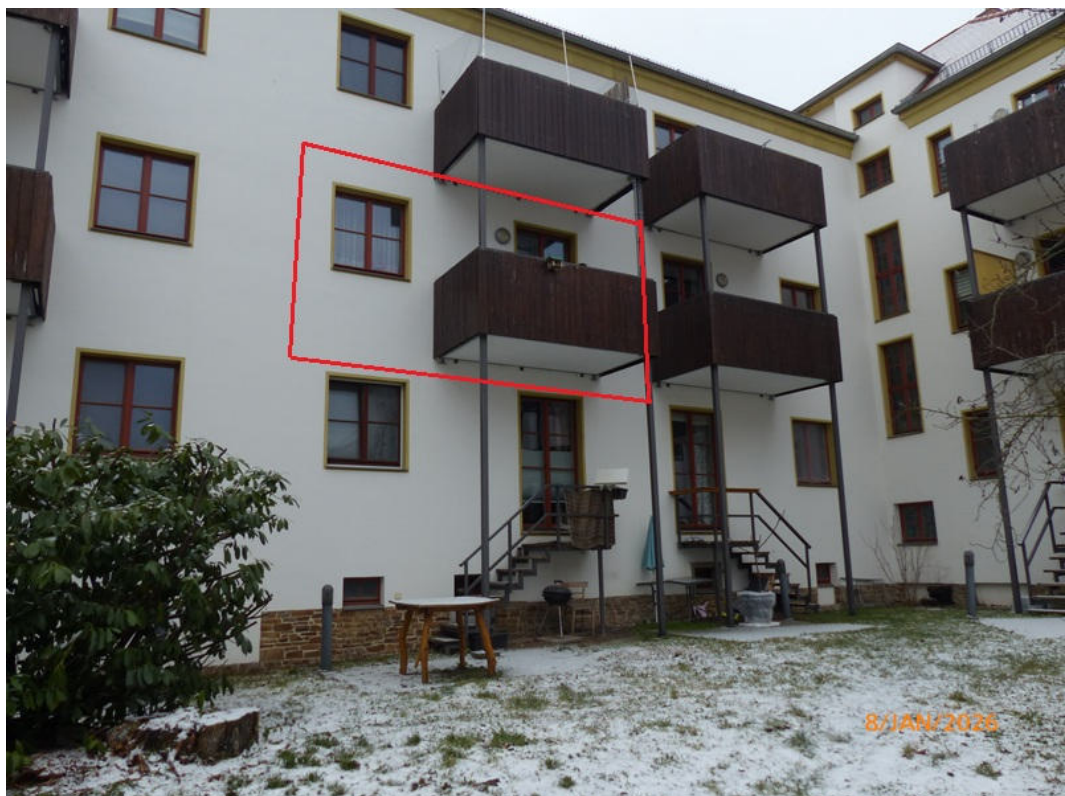
Foto 26: hofseitige Ansicht Slevogtstraße 18, WE Nr. 38 (GE)
