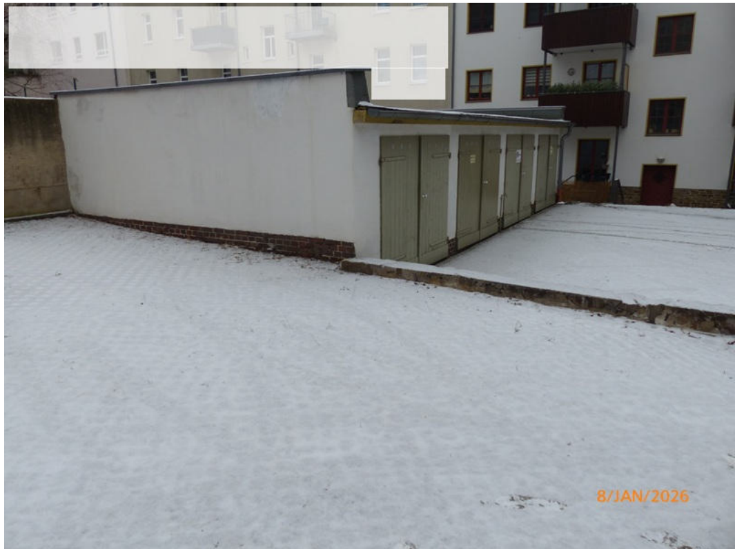
Fotos 27 und 28: Pkw-Abstellplätze mit Sondernutzungsrecht (SNR) in der Garage und im Freien (GE)
