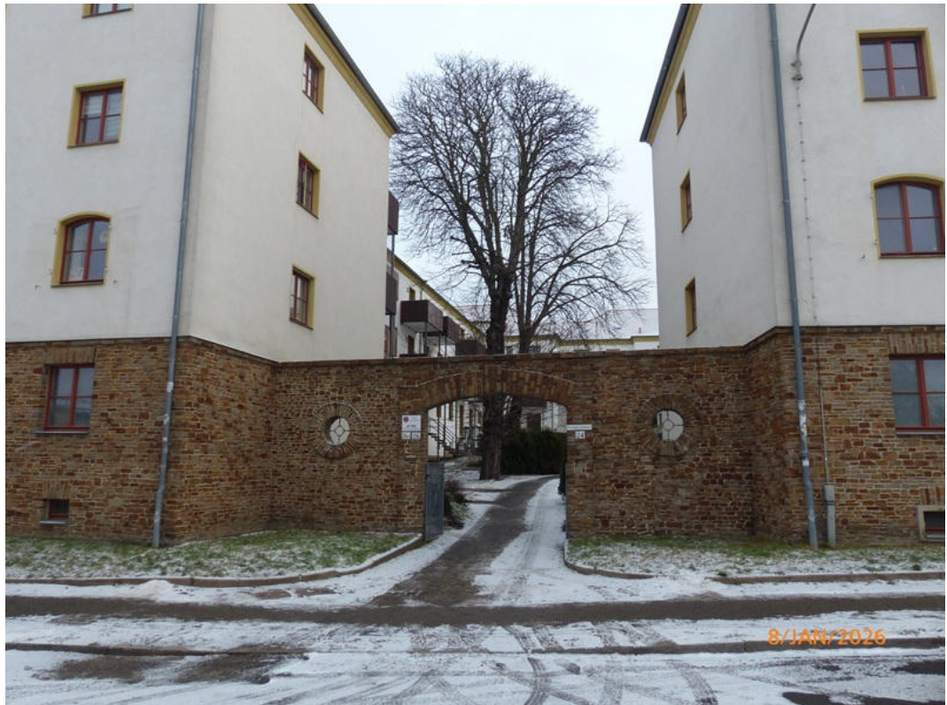
Fotos 7 und 8: Hofeinfahrt in der Bucksdorffstraße (GE)
