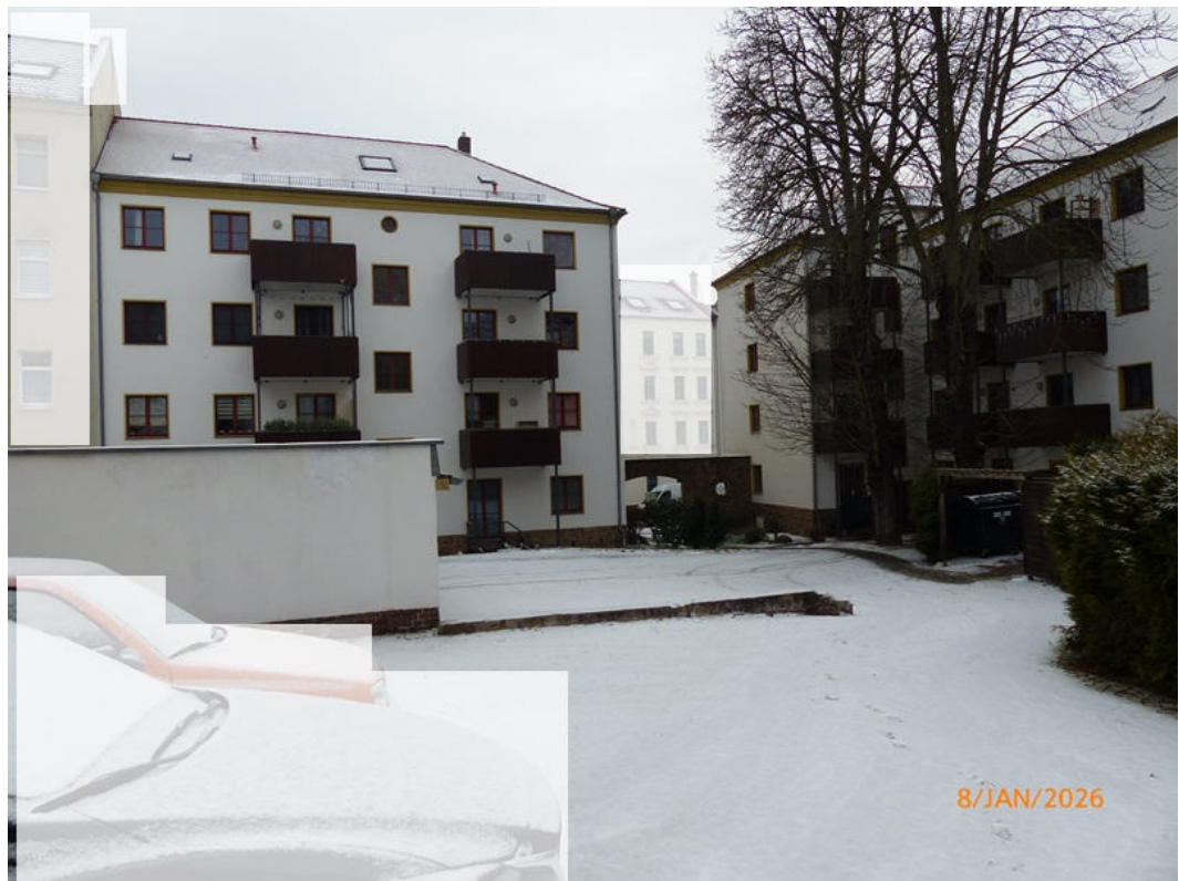
Foto 25: Hof der Wohnanlage – Blickrichtung Süden (GE)
