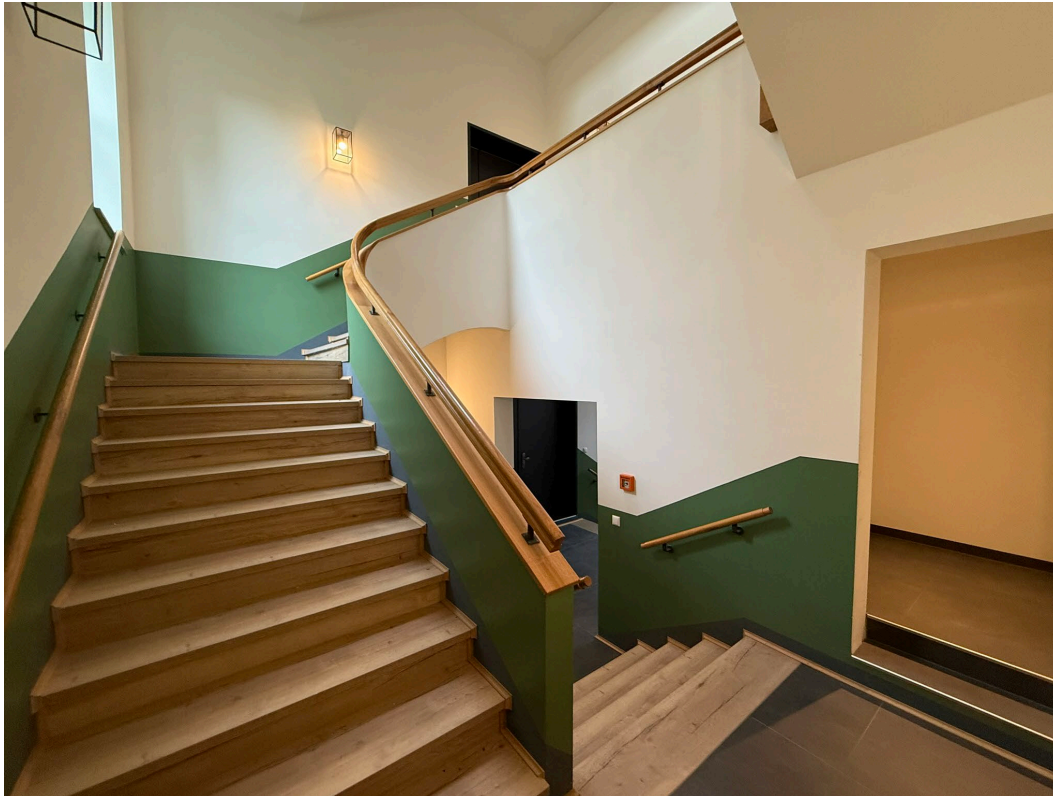
Treppenhaus im Bereich des Zwischengeschosses (Gemeinschaftseigentum)
