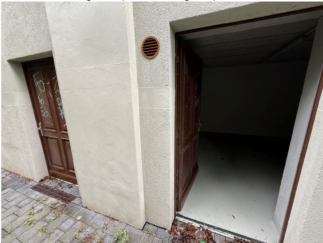
Zugang zum Mülltonnenraum (Gemeinschaftseigentum)
