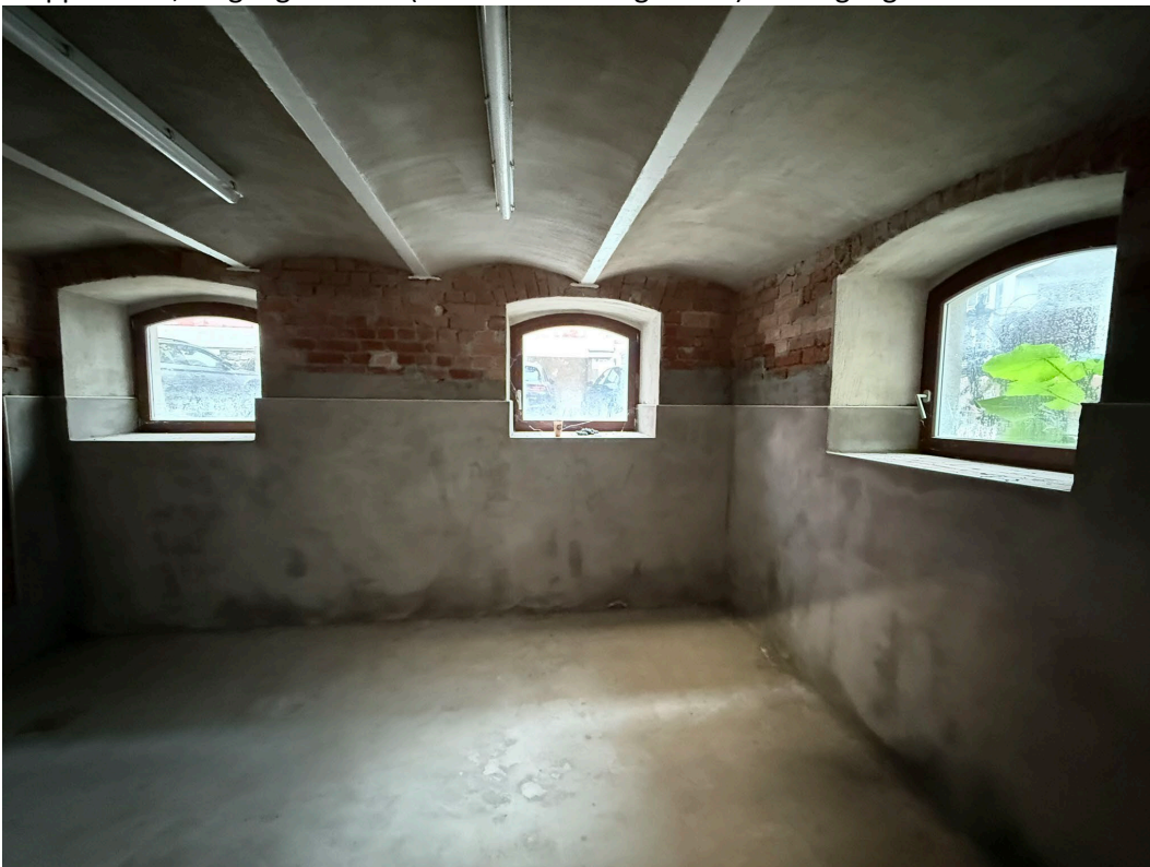
Lagerraum Nr. 1 im Kellergeschoss
