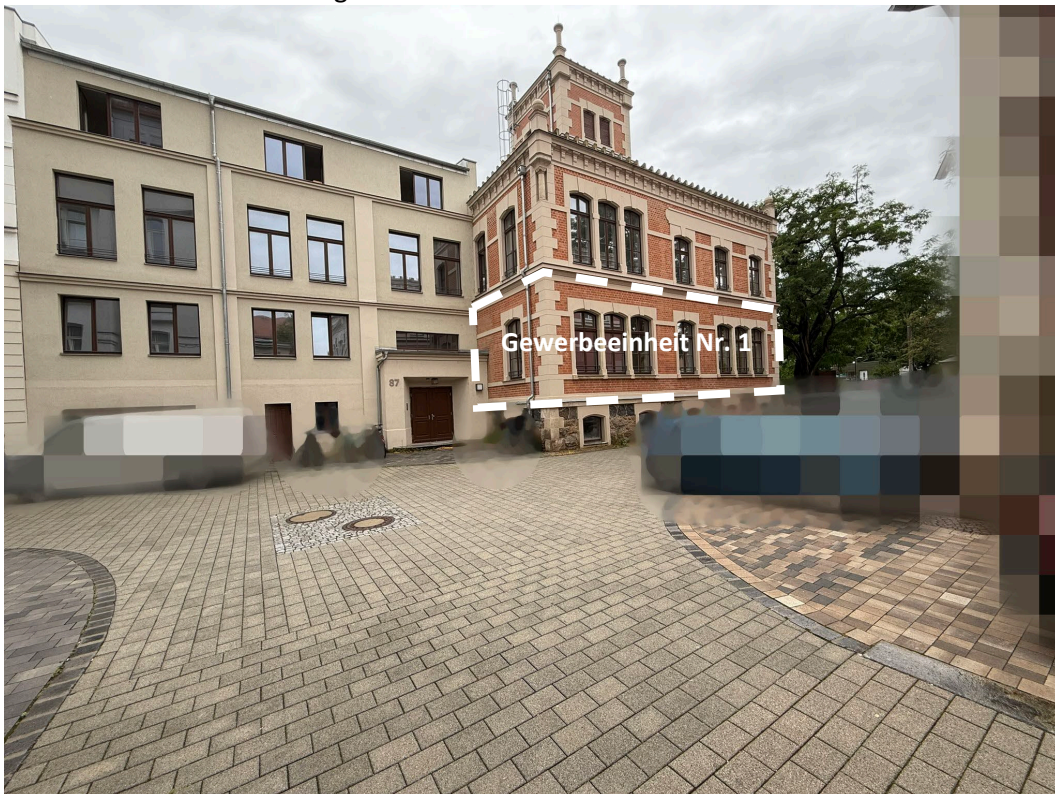
Blick aus nördlicher Richtung
